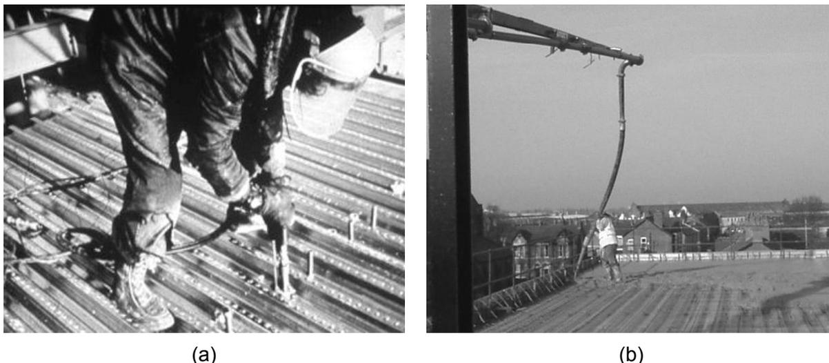
Figura 2.13 - Aplicação de laje mista: (a) conector de cisalhamento *stud bolt*; (b) concretagem
