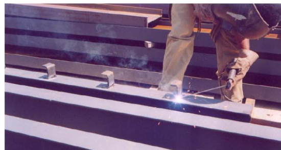
Figura 2.35 – Soldagem de conectores em perfil U formado a frio Fonte: Veríssimo (2007)
