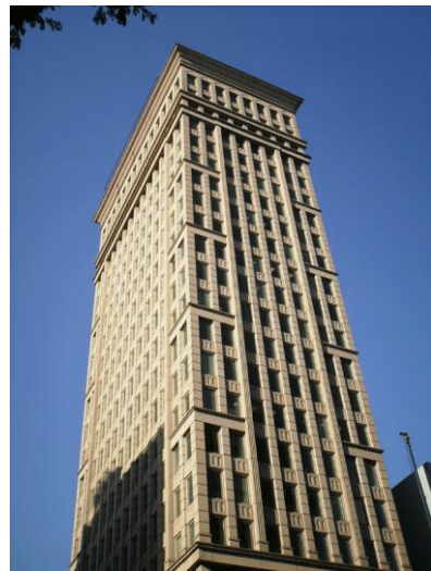
Figura 2.9 – Edifício San Paolo finalizado. Fonte: http://www.buildings.com.br
