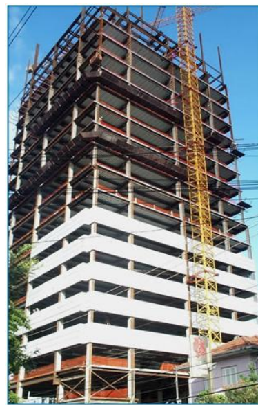
Figura 2.46 – Construção do edifício Fonte: http://www.codeme.com.br
