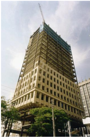
Figura 2.8 – Edifício San Paolo em fase de construção. Fonte: http://www.lmc.ep.usp.br/people/valdir
