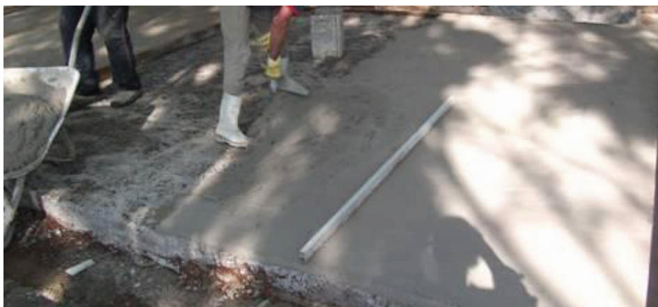
Figura 37 - Regularização do Quadro II com argamassa mista.
