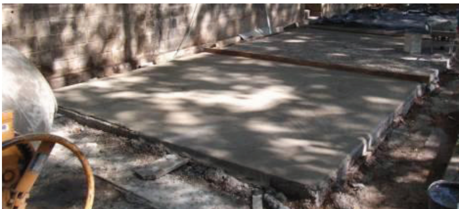
Figura 36 - Regularização no Quadro III.
