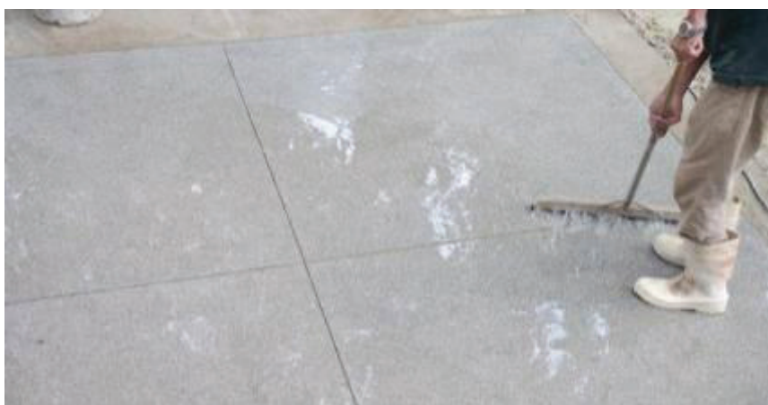
Figura 51 - Lavagem do Quadro III após o último polimento.
