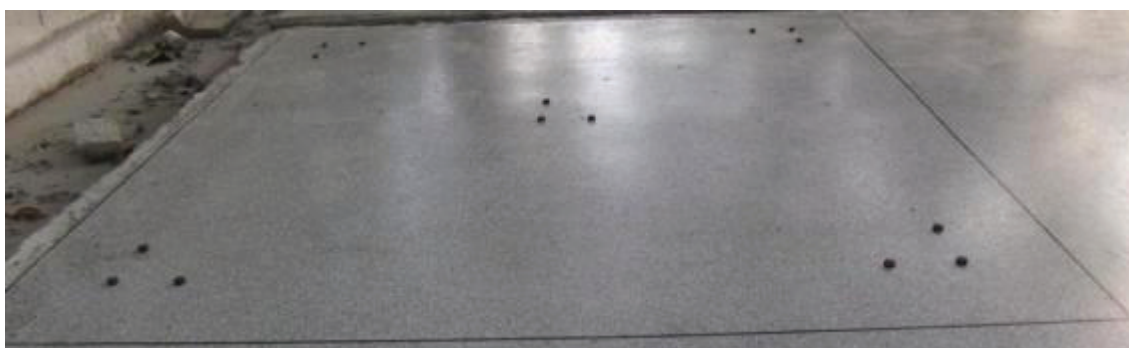
Figura 55 - Quadro III (4) instrumentado para leitura de deformações.
