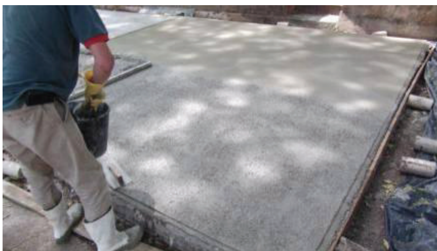
Figura 42 - Aspergimento de água sobre o granilite fresco.
