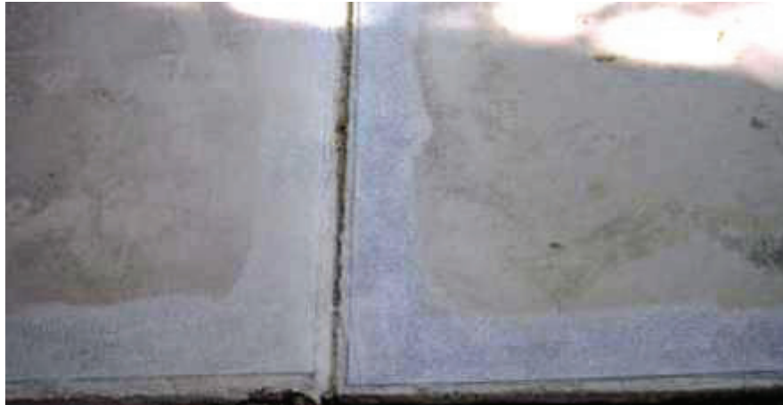
Figura 49 - Detalhe de cantos do revestimento em granilite após polimento com lixadeira – lixa nº 60.
