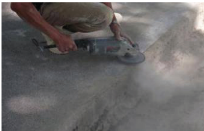
Figura 47 - Polimento de canto com lixadeira – lixa nº 24.
