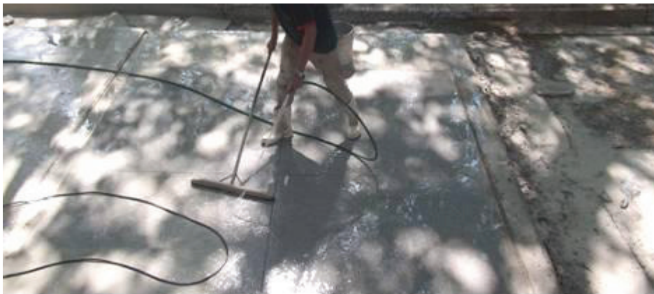
Figura 46 - Lavagem do revestimento após os primeiros polimentos com politriz.
