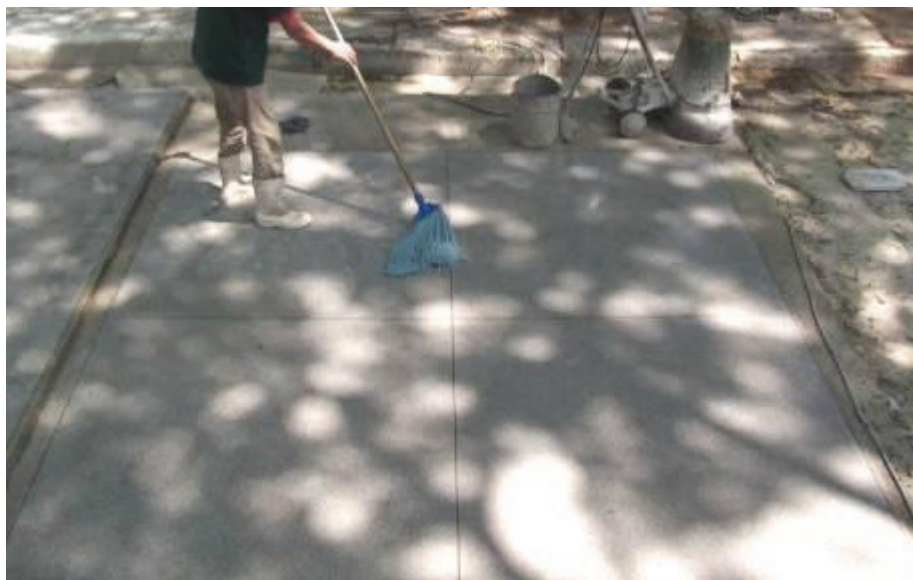
Figura 52 - Procedimento de aplicação do selador e da cera no revestimento em granilite.
