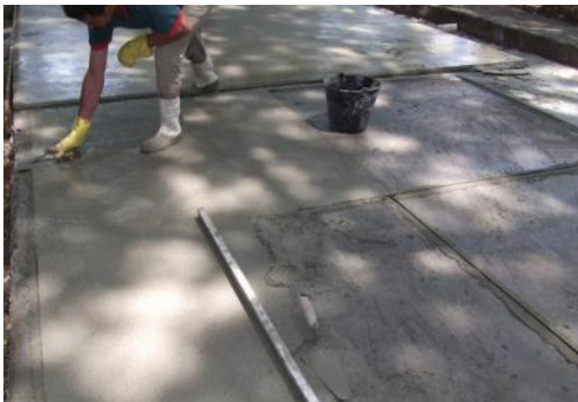
Figura 43 - Acabamento do granilite com desempenadeira de aço.
