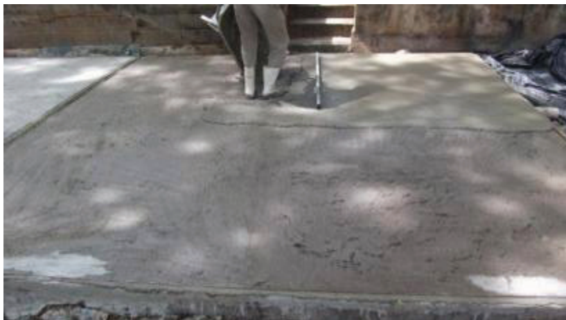
Figura 41 - Moldagem do Quadro I com granilite.
