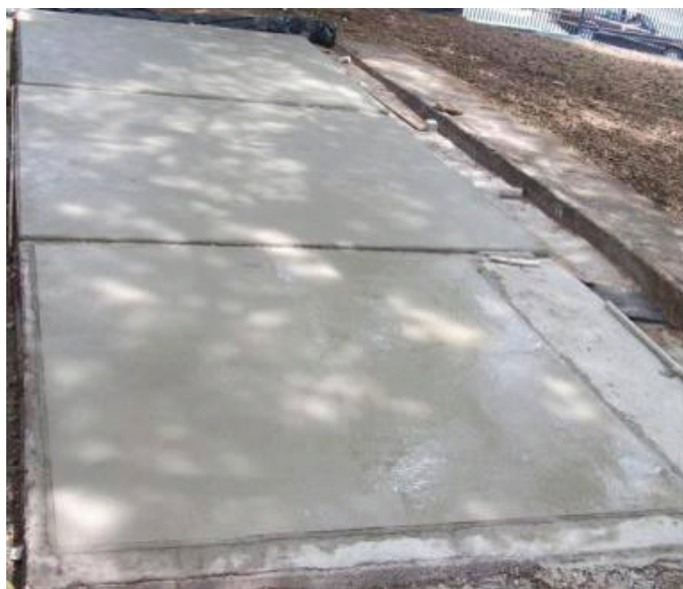
Figura 44 - Quadros moldados com granilite (estado fresco).
