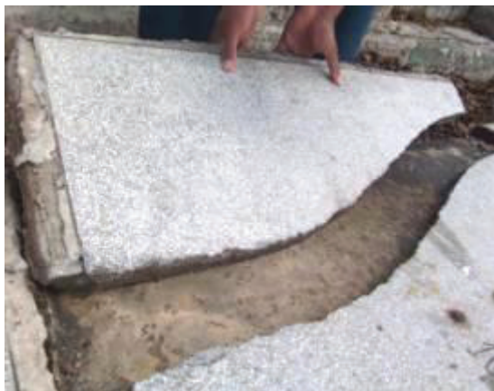
Figura 63 - Placa do Quadro I sendo retirada.
