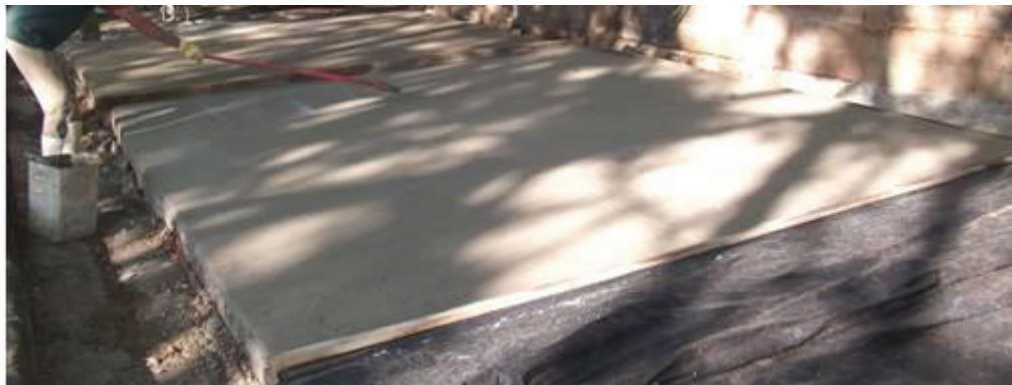
Figura 38 - Finalização da regularização no Quadro II.
