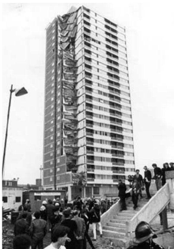
Figura 2.20 – Colapso de Ronan Point, Inglaterra, em 1968 (TAYLOR et.al., 2010)
