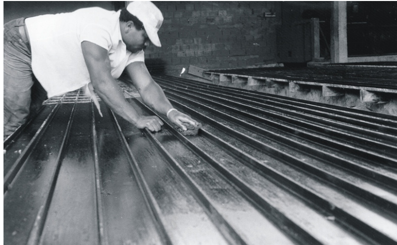
Figura 2.7 – Fôrma para vigota recebendo óleo anti-aderente ( Manual de Fabricação das lajes PUMA, 2003)
