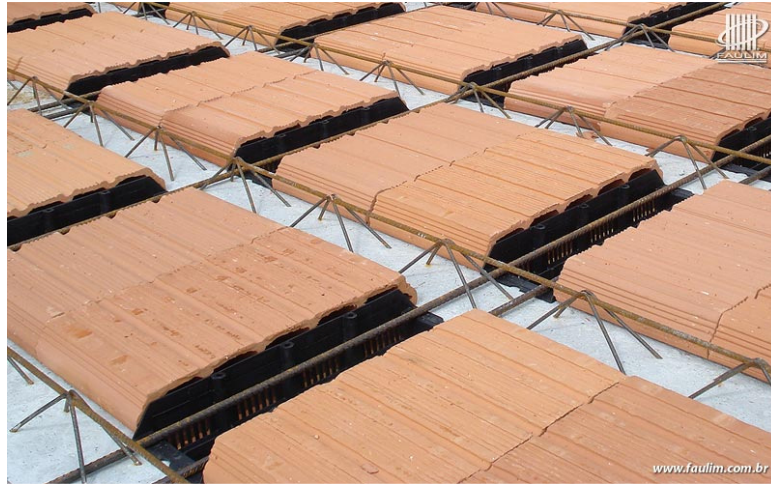
Figura 2.10 - Canaleta para nervuras transversais construtivas na laje ( www.faulim.com.br/canaleta )
