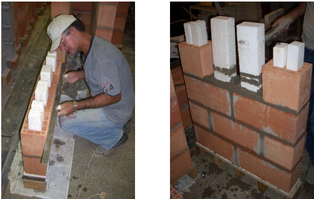
Figura 3.37 – Execução das pequenas paredes da 3ª série utilizando isopor
