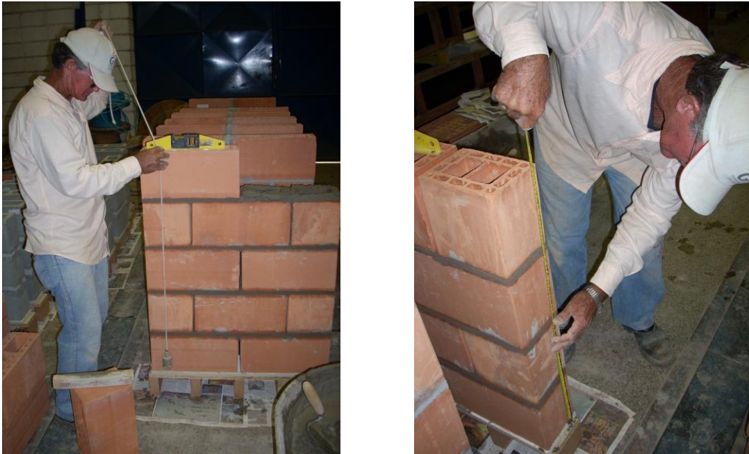
Figura 3.35 – Procedimento de execução das paredes
