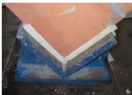
Figura 3.38 – Detalhe do uso do forro no contato entre a parede e o suporte metálico
