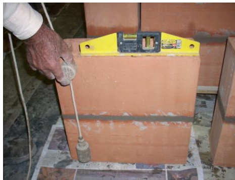
Figura 3.36 – Cuidados e verificações na execução dos prismas
