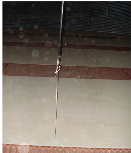
Figura 3.29 (a) e (b): Vinculação do cabo de termometria e a base do silo. Fonte: Grupo Kepler Weber (2011) 2
