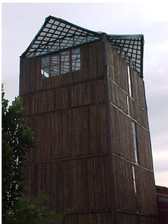
Figura 3.11 - Edifício de madeira construído para abrigar o silo-piloto (LaMEM)
