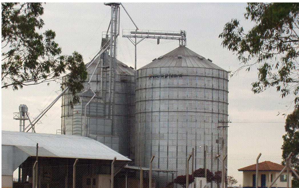
Figura 2.3: Silo com anéis enrijecedores
