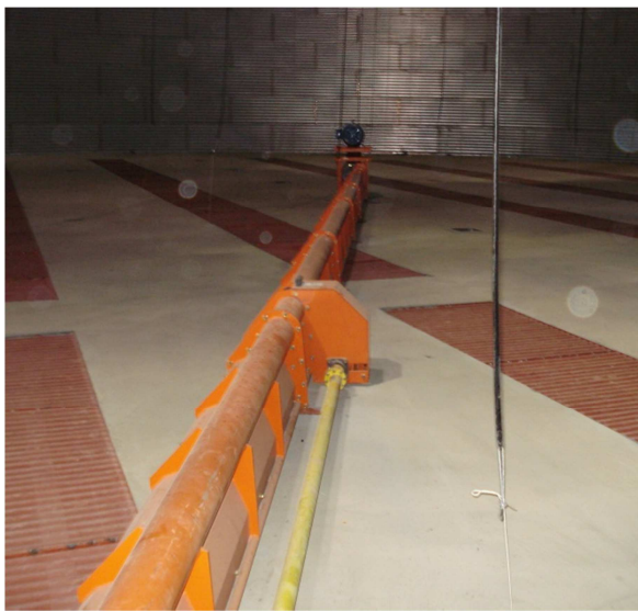
Figura 3.29 (a) e (b): Vinculação do cabo de termometria e a base do silo. Fonte: Grupo Kepler Weber (2011) 2
