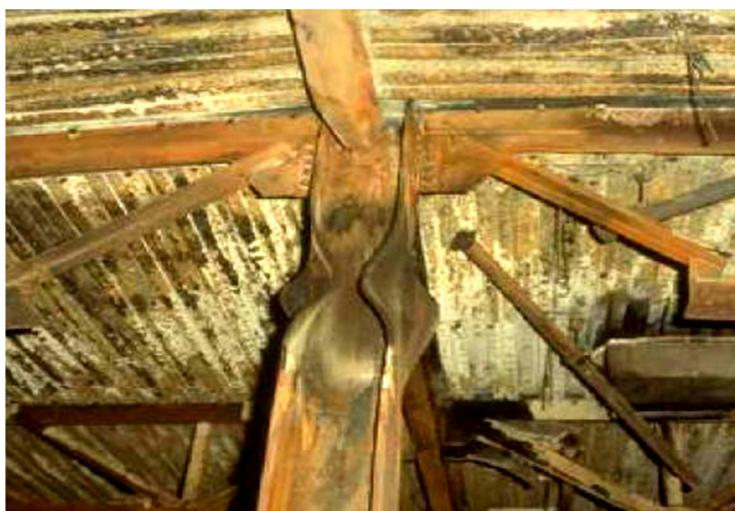
Figura 3. 5 - e Vigas deformadas após o incidente em Broadgate Fonte: 911.research.wtc7.net
