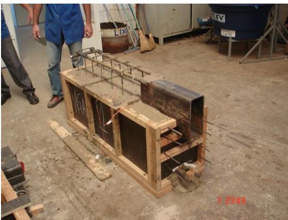
Viga totalmente concretada.
