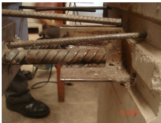
Solda da armadura positiva da viga nas cantoneiras.
