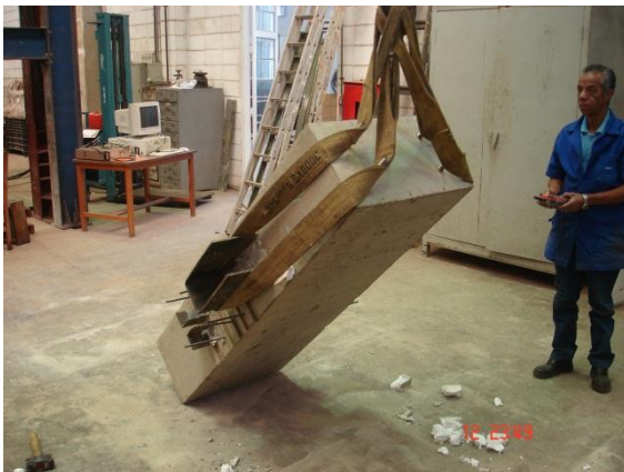
Íçamento do pilar.
