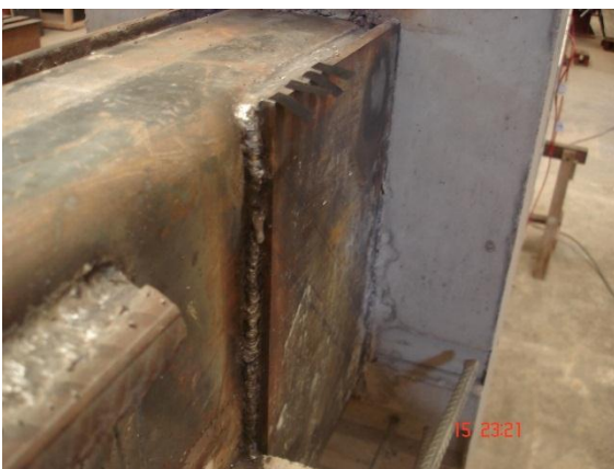
Detalhe da solda entre os perfis das vigas e pilar.
