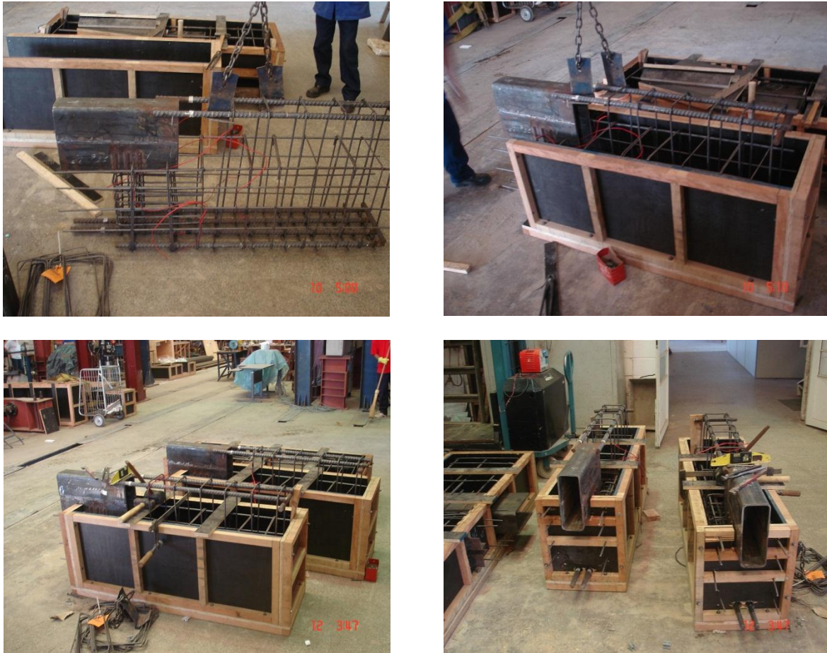
Figura 3.18 – Encaixe da armadura das vigas nas formas.
