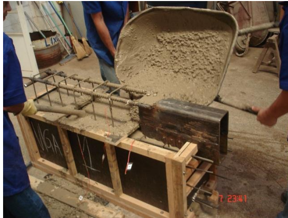
Concretagem da viga 1.
