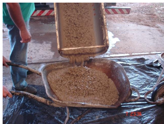
Aspecto do concreto.
