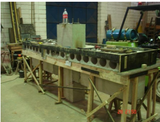
Escoramento dos painéis e forma da capa da laje.
