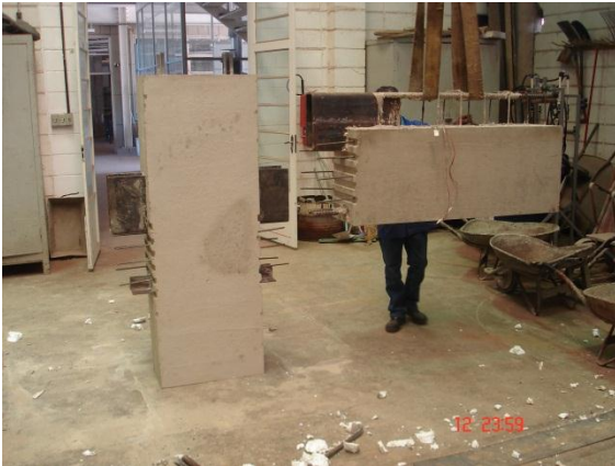
Içamento de uma das vigas.
