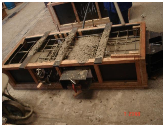
Concretagem do pilar.
