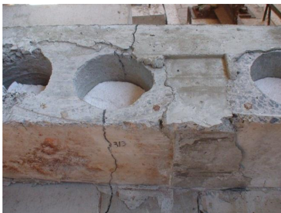
Figura 4.11 – Fissuração da superfície inferior da laje durante o ensaio da primeira etapa.
