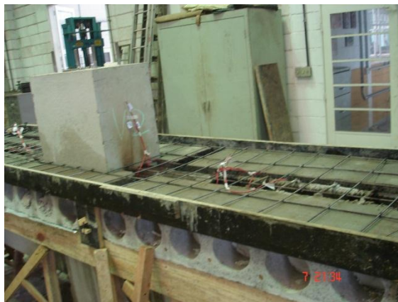
Armação da capa da laje.
