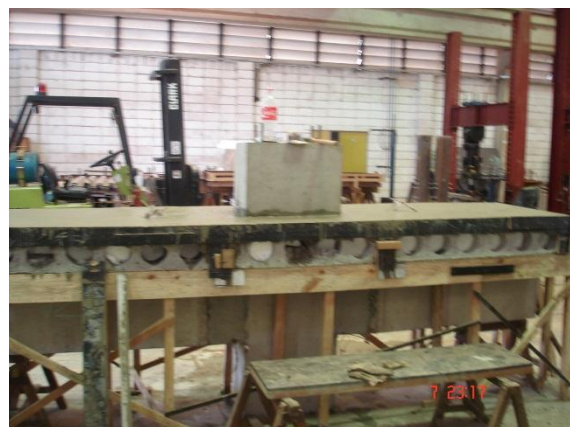
Laje completamente concretada.
