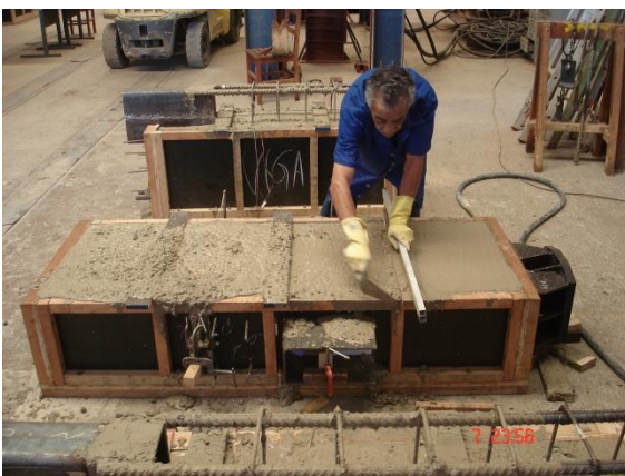
Acabamento na face do pilar.
