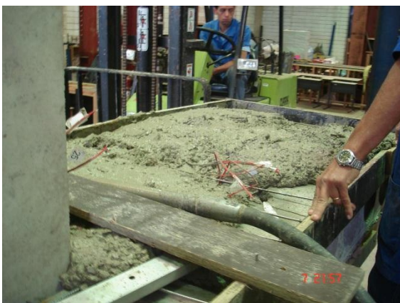
Concretagem da capa da laje.
