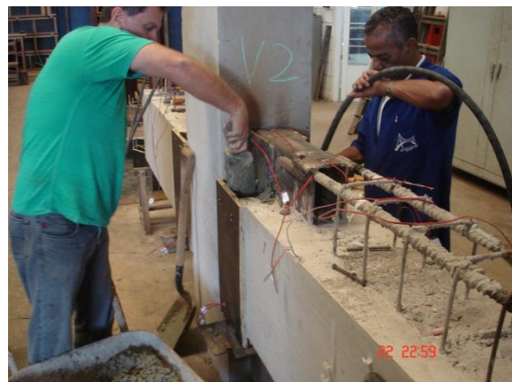
Concretagem das ligações.
