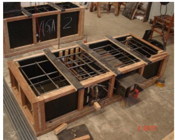
Figura 3.17 – Encaixe da armadura do pilar na forma.
