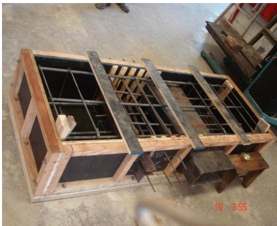
Figura 3.17 – Encaixe da armadura do pilar na forma.
