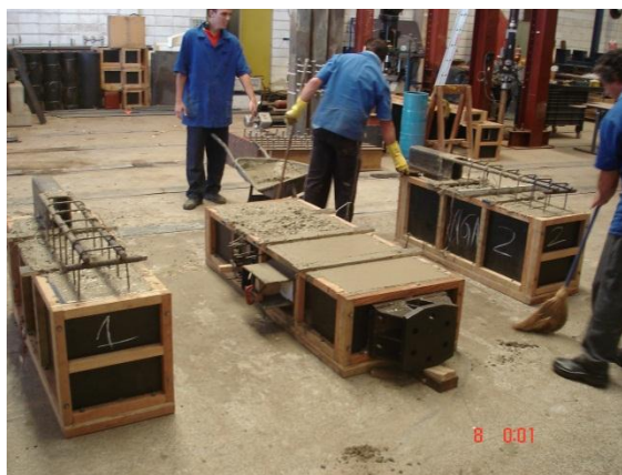
Elementos completamente concretados.
