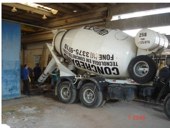
Fornecimento do concreto.
