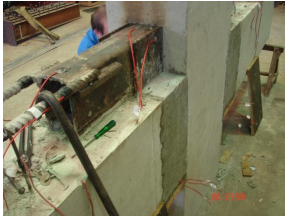
Aspecto do concreto da ligação após a desforma.
