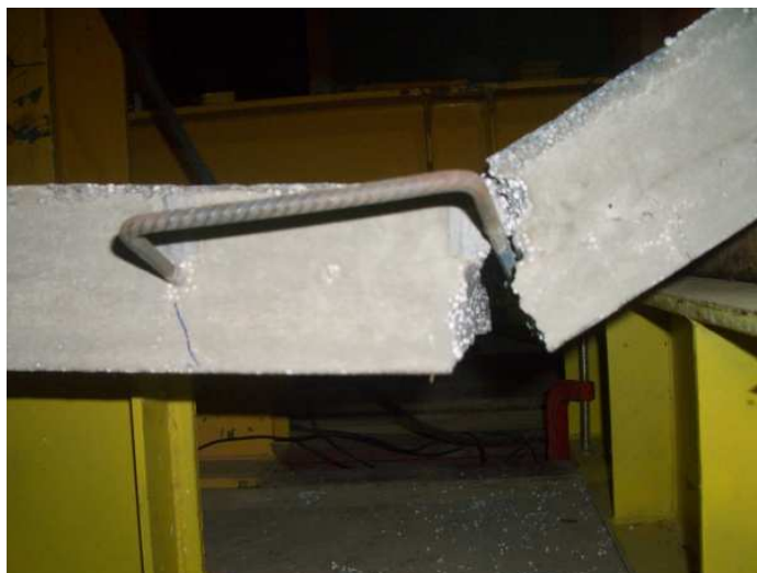
Figura 5.9 – Detalhe da ruína do modelo L 1 A na alça de içamento.
