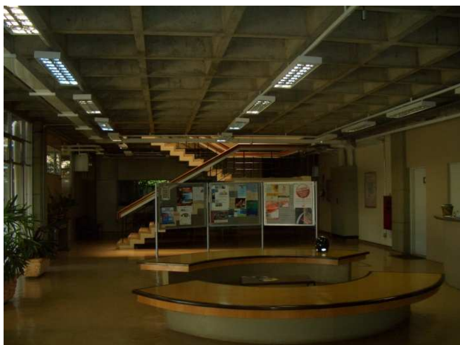
Figura 4.3 – Laje nervurada do Departamento de Engenharia de Estruturas da EESC - USP.
