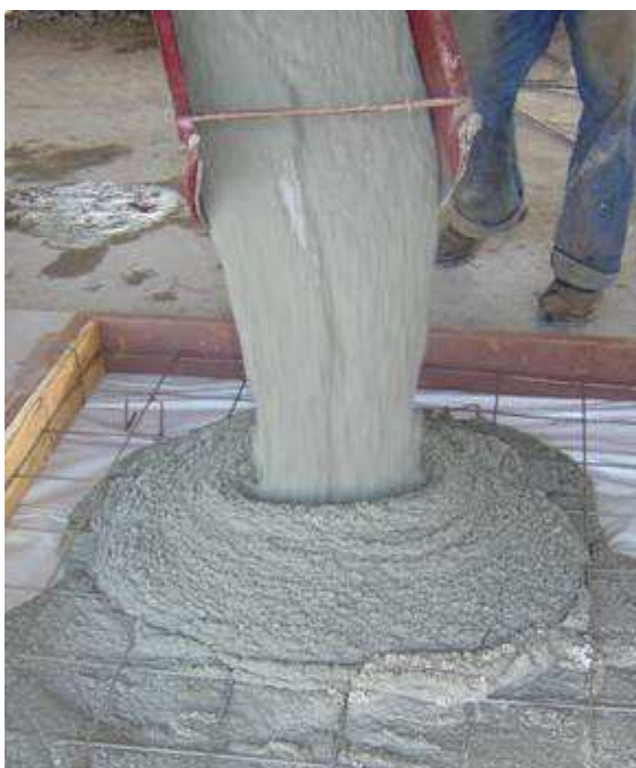
Figura 7.1 – Moldagem de laje de Concreto Leve com EPS. (KERBAUY, 2011)
