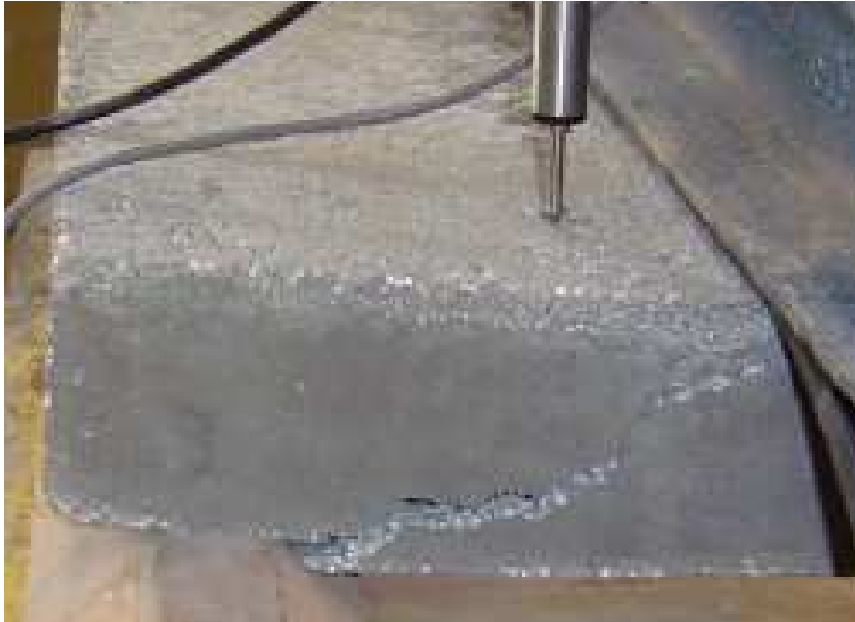
Figura 5.23 – Ruína do modelo L 3 A por ação da força cortante na face frontal.
