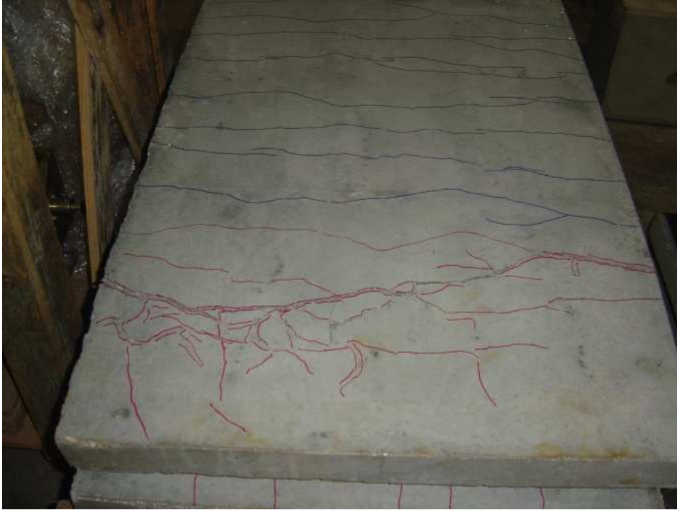
Figura Ap.3 – Ruína do modelo L 3 C PU inclinada entre o carregamento e o apoio.
