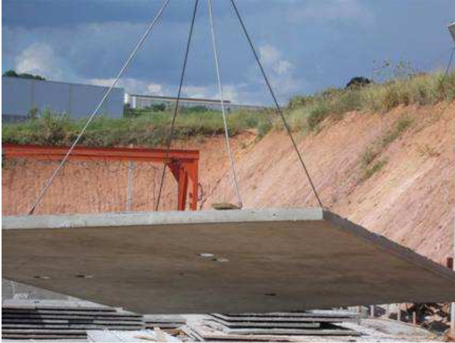
Figura 1.1 – Laje de Concreto Leve com EPS durante içamento. (KERBAUY, 2011)
