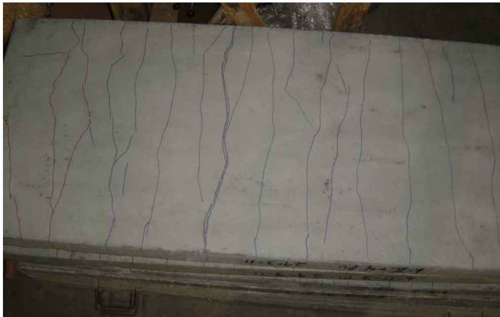
Figura Ap.8 – Fissuras de momento fletor e de escorregamento das barras do modelo L 3 D PU.
