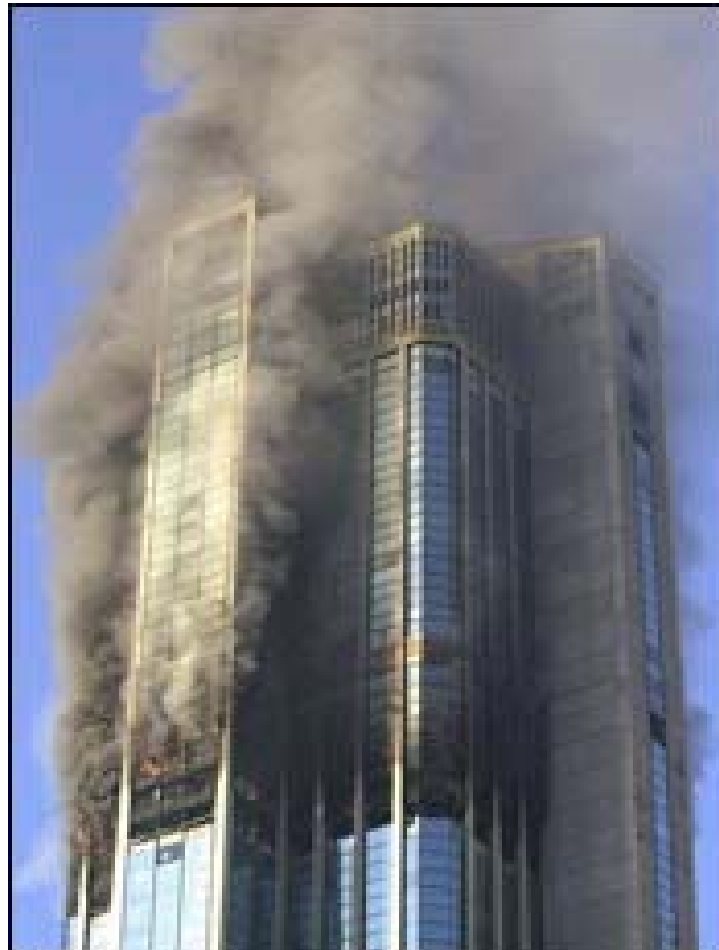
Figura 2.1 – Edifício alto de escritórios com 56 andares em Caracas sob incêndio Fonte: http://www.serendipity.li/wot/other_fires/other_fires.htm (acessado em 2010)
