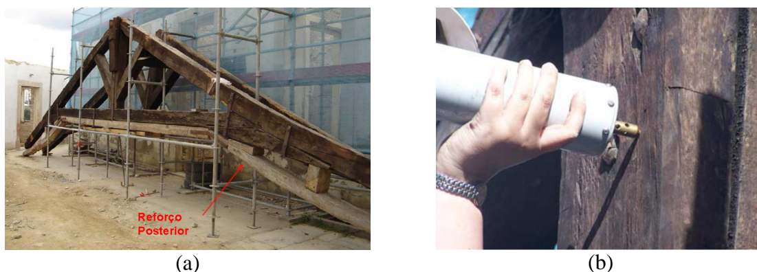
Figura 2.4 – Ensaio de micro-perfuração em treliça de edificação antiga: a) treliças inspecionadas; b) Ensaio de micro-perfuração.
