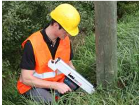
Figura 2.3 – Ensaio de micro-perfuração na zona de afloramento de um poste.
