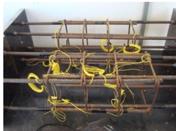
(b) Armadura instrumentada
