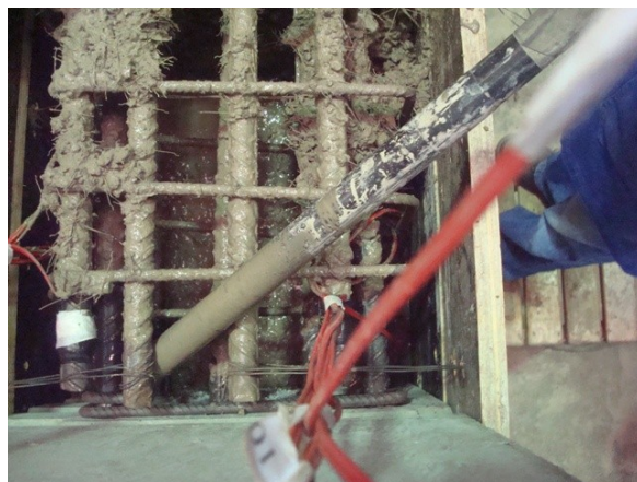
(e) Concretagem e adensamento
