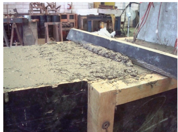
(f) Regularização da superfície
