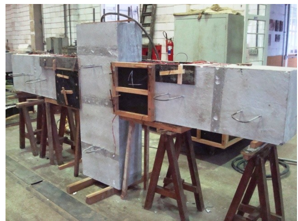
(d) Instalação das fôrmas
