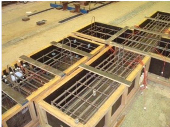
(a) Armaduras dentro das fôrmas dos modelos monolítico e de concreto pré-moldado
