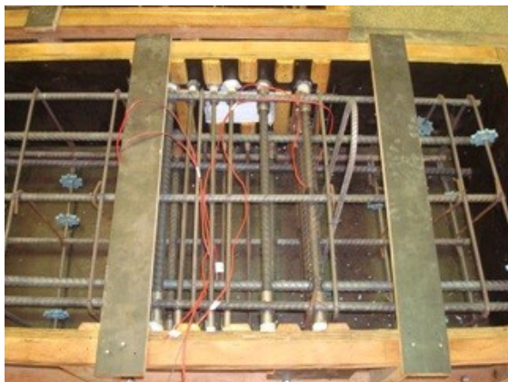
(c) Armadura do modelo de concreto pré-moldado na região chaveada.
