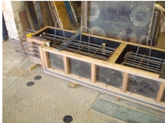
(b) Aspecto da parte da armadura longitudinal saliente.
