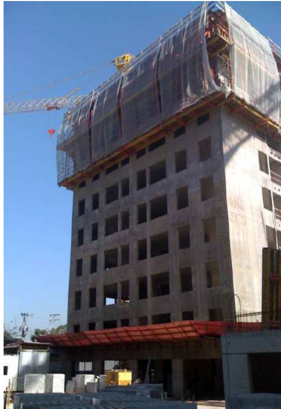
Figura 1-1 - Execução de edifício de parede de concreto armado (FONSECA JUNIOR-2009).
