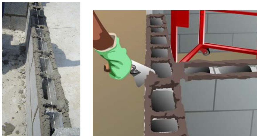
Figura 2.6 – Argamassamento total. (RAMALHO, 2009), ( http://www.selectablocos.com.br/ )
