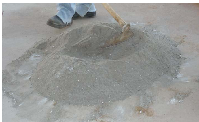
Figura 3.12 – Confeção da argamassa de forma manual
