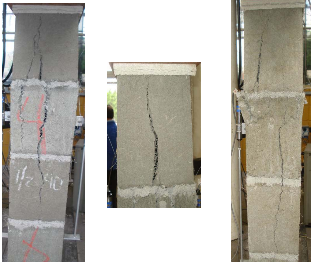
Figura 4.14: Fissuras verticais ao longo dos septos laterais
