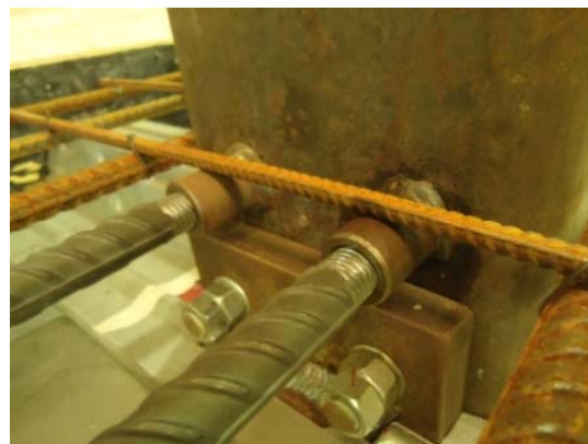
(b) Armadura de continuidade do Modelo 2 fixada com luvas.
