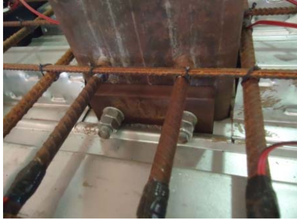
(b) Armadura de continuidade do Modelo 1 fixada com luvas.
