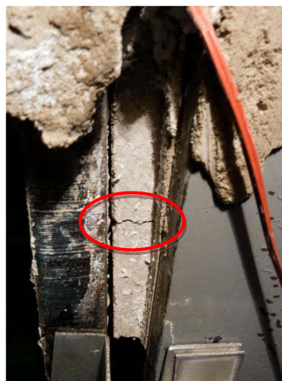
(b) Graute entre o consolo e a viga.
