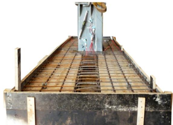
(c) Modelo pronto para concretagem da capa.
