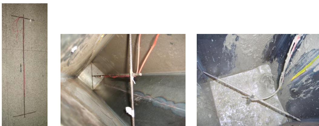
Figura 3.29 – Dispositivo para instrumentação do núcleo de concreto.
