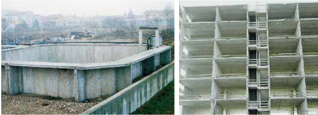
Figura 2.23: a) Paredes de lajes alveolares de um tanque de tratamento de água; b) Pisos e paredes estruturais alveolares em um edifício residencial de múltiplos pavimentos. [ASSAP (2002)]
