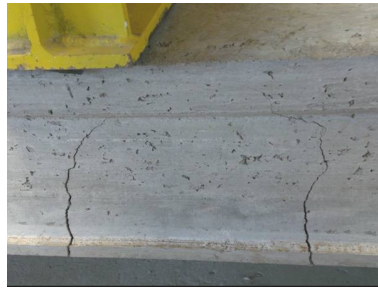
Figura 6.38: Fissuração da laje L11-S-21-7D9,5-W_F, vão de 4 m, submetida ao ensaio de flexão.
