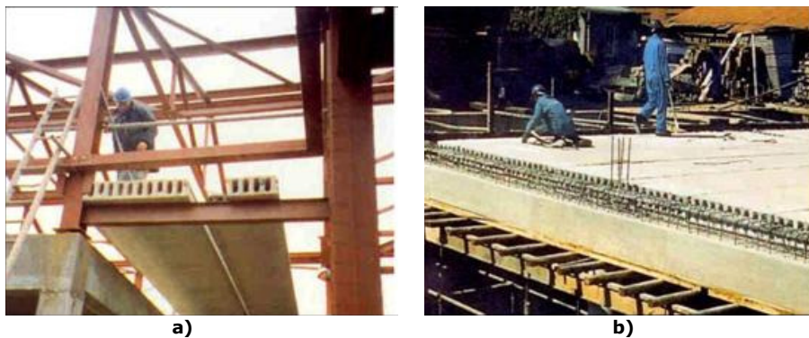
Figura 2.20: a) Lajes alveolares sobre estrutura metálica (UK); b) Lajes alveolares sobre concreto moldado no local (África do Sul, 2001). [Elliott (2005)]
