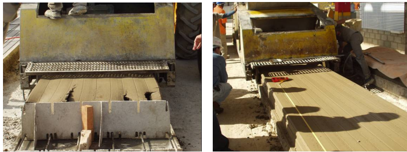
Figura 2.8: Moldagem das unidades alveolares.
