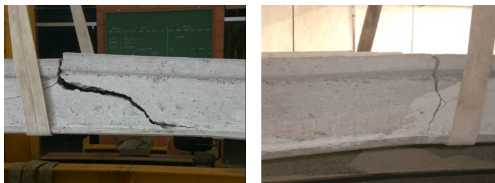
Figura 6.29: Fissuração da laje L27-S-26-9D12,7-W_C. a) Face oposta; b) Face frontal.
