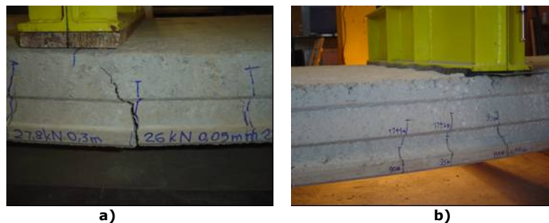
Figura 6.33: a) Fissuração da região central da laje L2-S-15-6D9,5-X_F; b) Fissuração da região central da laje L4-S-20-8D12,7-X_F.
