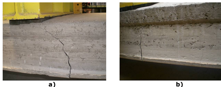
Figura 6.25: Fissuração da laje L20-S-21-7D9,5-W_C. a) Face oposta; b) Face frontal.
