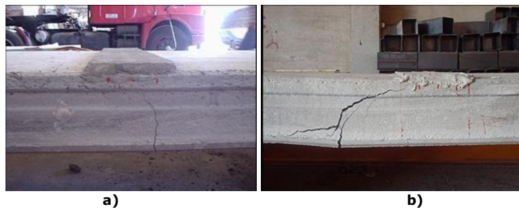
Figura 6.35: Configuração de fissuração para laje de 3 m de vão, submetida a ensaio de flexão. a) Fissuração da face oposta; b) Fissuração da face frontal.
