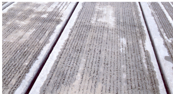
Figura 2.19: Superfície rugosa em lajes alveolares. [Elliott (2005)]
