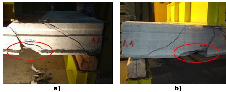
Figura 6.6: Configuração de fissuração da laje L5-S-20-6D12,7-Y_C. a) Fissuração da face oposta; b) Fissuração da face frontal.
