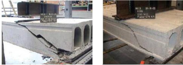
Figura 4.31: Exemplos de fissuras no colapso. [Bertagnoli & Mancini (2009)]
