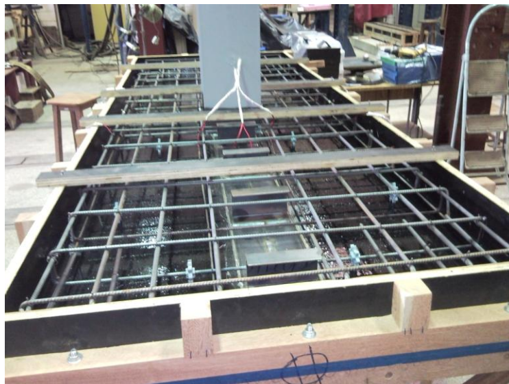
Figura 3.15- Posicionamento das armaduras na fôrma
