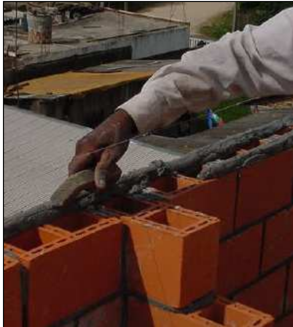
Figura 2.5 - Argamassa para assentamento dos blocos
