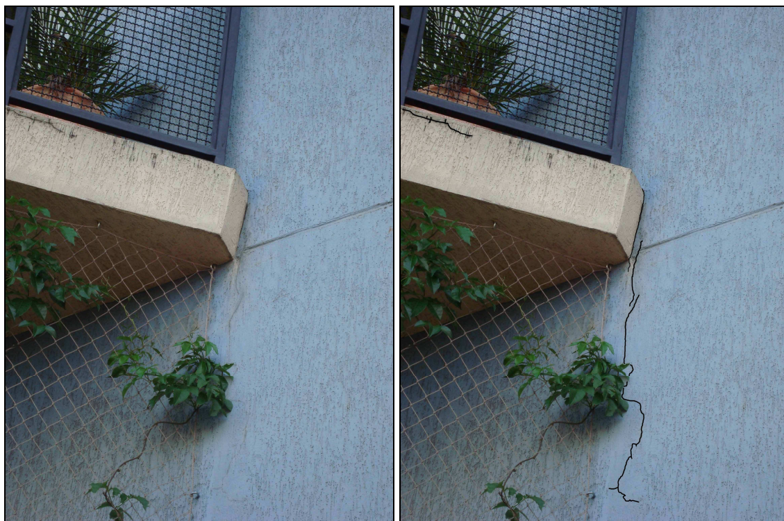
Figura 3.15 - Fissura causada pelo carregamento de uma laje de sacada.
