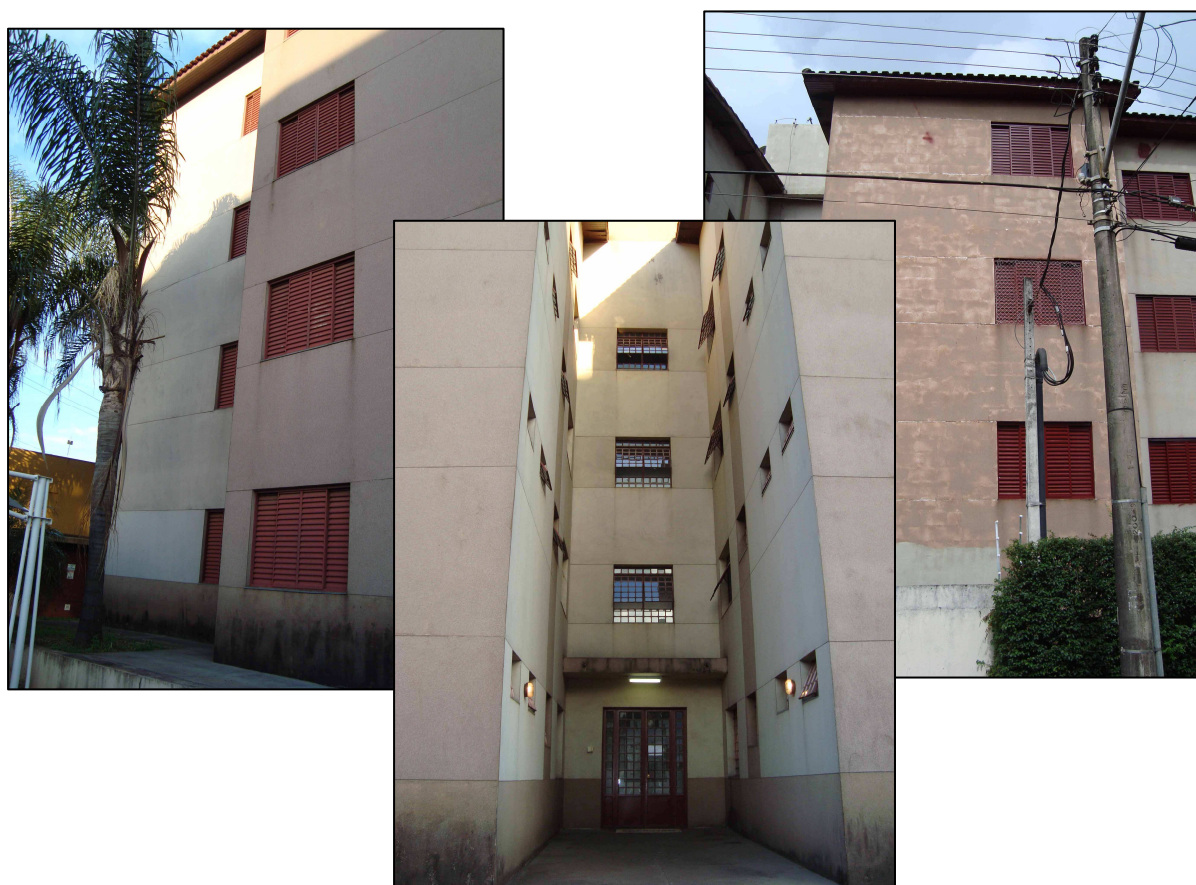
Figura 3.1 - Fachadas frontal e laterais do Edifício A
