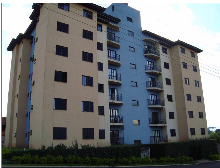
Figura 3.10 - Fachada frontal do Edifício B.
