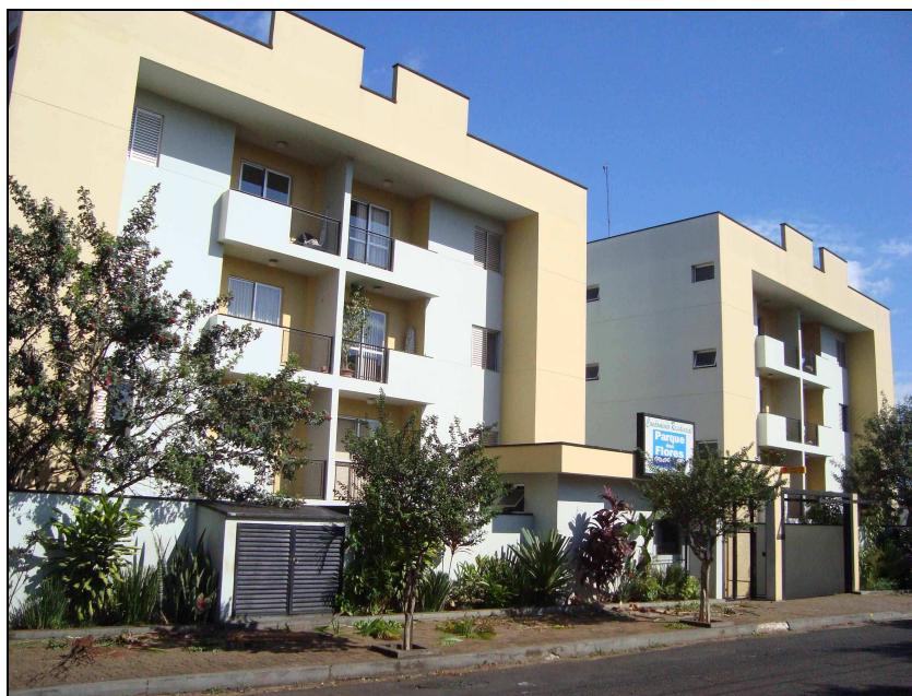
Figura 3.31 - Fachada frontal do Edifício E.
