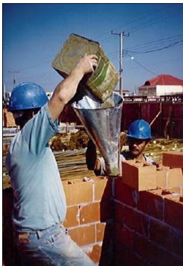
Figura 2.6 - Execução de grauteamento. Fonte: Roman
