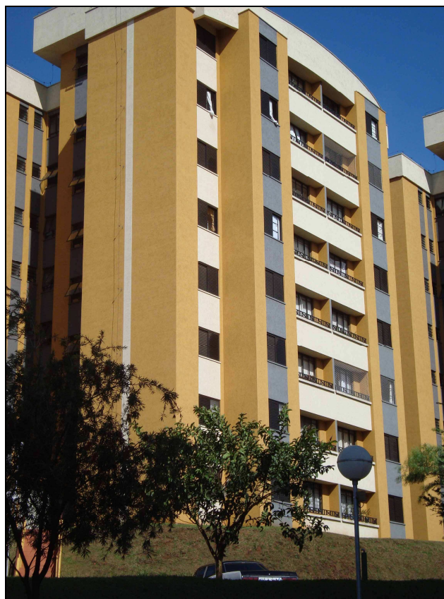
Figura 3.26 - Fachada frontal do Edifício D
