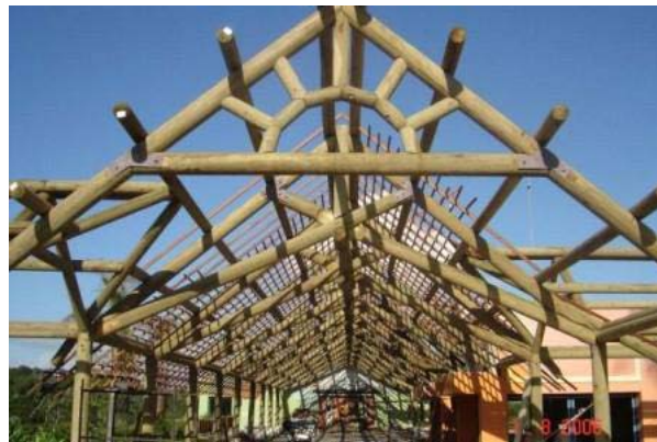
Pórtico rígido e treliças scissors.
