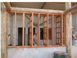
Fase final da construção.
