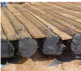
Instalação das armações. Detalhe de proteção dos topos.
