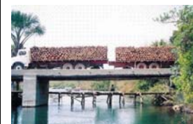
Prova de carga no vão maior com dois veículos.
