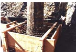
Detalhe das fundações.
