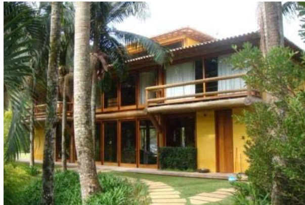
Fachada do fundo
