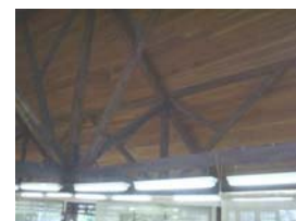
Sistemas de contraventamentos do galpão.
