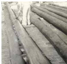
Montagem das vigas bi-circulares, com os anéis instalados.
