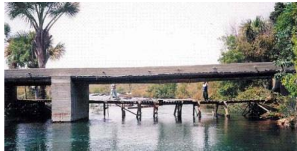
Vista da Ponte Batalha
