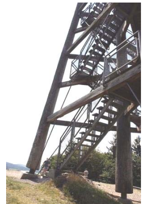
Colunas nas placas de base e nos blocos de fundações.
