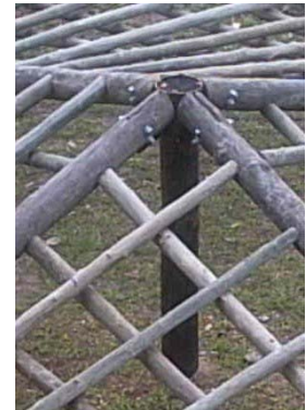
Fase de montagem da conexão central da cobertura. Tubo de aço, com esperas de chapas de aço inseridas internamente em corte na madeira e ligações com parafusos, arruelas e porcas.
