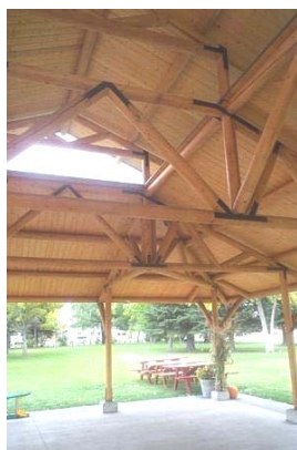
Estrutura da cobertura.
