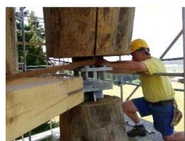
Montagem do sistema com conector metálico, unindo os vértices dos triângulos, na meia altura da torre.
