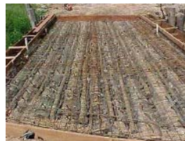
Tabuleiro de madeira roliça, instalação das armaduras.
