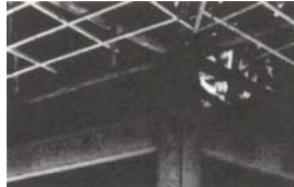
Apoio da estrutura portante sobre um dos postes principais
