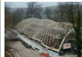
Fase de construção da estrutura laminar de grelha do galpão.
