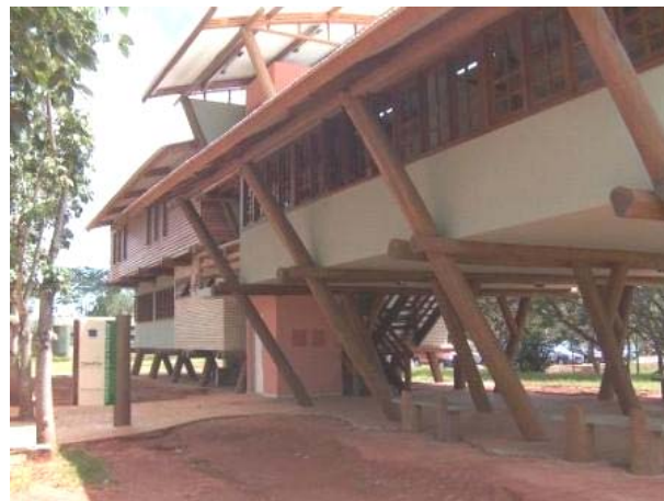
Estrutura com vigas duplas e colunas inclinadas.
