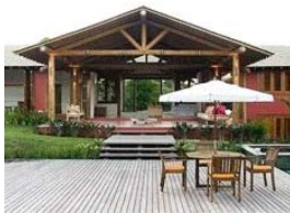
Vista frontal da estrutura da varanda de acesso à sala.
