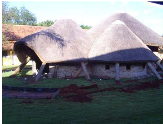
Fachada lateral direita do quiosque.
