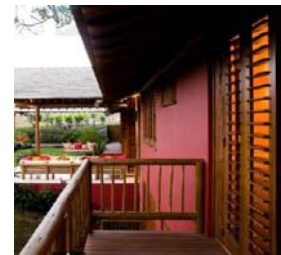
Estrutura do guarda corpo da sacada, com peças roliças de madeira de reflorestamento.
