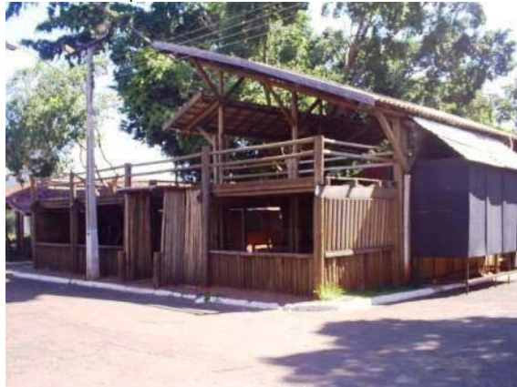
Fachada principal do salão de eventos.
