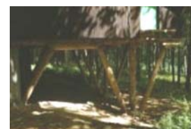
Estrutura do pilotis, com colunas V e montantes.
