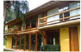
Estruturas das varandas em balanço.
