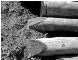
Preparação das estacas: bisele no pé das estacas.
