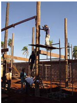
Içamento das colunas, com caminhão muque.
