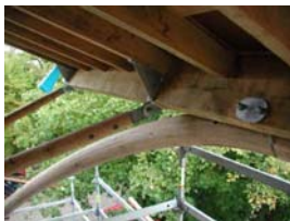
Vista lateral dos detalhes das escoras de madeira roliça de pequeno diâmetro, que suportam a estrutura da cobertura e do pórtico em arco inclinado da fachada principal.
