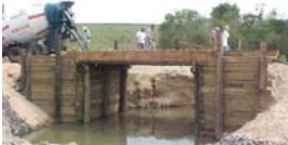
Concretagem do tabuleiro.
