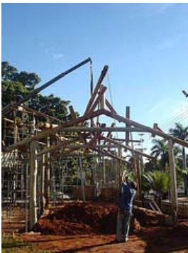
Estrutura da cobertura (cumeeira) do galpão.
