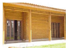
Estrutura da varanda.
