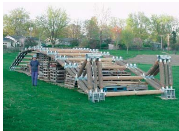
Primeniro a estrutura foi montada em terreno plano.
