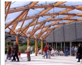
Detalhes da estrutura lamelar da cobertura em arco, e das colunas e escoras inclinadas em V definitivas de madeira roliça de pequeno diâmetro ao lado esquerdo da edificação.
