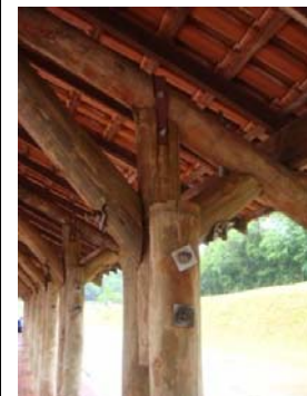
Conexões da estrutura da cobertura com a coluna de seção composta dupla.
