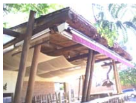
Coluna dupla inclinada.
