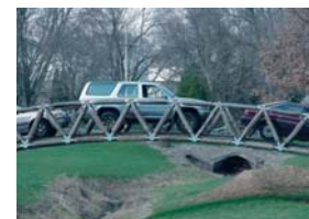
A passarela atende à capacidade de carga para veículos utilitários, conforme os resultados da análise.
