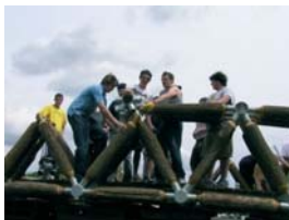
Os estudantes unem os seguimentos dos elementos estruturais (postes SDT) aos conectores especiais.
