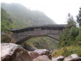
Vista geral da passarela. Ambos os lados da passarela, são revestidos com painéis de madeira de sobreposição, que tem a função de proteção da estrutura, contra intempéries, principalmente ocasionados pela chuva.
