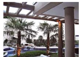
Pilares de concreto Armado: parte da estrutura da casa.
