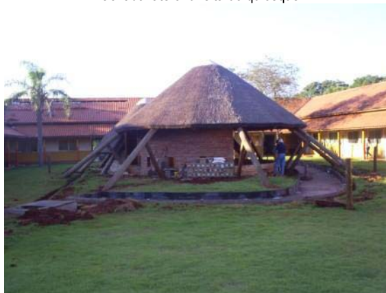
Fachada vista dos fundos do quiosque.
