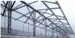
Estrutura da cobertura.
