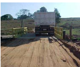
Prova de carga na ponte.
