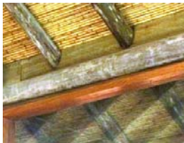
Vedação entre terças e vigas, com sarrafos.
