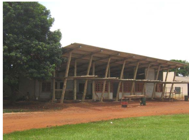
Fachada principal em fase final de construção.
