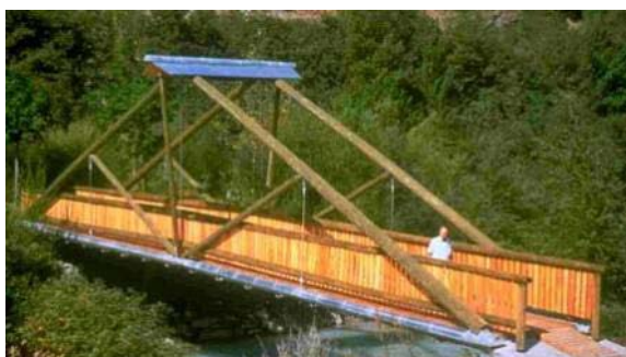
Passarela treliçada howe, com peças roliças de madeira.
