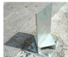
Ligação de base de coluna, em placa de base de aço galvanizado.
