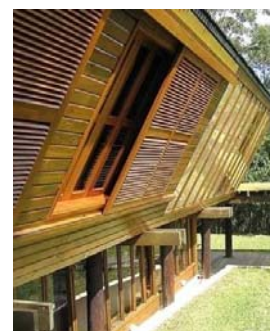
Condomínio Sítio da Tribo I: Paredes externas inclinadas, construídas com peças serradas de pinus.
