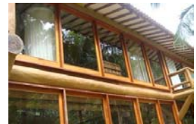
Esquadrias de madeira serrada, fixadas nas vigas e colunas.
