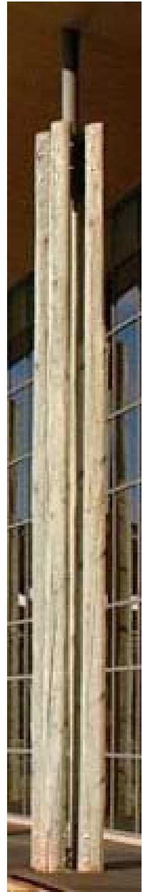
Coluna composta com quatro postes de eucalipto.
