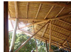
Mão Francesa de sustentação do topo da cobertura tipo asa-delta.
