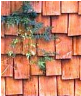
cobertura de madeira com taubilha.
