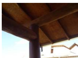
Conexão da coluna de canto da varanda na lateral esquerda.
