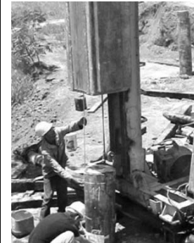
Medição da altura de queda do martelo, e medição do repique.
