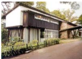
Fachada sul em 2004 antes da manutenção.
