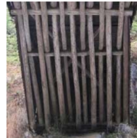
Internamente ao plano das vigas inclinadas, existe um sistema de contraventamento em X com peças roliças de madeira.
