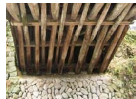
Vista inferior da passarela Rulong. Sistema de travamento com entalhes na madeira.
