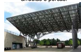
Vista da estrutura completa.
