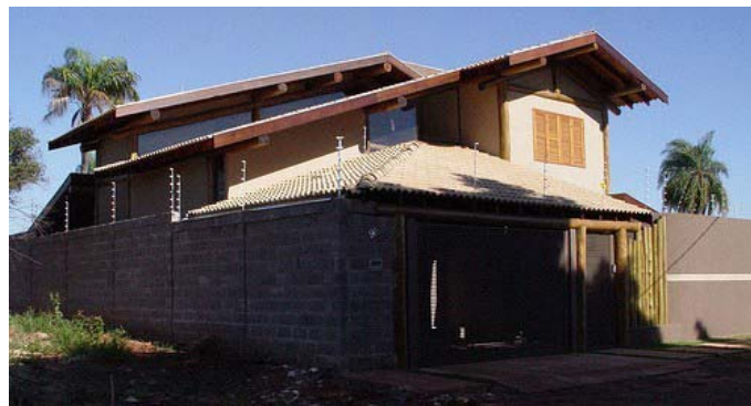
Fachada da edificação concluída.
