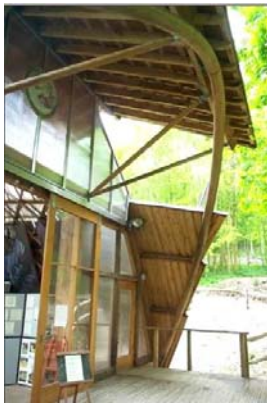
Vista lateral do sistema de escoramento definitivo, com peças roliças de pequeno diâmetro, da estrutura da cobertura e do pórtico em arco inclinado da fachada principal.
