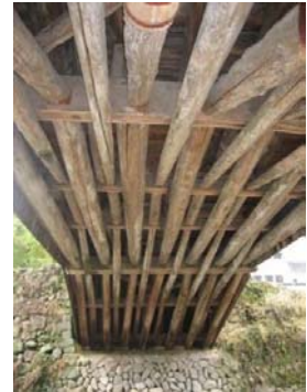
Vista inferior da passarela Rulong da estrutura do tabuleiro central.
