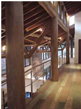
Mezanino: Sistema estrutural viga-coluna.
