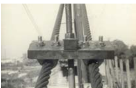
Placas de suspensão e grampos de fixação dos cabos.
