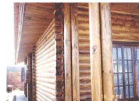
Vista externa: conexões de cantos de paredes.
