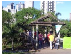
Pórtico de acesso à passarela.
