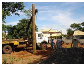
Íçamento das colunas, com caminhão muque.
