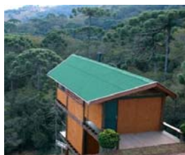
Cobertura com telhas de fibra vegetal.
