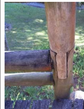
Emenda da coluna do guarda corpo.
