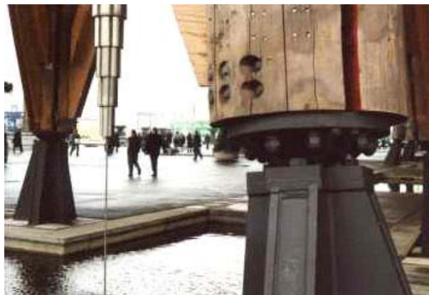
Placas de base, das colunas das torres de sustentação.
