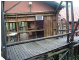
Tabuleiro da Passarela.
