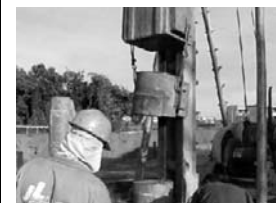
Retirada do capacete da estaca cravada.
