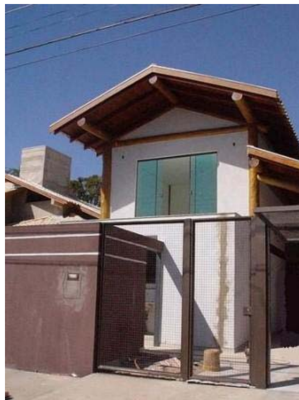
Fachada da edificação concluída.
