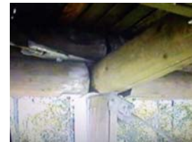
Ligações vigas-coluna da rampa de acesso.
