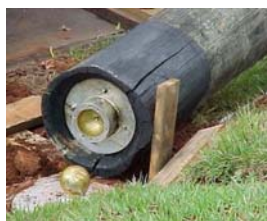
Parte da placa de base instalada na base do poste (Mastro).
