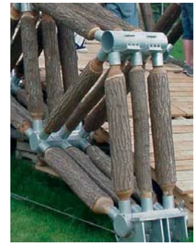
Detalhe dos conectores especiais, que unem os elementos estruturais de peças roliças de madeira.
