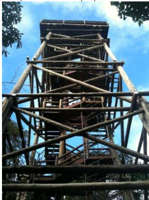
Vista da Torre. Sistemas de contraventamentos em X.
