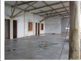
Escoras inclinadas (Mãos Francesas), escoram a estrutura da cobertura interna do escritório.
