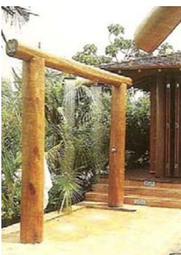
Pórtico c/ duchas na piscina.
