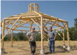
Estrutura do quiosque, concluída.
