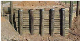
Muro de contenções de terra, em um dos lados dos encontros, concluído.
