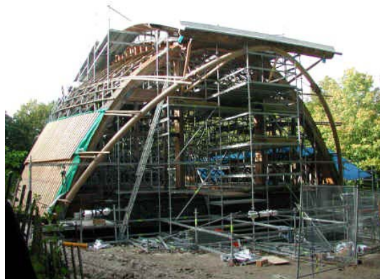
Fase da construção do galpão.
