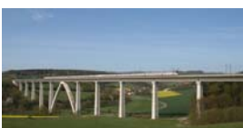
Viaduto ferroviário Mülmisch Talbrücke, concluído.
