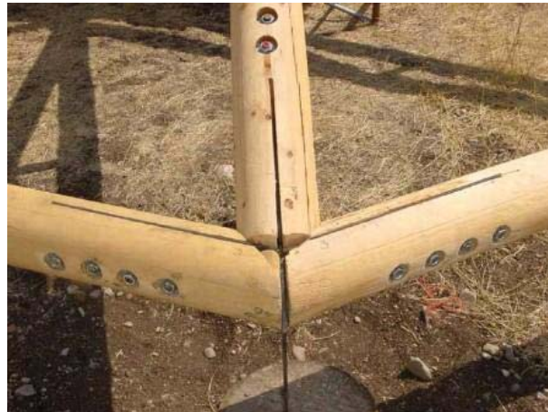
Detalhes da conexão com chapas internas da ligação vigas-coluna-banzo superior da treliça da cobertura do quiosque.
