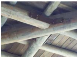
Vista das conexões com chapas externas, parafusadas com barras de aço rosqueadas passantes, arruelas e porcas, unindo às vigas secundárias às vigas principais.
