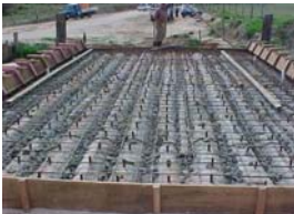
Vista superior do tabuleiro com os conectores metálicos.
