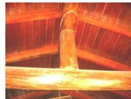
Cobertura da sacada da suíte.
