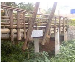
Colunas inclinadas do pórtico do pergolado.
