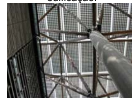
Vista inferior da estrutura de treliça espacial da cobertura, fixada no topo da coluna de concreto armado, situada ao lado direito da edificação.
