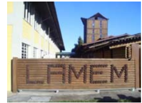
Acesso para a carpintaria do LaMEM. Portão de entrada com peças de Madeira Roliça de Pinus, torneadas. Fonte: Foto tirada pelo autor (2008).
