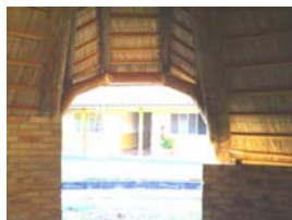
Estrutura com segmentos de peças roliças, para formar o arco sobre a abertura.
