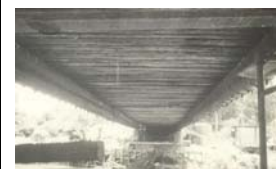
Vista inferior do tabuleiro e vigas bi-circulares de rigidez.
