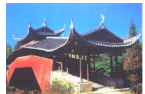
Detalhes na cobertura da passarela Xidong.
