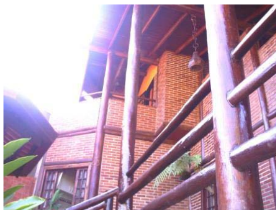
Varanda da entrada principal da sala de estar.
