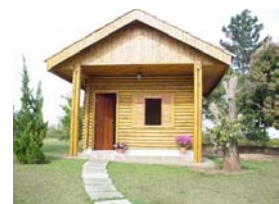
Estrutura da varanda: colunas com peças roliças de seção composta tripla.
