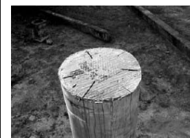
Chapa c/ dentes estampados na cabeça da estaca.
