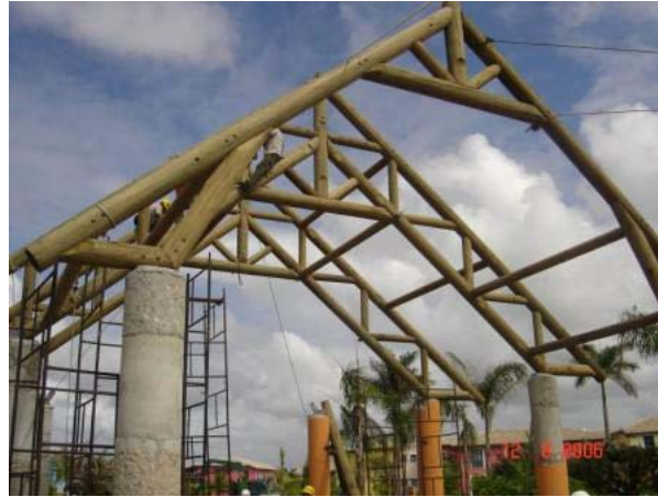
Pórtico Rígido e Vigas inclinadas em treliças.
