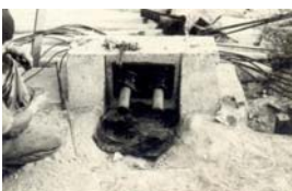
Placas de base para a fixação dos cabos.
