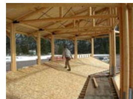
Montada a estrutura e a treliça da cobertura. Instalação de placas OSB como piso da arquibancada.
