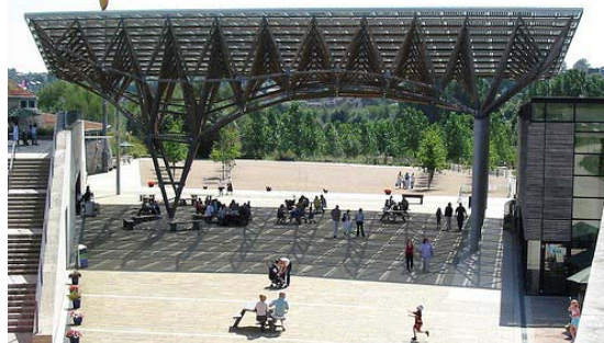
Vista frontal da estrutura completa.
