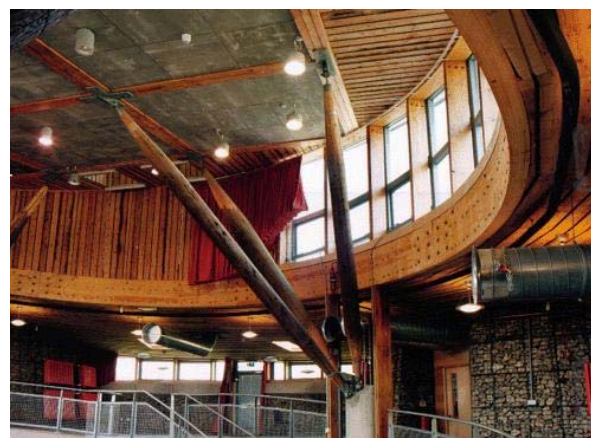
Vista interna do centro de convenções. Escoras definitivas da estrutura da cobertura, com colunas inclinadas V de madeira roliça.
