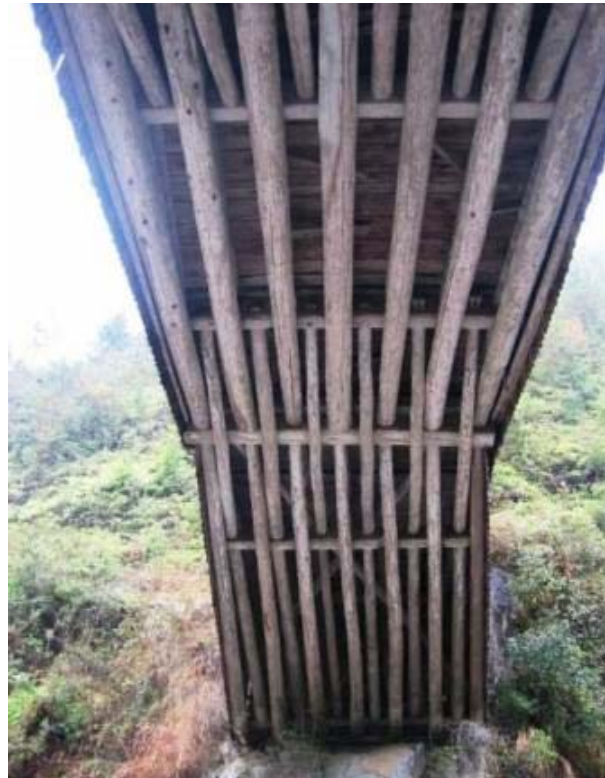
Vista inferior da Passarela Rainbow Santiao.
