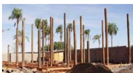
Colunas engastadas, concluídas.
