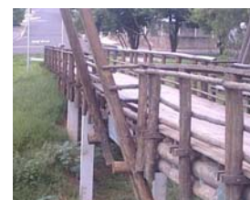
Estrutura do guarda corpo.
