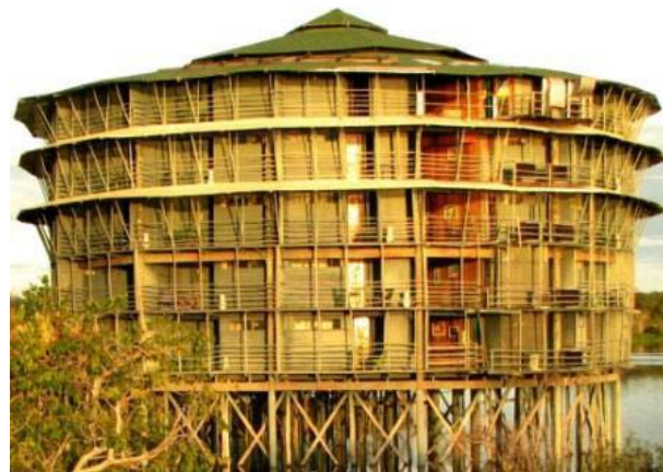
Sistema estrutural de torre, c/ colunas de madeira roliça e vigas e diagonais da treliça de contraventamento c/ madeira serrada.
