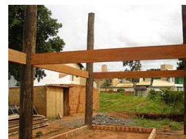
Vigas serradas, de seção retangular, que suportam o piso do pavimento superior.
