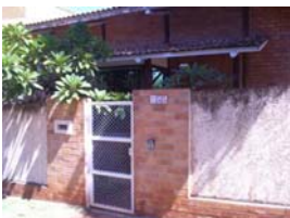
Cobertura da varanda.
