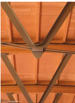
Suporte metálicos de sustentação dos tirantes da cobertura.
