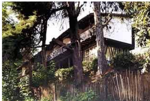
Fachada norte em 2004.
