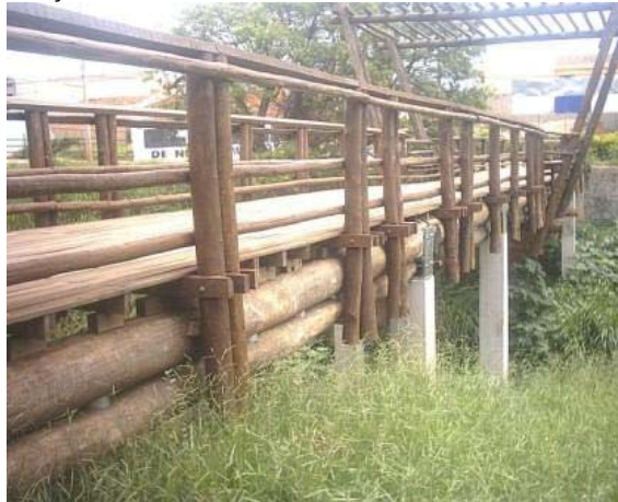
Vigas de madeira com seção bicircular.
