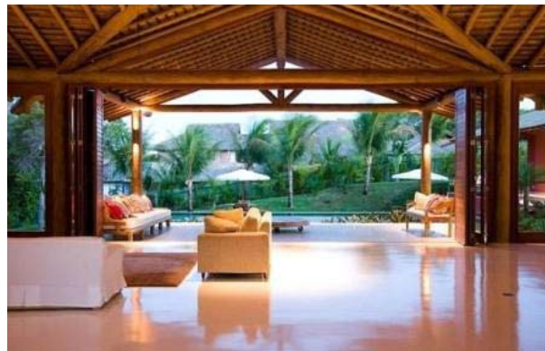
Estrutura de pórtico e estrutura da cobertura da sala com terças de madeira roliça.
