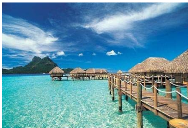
Estruturas das passarelas de acesso aos bangalôs.
