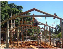
Estruturas dos galpões com sistema estrutural tipo pórtico.
