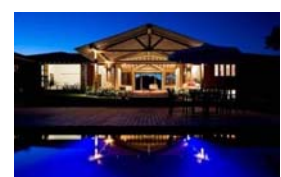
Iluminação da estrutura da varanda de acesso à sala.
