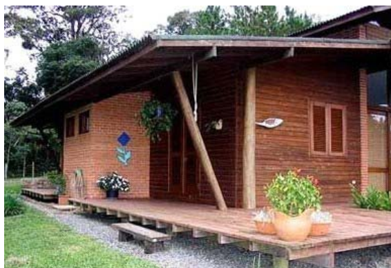
Condomínio Sítio da Tribo IV: Colunas de madeira roliça, vigas de madeira serrada.
