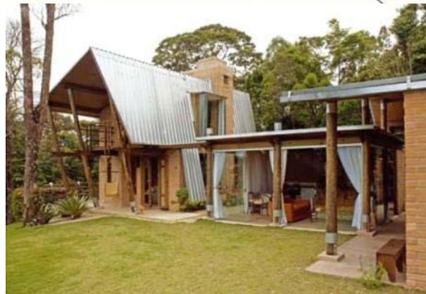
Fachada principal da edificação do chalé contemporâneo.
