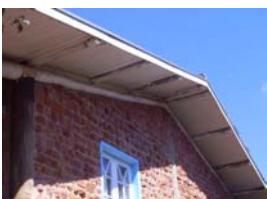
Treças da cobertura com madeira roliça de eucalipto.
