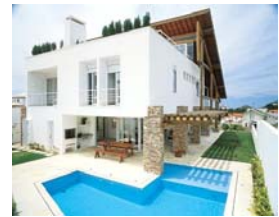
Vista dos fundos da edificação.
