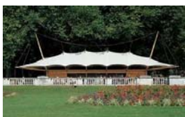
Fachada da estrutura.
