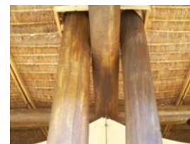
Vista inferior da conexão viga-coluna dupla
