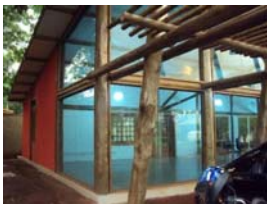
Vigas com seção composta dupla, fixadas nas colunas, com barras de aço rosqueadas passantes, arruelas e porcas.
