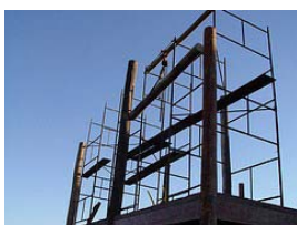
Içamento das vigas e/ talhas.
