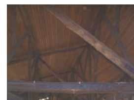
Emendas das peças do banzo inferior, com chapas externas.
