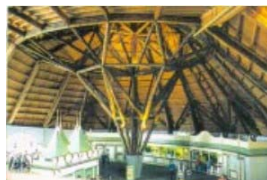
Vista da estrutura central da edificação. Treliça espacial tipo árvore.
