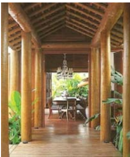
Estrutura do corredor de acesso à sala de jantar.
