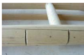
Pequenas fendas transversais na seção da peça roliça, para instalação externa da chapa metálica, de ancoragem da barra de aço de tirante.
