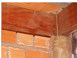
Laje pré-fabricada apoiada sobre as vigas de madeira serrada. Conexão de duas vigas de madeira serrada, apoiadas no corte do poste.
