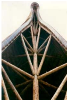
Detalhe da estrutura da cumeeira da fachada da entrada principal.
