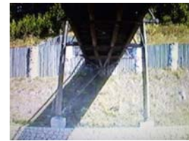
Vista inferior do tabuleiro.
