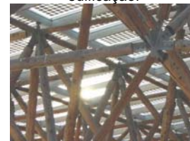
Detalhe das conexões da treliça espacial.
