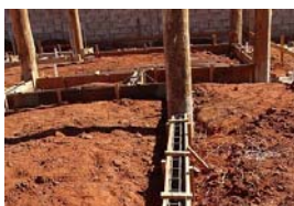
Vigas baldrame em concreto armado, interligadas aos blocos de fundação.
