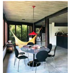
Cozinha no subsolo: estrutura da laje da cozinha em concreto pré-moldado, apoiada sobre às vigas de madeira roliça de eucalipto.
