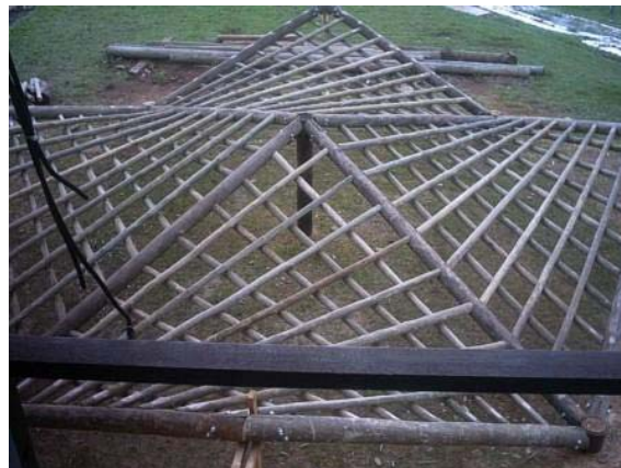
Cobertura Parabolóide Hiperbólica. Montagem no chão.
