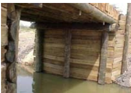
Paredes de contenção de terra dos encontros.
