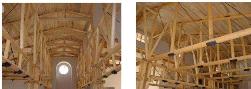
Figura 5.39: Cobertura composta por treliças planas atirantadas.
