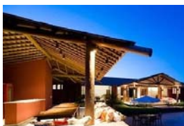
Estrutura da cobertura da varanda da churrasqueira.
