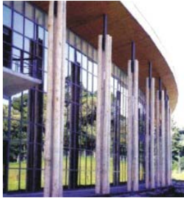
Detalhe da interface no topo das colunas de eucalipto com a estrutura metálica com perfis tubulares, circular apoiando a cobertura do edifício.
