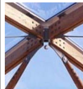
Conexões de topo das escoras inclinadas, fixandas na estrutura da cobertura.
