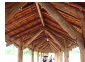
Estrutura da cobertura.
