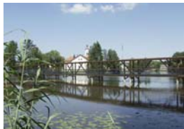
Vista da passarela.
