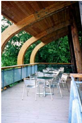
Vista externa da edificação da entrada principal.
