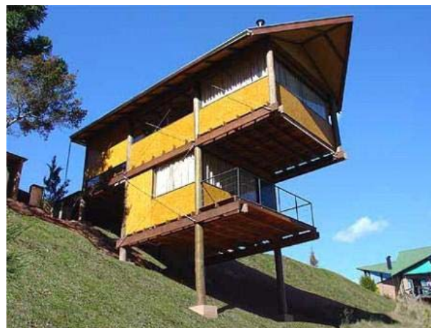
Loft na encosta. Colunas sobre blocos de concreto.
