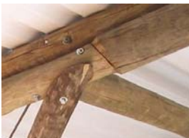
Emenda próxima ao nó, na viga inferior de dupla seção no segundo trecho.
