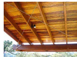
Contraventamentos horizontais, c/ cabos de aço.
