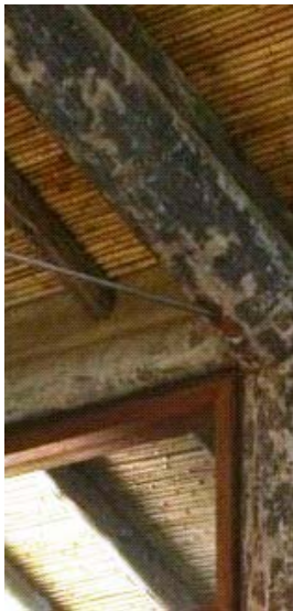
Tirante de aço, do pórtico.
