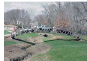
Prova de carga da passarela, com três veículos, sendo que no vão central o veículo é um furgão.
