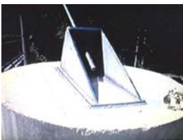
Vista frontal da placa de base de fixação dos estais.
