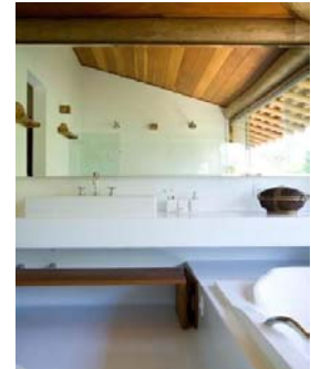
Vigas da estrutura do banheiro.
