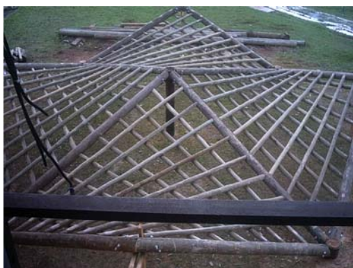
a) Montagem da cobertura no solo
