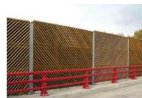
Barreira acústica com peças de madeira roliça de pequeno diâmetro.
