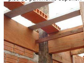
Vista inferior da instalação dos trilhos da laje pré-fabricada, apoiados sobre as vigas de madeira serrada.
