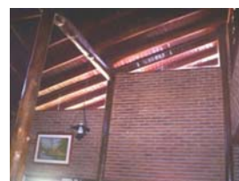
Cobertura da sala de pé direito duplo, que fica em anexo ao mezanino.
