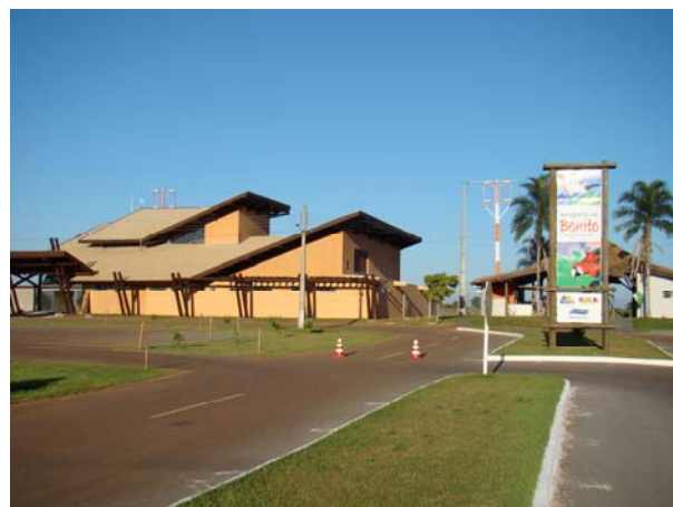
Primeira fase da obra concluída: Vista Geral da fachada.
