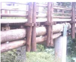
Estrutura do guarda corpo.
