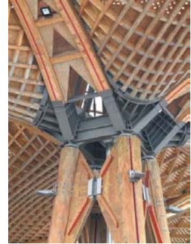
Topo da Torre: Conexões metálicas, unindo os elementos estruturais lamelares da cobertura, sobre as torres de sustentação.
