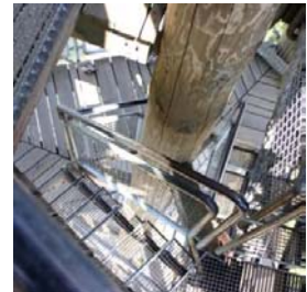
Coluna central que suporta parte do carga da escada.
