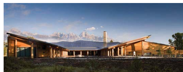
Vista dos fundos da edificação.
