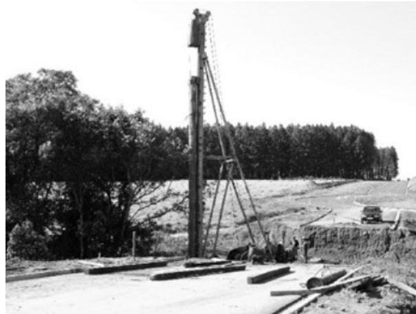
Equipamento de bate-estacas: martelo, capacete.
