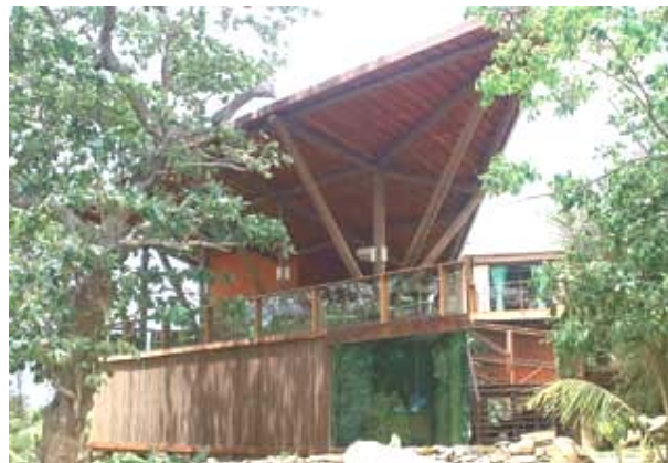
Salão, que ocupa o piso superior da sede, não possui fechamento. Sistema estrutural tipo asa-delta.
