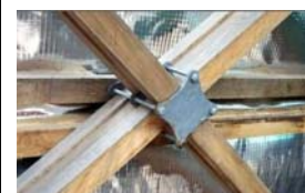
Nó de conexão da estrutura da grelha laminar.
