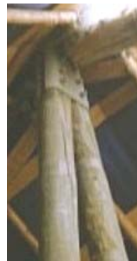
Conexão com chapas metálicas externas no topo das colunas inclinadas formando pórtico A.
