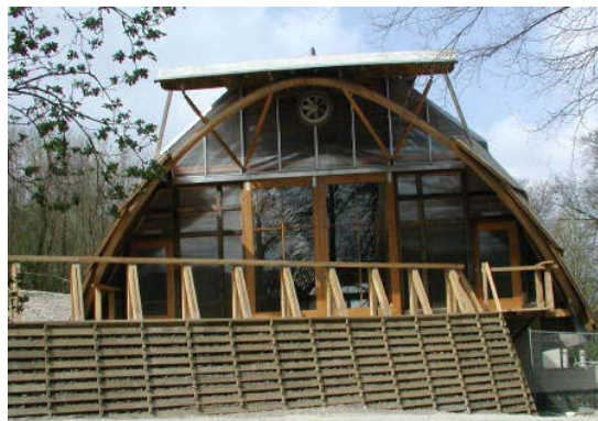
Fachada principal do galpão. Madeira laminada colada com seção circular, formando o pórtico em arco inclinado.
