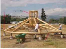
O procedimento de montagem da estrutura da cobertura do quiosque é realizado no chão.
