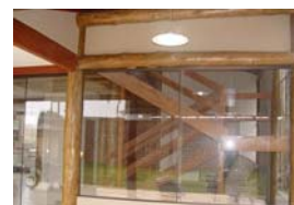
Acabamento e proteção da madeira com osmocolor stain da Montana Química.
