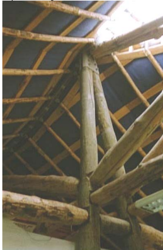
Detalhes das conexões do pórtico, nas colunas inclinadas V invertido.
