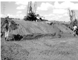
Locação topográfica para a cravação das estacas.
