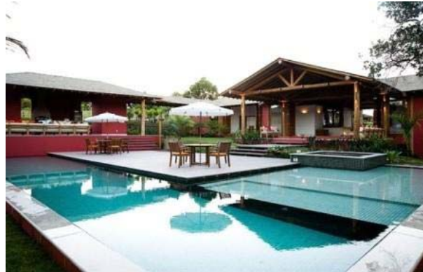
Fachada geral da edificação. Estrutura de pórtico.
