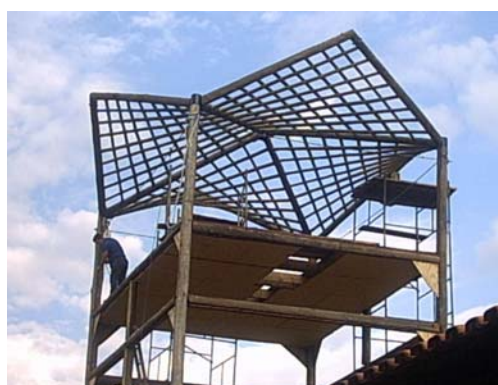
b) Cobertura transferida e montada no pórtico
