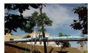
Prova de carga c/ piscinas.
