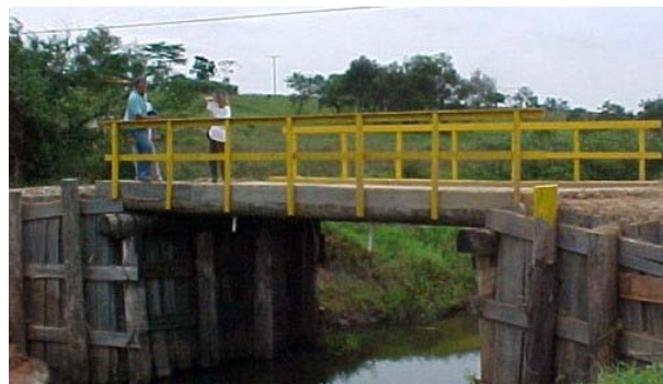
Vista da Ponte Ibitiruna.
