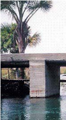
Vista lateral do pilar de Concreto Armado.
