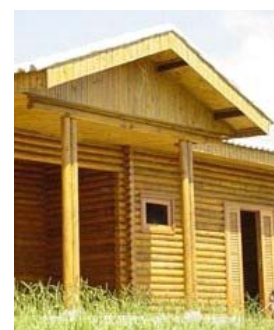
Estrutura da varanda: pórtico com peças roliças de seção composta dupla.
