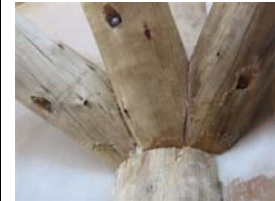
Detalhe das conexões das escoras inclinadas (Mãos Francesas tridimensionais), fixadas com barras rosqueadas passantes, arruelas e porcas.
