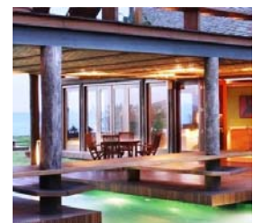
Pórticos da estrutura da cobertura do deck, composto por vigas de madeira serrada e colunas de madeira roliça.
