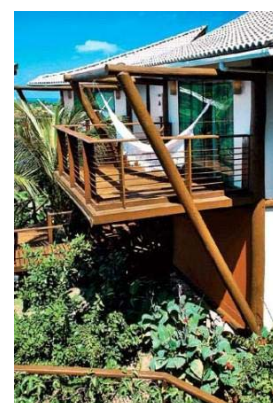
Estrutura da varanda
