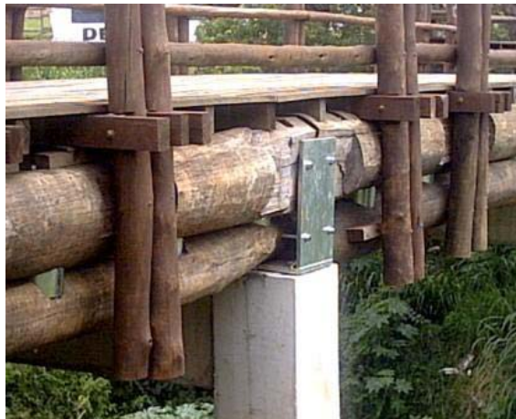
Placa de base metálica chumbada no pilar.
