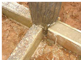
Vigas baldrame em concreto armado, interligadas aos blocos de fundação.
