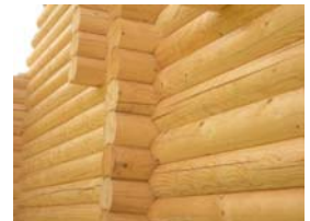
Encaixe na união das paredes de extremidades.
