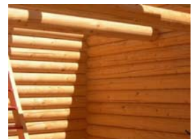
Fase de construção das vigas do pavimento do sótão.
