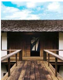
Assoalhos c/ madeira serrada de eucalipto, c/ 4,50mx2,70 m.
