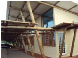
Vista lateral direita. Balanços reforçados com tirantes como suspensão.
