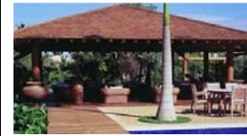
Estrutura da varanda.
