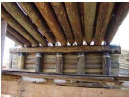
Posicionamento das longarinas.
