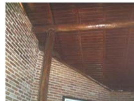
Viga inclinada da cobertura do mezanino com a sala, apoiada no topo da coluna de canto.
