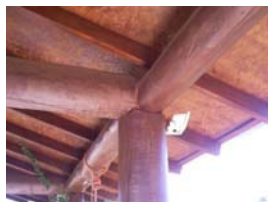
Conexão de uma das colunas intermediárias, da varanda.
