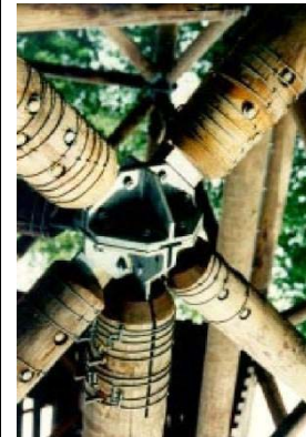
Conexão Especial para a Treliça Espacial.
