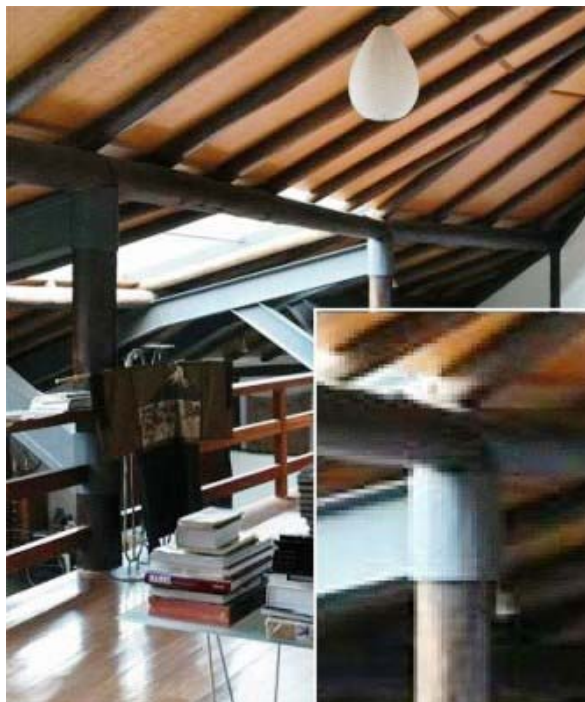
Vigas metálicas inclinadas de perfil i, de 15 metros de comprimento com mãos francesas do mesmo perfil, conectadas às colunas de madeira roliça de eucalipto.
