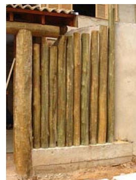
Muro com MRR.
