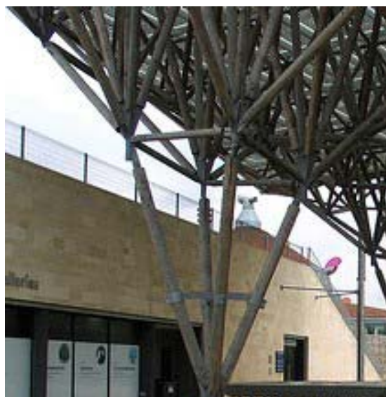
Estrutura de apoio da cobertura, com 4 colunas inclinadas em V, situada ao lado esquerdo da edificação.
