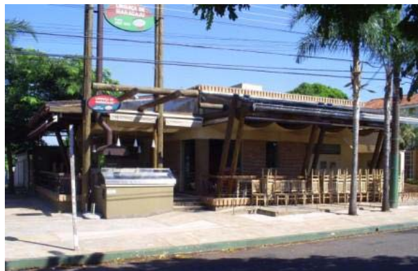
Vista Geral da fachada.
