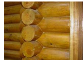
Sistema de conexões de paredes.
