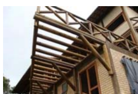
Pergolado e gradil com MRR.
