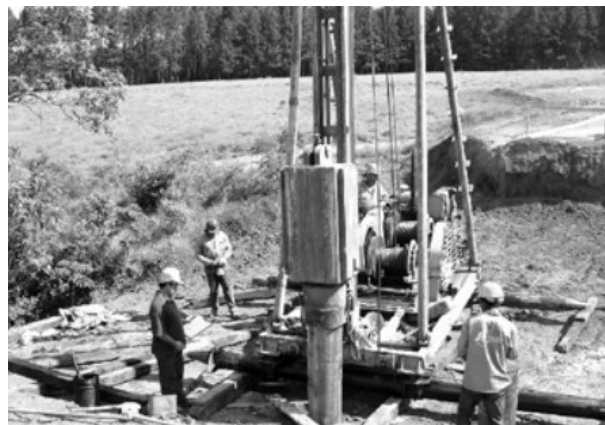
Cravação da estaca: martelo sobre o capacete no topo da estaca.
