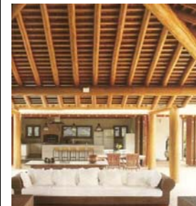
Terças, com madeira roliça. Acabamento e proteção das estruturas de madeira com Osmocolor da Montana Química.
