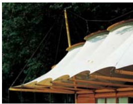
Cobertura textil da tenso estrutura.
