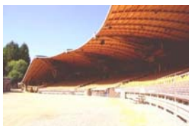
Estrutura lamelar da cobertura.
