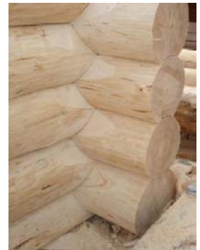
Modelo do encaixe das paredes de canto.
