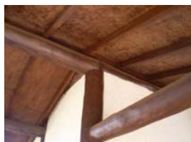
Conexão de uma das colunas centrais, da varanda.
