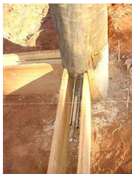
Vigas baldrame: esperas de barras de Aço CA50, coladas com adesivo eepóxi, nos furos na base da coluna.
