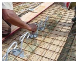
Detalhes construtivos da Ponte 01:
