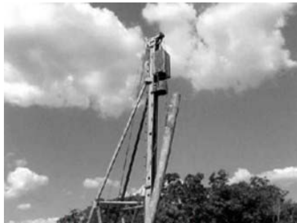
lçamento da estaca de madeira roliça.
