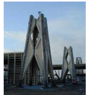
Montagem das torres c/ quatro peças de madeira roliça.
