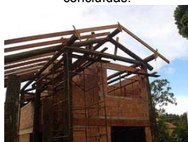
Estrutura da cobertura: vigas de respaldo e vigas inclinadas de madeira roliça, terças de caibros.
