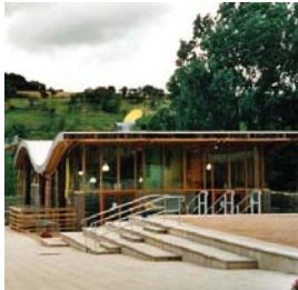
Fachada da entrada principal.
