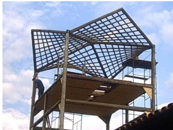
Instalação da cobertura na torre.
