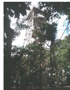
Vista geral da torre.
