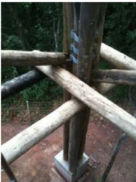
Detalhe de uma das colunas com seção transversal composta.
