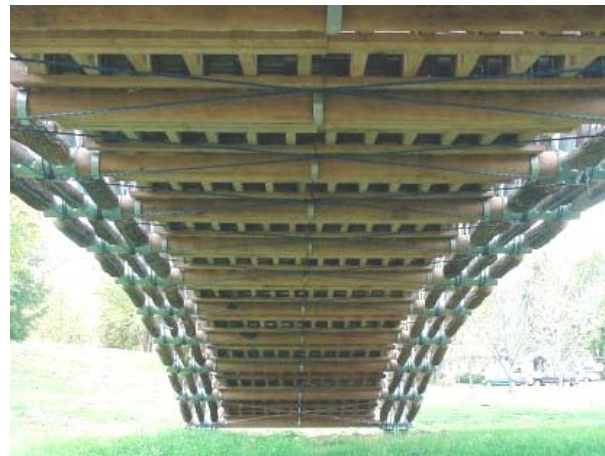
Vista inferior do tabuleiro e sistemas de contraventamentos.
