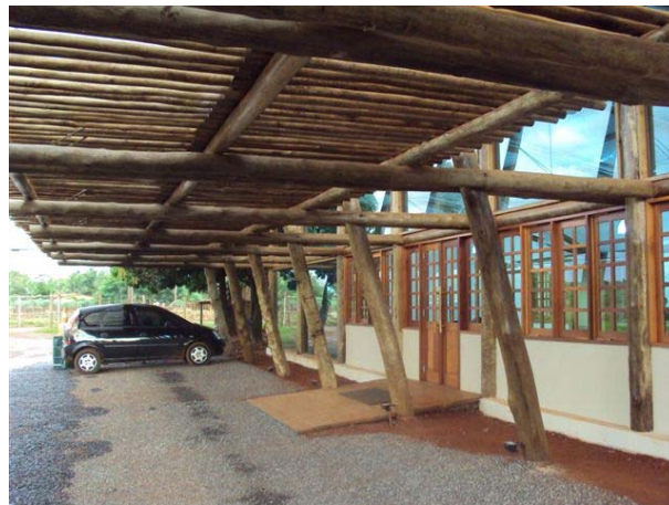
Pérgolas em balanço, sobre a área de estacionamento.
