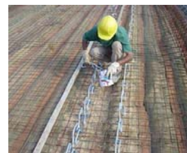
Detalhes construtivos da Ponte 02:
