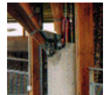
Conexão articulada das bases das escoras definitivas, compostas por colunas inclinadas, fixada no topo da coluna de concreto armado.
