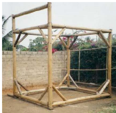
a) Estrutura do pórtico
