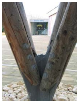
Detalhe da placa de base metálica, com parafusos passantes, arruelas e porcas.
