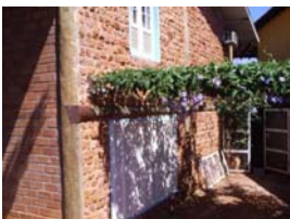
Ligação viga-coluna do pavimento superior.
