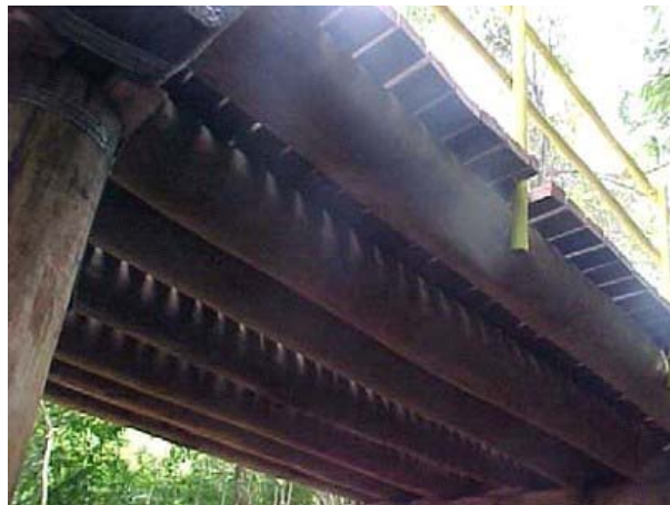
Vista inferior do tabuleiro.
