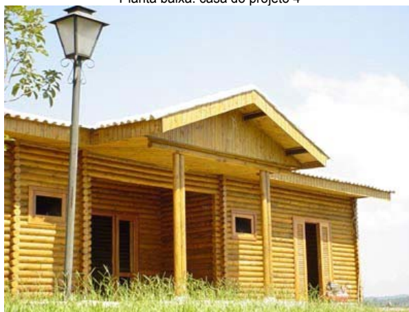
Fachada: sistema log homes. Fonte: www.casabella.etc.br
