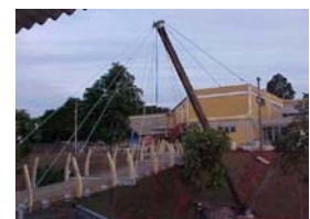
Colocação dos estais.
