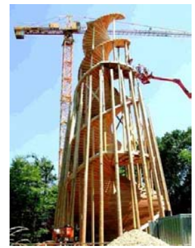
Fase final de montagem da estrutura da escadaria em espiral.
