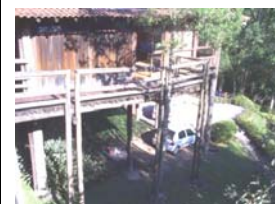
Estrutura da passarela externa.
