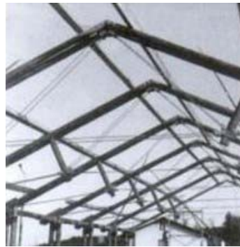
Cobertura do galpão tipo pórtico, atirantado.
