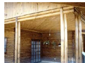
Estrutura da varanda: colunas c/ peças roliças com seção composta tripla e vigas com seção composta dupla.
