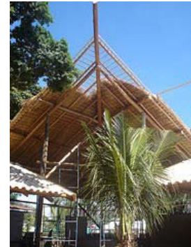
Revestimento da cobertura com sapê.
