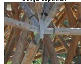
Nó da treliça espacial da cobertura. Detalhe de uma conexão metálica, com parafusos passantes, arruelas e porcas.
