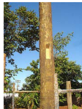
Abertura na coluna, para instalação de viga de madeira serrada, com seção retangular.
