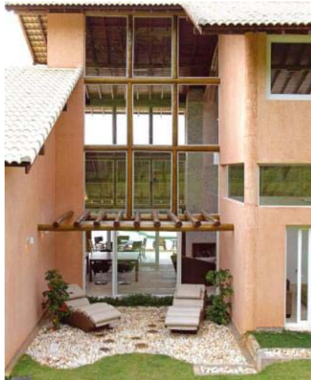
Pergolado e estrutura de peças roliças do painél de vidro.
