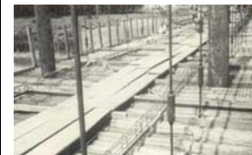
Armação dos guarda-rodas e detalhes dos esticadores.
