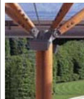
Conexões metálicas especiais entre as bases das escoras inclinadas em V e o topo da coluna.
