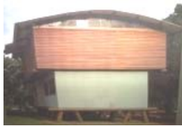
Vista lateral esquerda da edificação.
