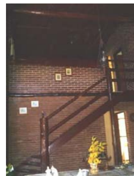
Escada de acesso ao mezanino, com peças de madeira roliça de meia seção.
