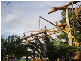
lçamento das peças de madeira roliça, com caminhão muque, para montagem da estrutura do galpão.
