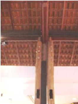
Coluna com seção composta.
