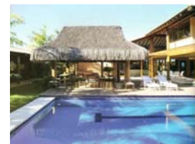
Estrutura do quiosque com peças roliças de madeira.
