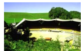
Vista total interna.
