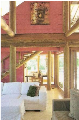
Estrutura do mezanino.
