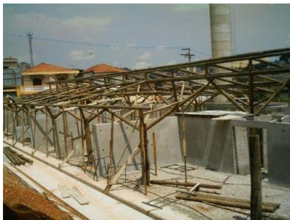
Fase de construção da estrutura.
