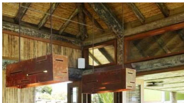
Estrutura da cobertura da sala de estar e jantar.
