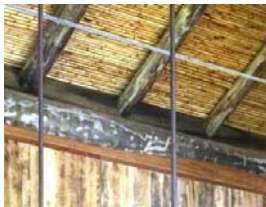
Terças de Madeira roliça, apoiadas sobre à viga, também de madeira roliça.
