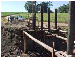
Cravação das estacas.
