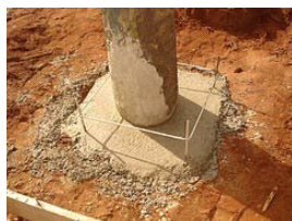
Fundação: aberduta para execução do bloco de concreto armado.
