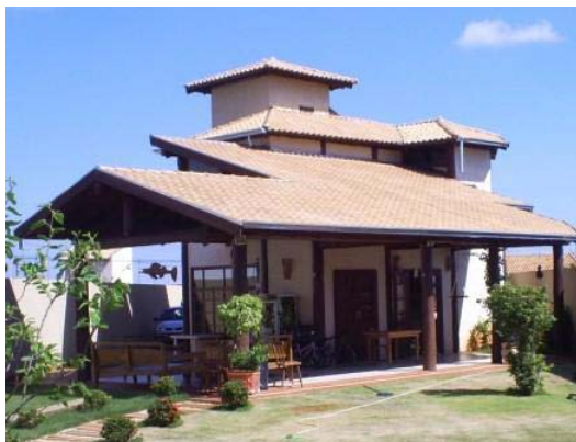
Fachada da varanda e porta de acesso à sala social.
