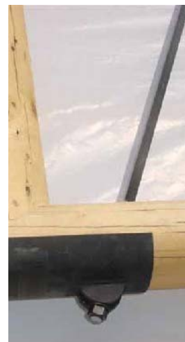
Detalhe da fixação do tirante: Barra de aço com rosca na extremidade, atarrachada com arruela e porca.
