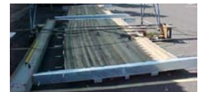
Aplicando protensão nos módulos do tabuleiro.
