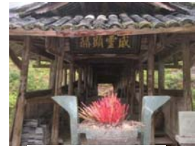
Detalhes na cobertura da passarela Santiao.
