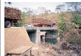
Prova de carga no maior vão da ponte.
