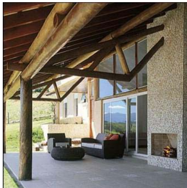
Varanda: cobertura com treliças polonceau reta invertida.
