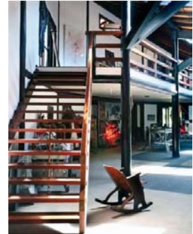
Estrutura do mezanino: laje de concreto pré-moldado, apoiada sobre às vigas de madeira roliça de eucalipto.
