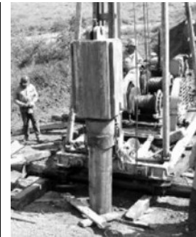
Cravação da estaca.
