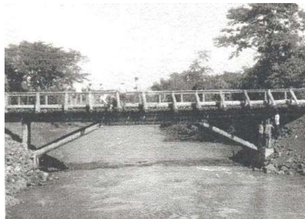
Vista lateral da ponte.
