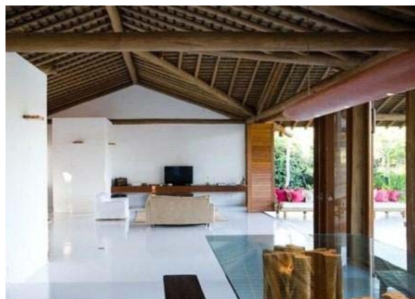
Estrutura da cobertura da sala, vista de outro ângulo.
