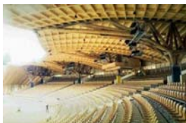
Estrutura treliçada, de sustentação da cobertura.
