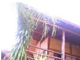
Guarda corpo da varanda.
