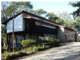
Fachada sul – em 2006
