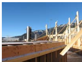
Instalações das colunas.
