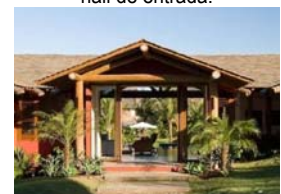
Estrutura do Hall de entrada.
