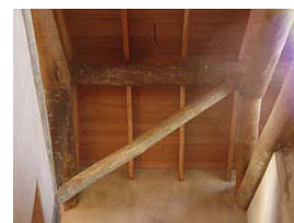
Cobertura: Terças com caibros de madeira serrada.
