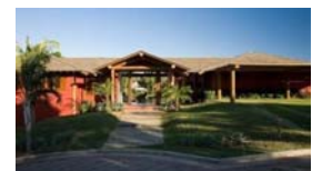
Estruturas da garagem e do hall de entrada.
