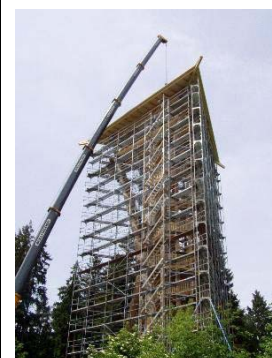
Fase final de construção.
