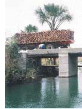
Prova de carga no menor vão da ponte.
