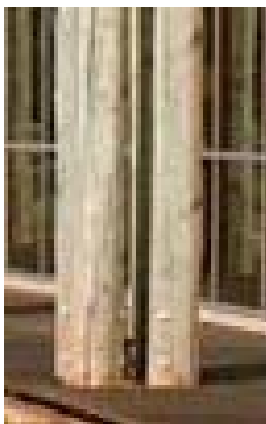
Detalhe da base da coluna.
