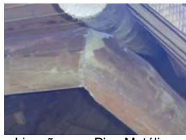
Ligação com Pino Metálico.
