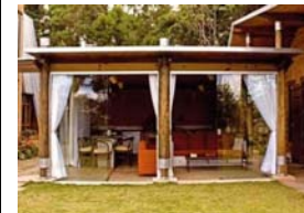
Estrutura do salão.
