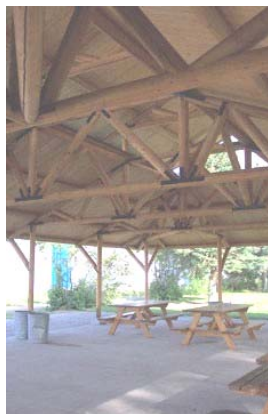
Estrutura da cobertura.
