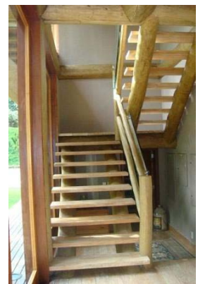
Estrutura da escada.
