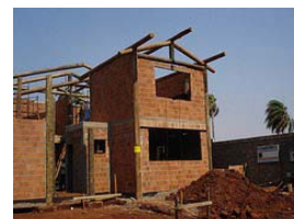
Alvenaria com tijolos furados.
