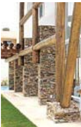
Colunas de madeira roliça, fixadas em pilaretes de concreto armado revestido com pedras.
