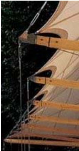
Conexões metálicas especiais, parafusadas nas extremidades dos elementos estruturais de madeira roliça de pequeno diâmetro.
