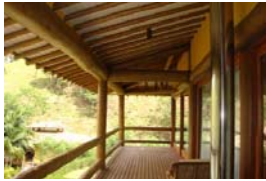
Estrutura da varanda.
