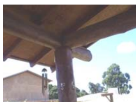
Conexão da coluna de canto da varanda à frente.
