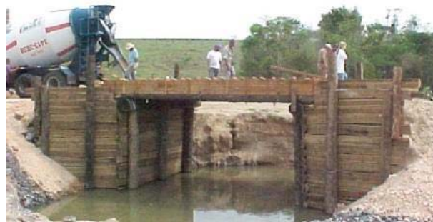
Vista da Ponte Capela.
