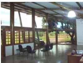
Vista interna do escritório. À direita escoras inclinadas definitivas (mãos francesas tridimensionais), sustentam a estrutura da cobertura do escritório.
