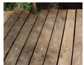
Tabuleiro de pranchas de madeira serrada.
