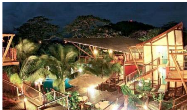
Com cobertura maior, a sede se diferencia dos bangalôs. Cobertura da sede com sistema estrutural tipo asa-delta.
