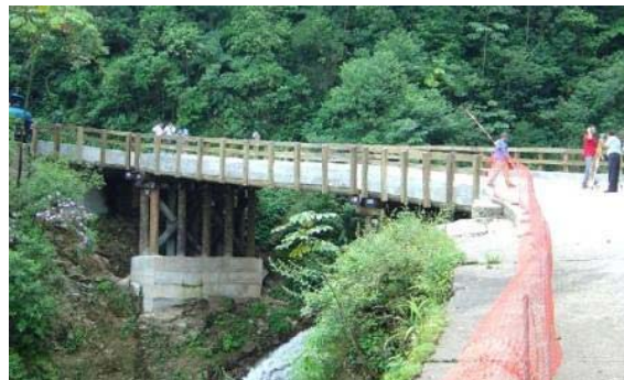
Vista da Ponte Caminho do Mar Fonte: CALIL et al (2006).
