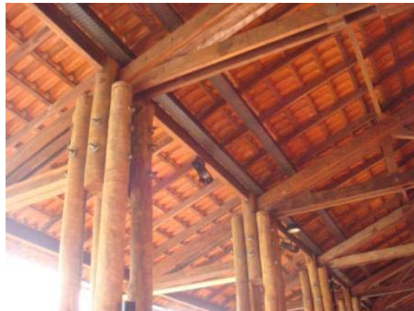
Colunas com seção composta de quatro postes de eucalipto, de sustentação das treliças howe de madeira serrada da cobertura.
