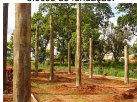
Colunas engastadas, concluídas.
