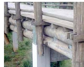
Estrutura do guarda corpo.
