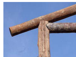
Estrutura da cobertura da fachada (Beiral).
