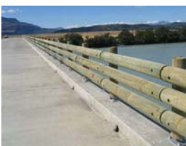
Defensa e guarda-corpo instalada em ponte.
