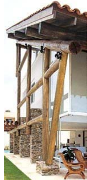
Detalhe do pórtico da lateral esquerda da edificação.
