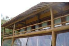
Colunas de extremidades, recebendo às vigas.
