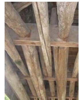
Vista inferior da passarela Rulong. Sistema de travamento com entalhes na madeira.
