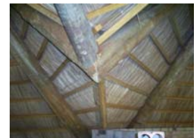
Conexões com pinos metálicos, na união dos três quiosques.
