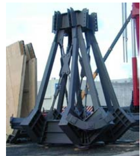
Pedestal de aço: Conexões metálicas, que unem os elementos estruturais lamelares da cobertura, sobre as torres de sustentação.
