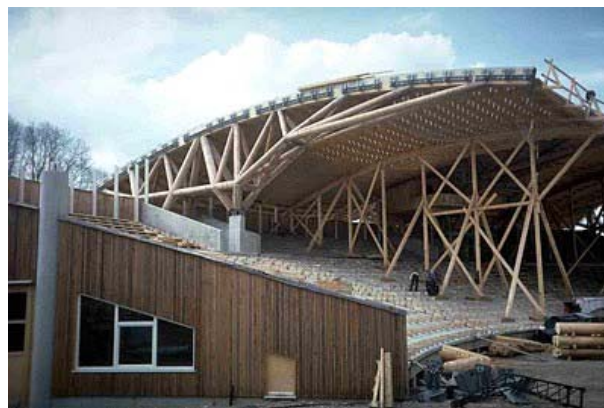
Fase da construção: Escoramento da estrutura da cobertura.
