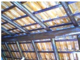
Cobertura da garagem, com duas águas.
