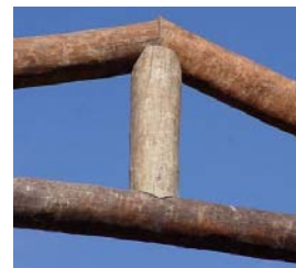
Estrutura da cobertura da fachada (cumeeira).
