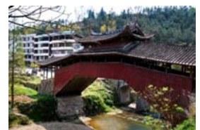
Vista lateral da passarela Xidong.
