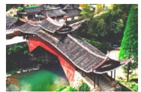
Vista aérea da passarela Xidong.
