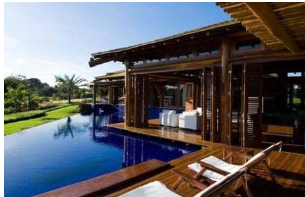
Estrutura da sala: Sistema estrutural viga-coluna.
