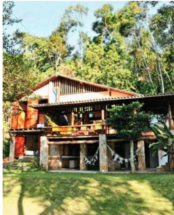
Vista frontal da edificação. Beirais de 80 cm de profundidade evita entrada de chuva pelo ripado longo abaixo do telhado.
