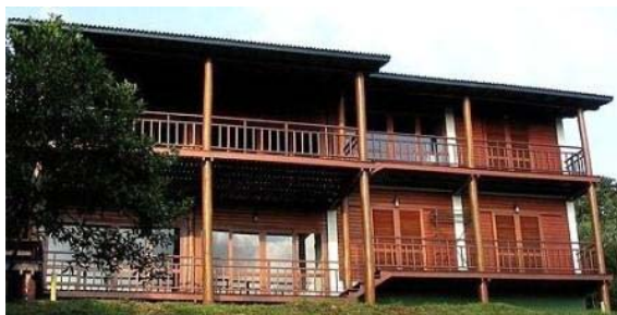
Condomínio Sítio da Tribo V: Colunas de madeira roliça, vigas compostas de duas peças de madeira serrada externas.
