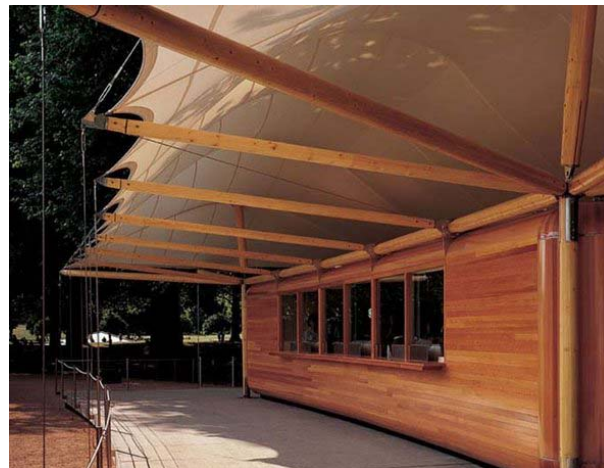
Elementos estruturais da tenso estrutura, com peças roliças de pequeno diâmetro.
