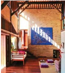
Foram utilizadas mãos francesas em algumas ligações viga-coluna.
