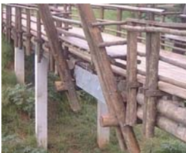
Colunas inclinadas do pórtico do pergolado.
