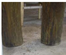
Detalhe do contra piso. E colunas duplas engastadas diretamente no solo.
