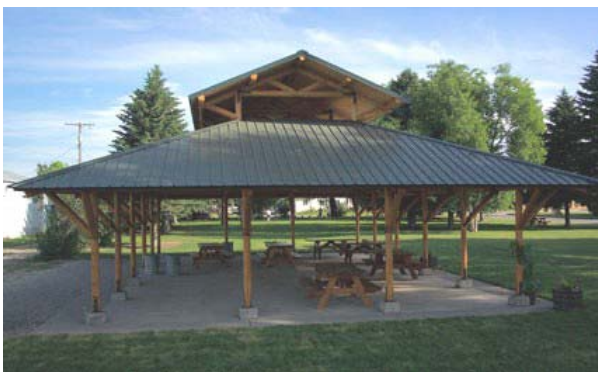
Detalhe externo da estrutura galpão de 30m x50m acabado.
