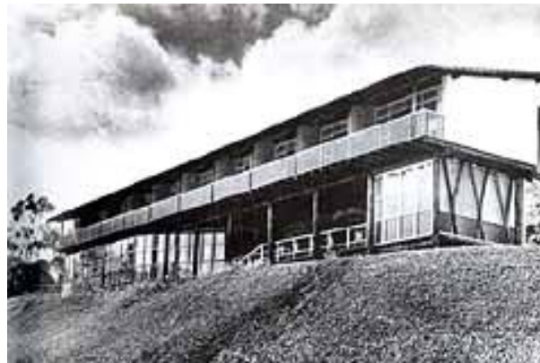
Fachada norte em 1945.
