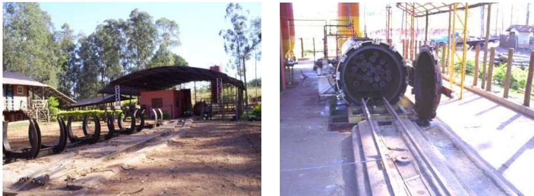
Figura 3.4: Usina de Preservação de Madeira, tratamento de impregnação de preservativo em autoclave. Fonte: Foto tirada pelo autor, em visita técnica à usina Petras, em julho de 2008.
