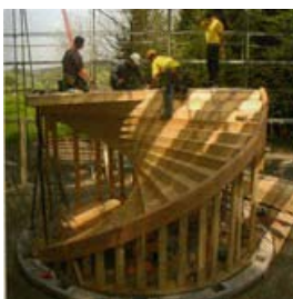
Montagem da estrutura da escada central em espiral.
