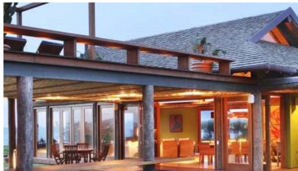
Sala de estar e jantar: cobertura com telhas cerâmicas.
