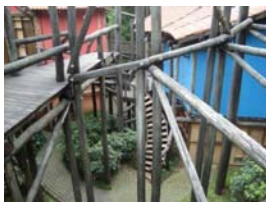
Detalhes das colunas, vigas e diagonais.
