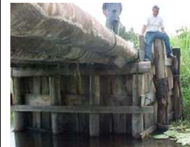
Vista inferior do tabuleiro.
