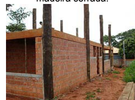
Alvenaria com tijolos furados.
