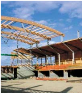
Instalação das vigas curvas de Madeira Laminada e Colada de pinus que compõem a cobertura.
