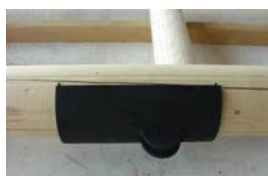
Instalação da chapa metálica externa de ancoragem da barra de aço do tirante.
