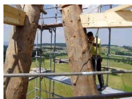
Montagem do sistema com conector metálico, unindo os vértices dos triângulos, na meia altura da torre.
