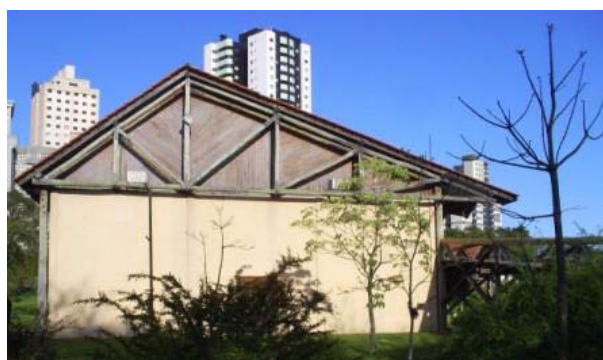
Galpão com cobertura de treliças duplas howe assimétrica, com peças roliças de madeira de reforestamento.
