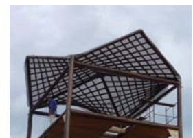
Instalação do revestimento textil da cobertura na torre.
