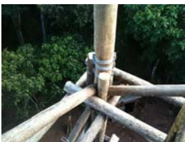
Detalhe de uma das colunas com seção transversal composta.
