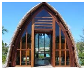
Estrutura da capela do Resort Four Seasons BoraBora. Terças com peças roliças.
