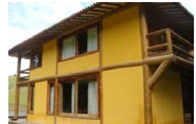
Mão-francesa nas extremidades das vigas em balanço das varandas.
