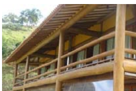
Coluna de canto, recebendo as vigas.
