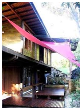
Condomínio Sítio da Tribo I: Varanda. Colunas de madeira roliça, vigas compostas de duas peças de madeira serrada externas.
