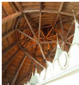
Estrutura da cobertura.
