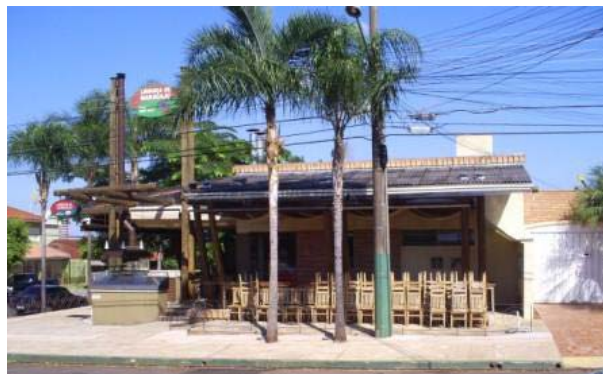
Vista da fachada principal.
