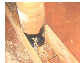
Barras de aço da viga baldrame, inseridas na base da coluna.
