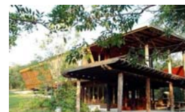
Condomínio Sítio da Tribo I: Colunas da garagem, com peças roliças de madeira.
