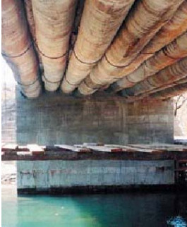
Vista frontal do pilar de Concreto Armado.
