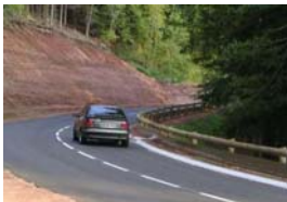
Defensa instalada em margem de encosta com curva perigosa.
