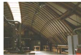
Vista interna do galpão.
