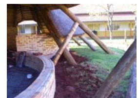
Estruturas das vigas inclinadas e escoras engastadas no solo.
