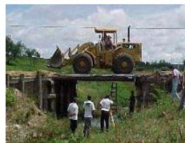
Prova de carga sem o concreto.
