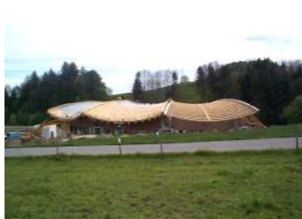
Fase da construção: Estrutura da cobertura.
