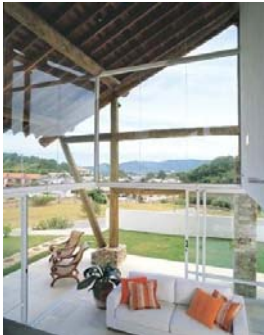
Estrutura com vigas de madeira roliça. Terças da cobertura com vigas madeira serrada.
