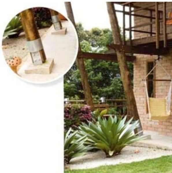
Placas de base da coluna, sobre blocos de fundação.
