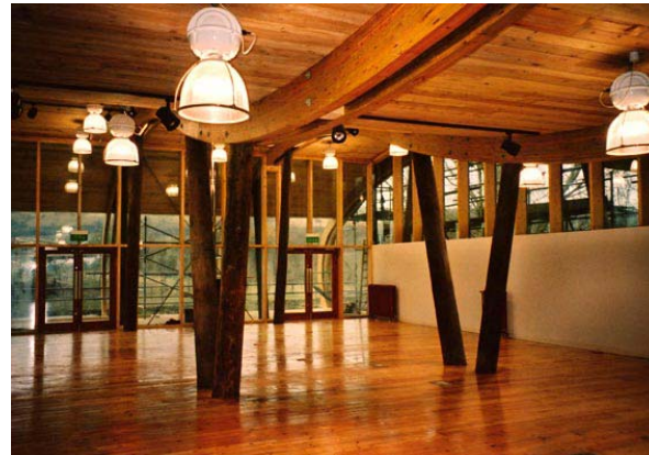
Vista interna da edificação da entrada principal. Sistema estrutural com colunas inclinadas V, de madeira roliça. Vigas compostas com seção dupla de madeira laminada colada em arco.
