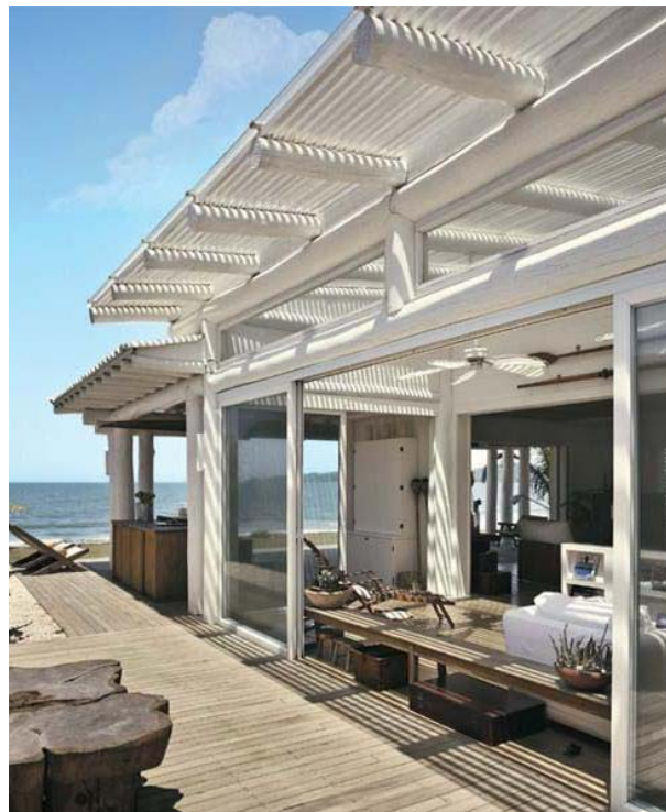
Estrutura do pergolado com peças roliças de madeira.
