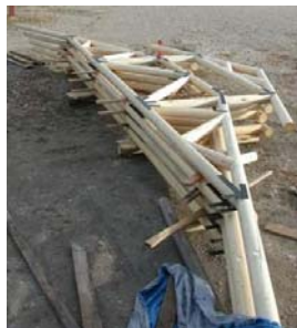
Treliças c/ peças de Madeira Roliça de Pequeno Diâmetro. Banzos e montantes \Phi 15 cm, diagonais \Phi 12 cm.
