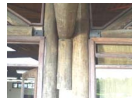
Colunas do galpão, com seção composta dupla. Tora ao centro está fixada às peças da coluna, com a função de espaçador e console do banzo inferior da treliça da cobertura.
