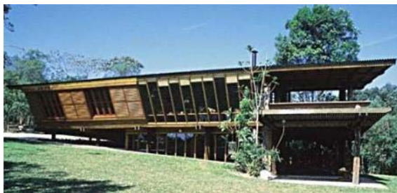
Condomínio Sítio da Tribo I: Colunas de madeira roliça, vigas compostas de duas peças de madeira serrada externas.
