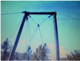
Contraventeamento do pórtico.
