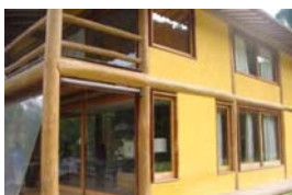
Colunas de canto e de extremidades recebendo às vigas.
