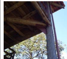
Detalhe da coluna de canto.
