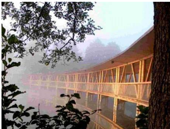
13 pórticos, compostos por colunas compostas de dupla seção.
