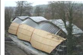
Fase final de construção.
