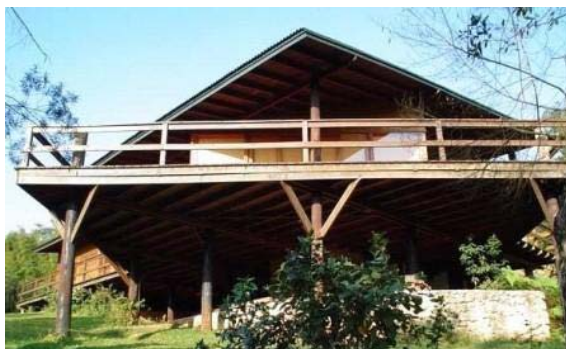
Condomínio Sítio da Tribo III: Colunas de madeira roliça, vigas e mãos- fracesa de madeira serrada.
