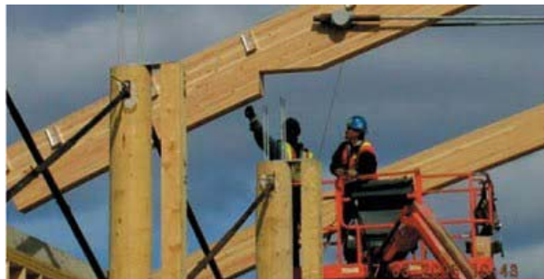
Instalação das vigas curvas de Madeira Laminada e Colada, apoiadas nas colunas de madeira roliça de pinus.
