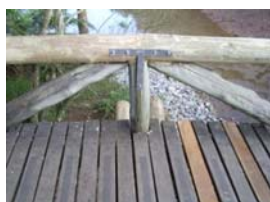
Conexões dos nós do guarda corpo que compõe os contraventamentos em X da estrutura treliçada.
