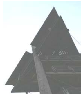
Vista inferior do patamar Principal.
