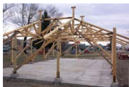
Montagem da estrutura.
