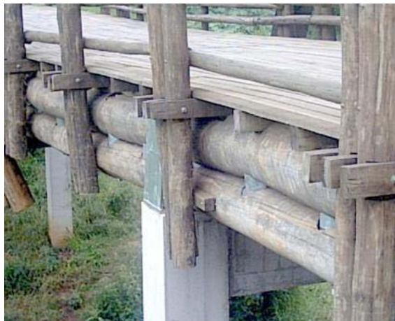
Vigas bicirculares apoiadas sobre os pórticos de concreto armado.
