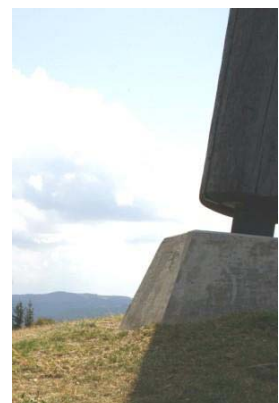
Detalhe do bloco de fundação com fixação da placa de base da coluna
