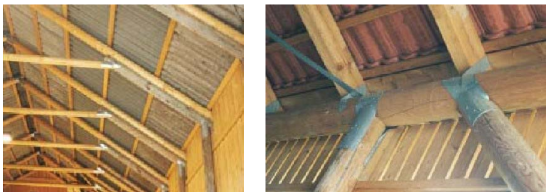
Figura 4.11: Ligações com chapas perfuradas e pregadas – Fonte: RANTA-MAUNUS (2002).
