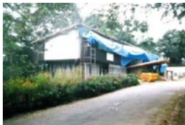
Fachada sul em julho de 2004, em manutenção.
