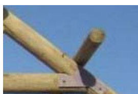
Nó da trelça: ligação com chapa externa e parafusos.
