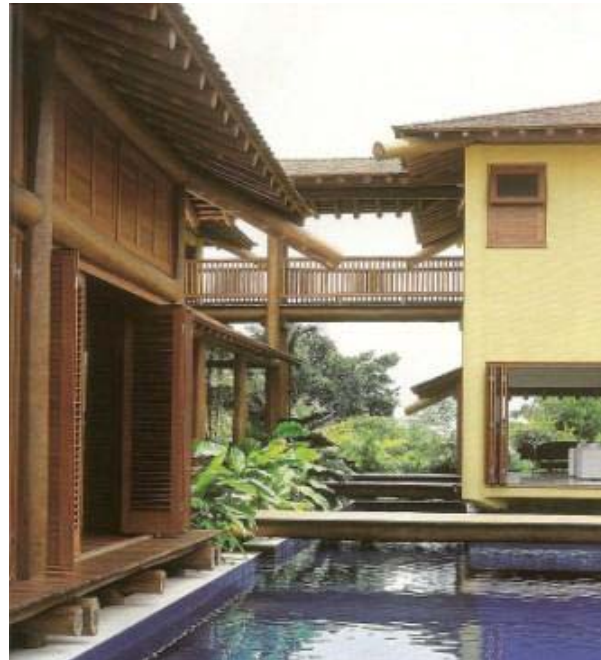
Terças, com madeira roliça. Acabamento e proteção das estruturas de madeira com Osmocolor da Montana Química.
