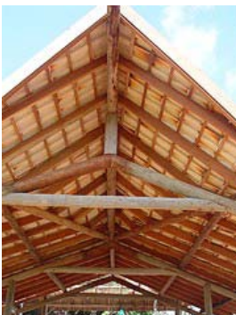
Estrutura da Cobertura, com madeira roliça e terças com madeira serrada. Cobertura do galpão, com telhas cerâmicas.
