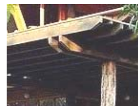
Condomínio Sítio da Tribo I: vigas compostas de duas peças de madeira serrada externas, conectadas no topo da Coluna de madeira roliça.
