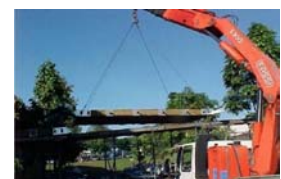
Instalação dos módulos do tabuleiro.
