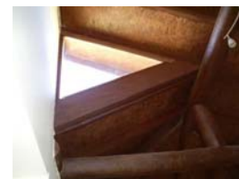
Estrutura da cobertura sobre à escada.
