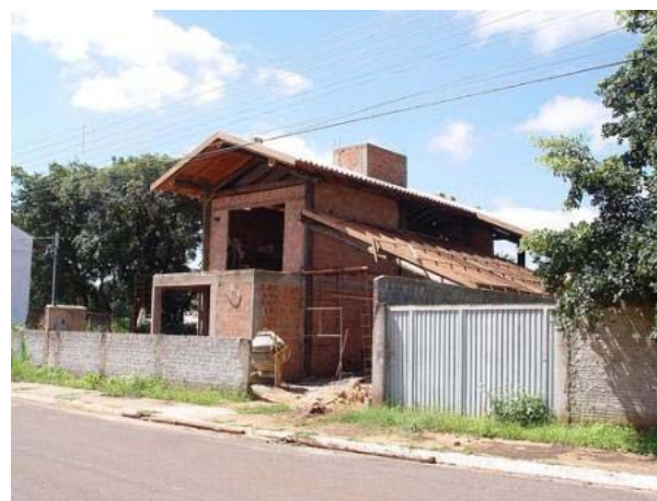
Fachada em fase de construção.
