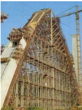
Sistema estrutural composto por quatro lances de cimbramentos do Viaduto Mülmisch Talbrücke.
