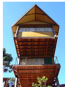
Vigas com seção composta por dois elementos.
