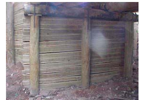
Vista das colunas estaqueadas, como contrafortes do muro de contenção de terra.
