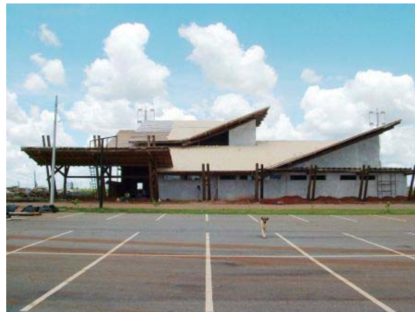
Etapa final da construção.
