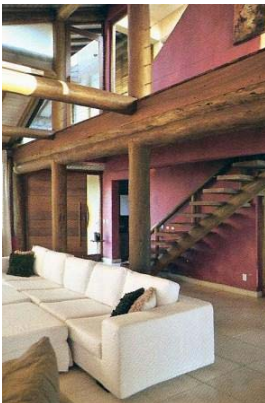
Vigas com seção bicircular.
