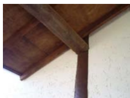
Conexão da coluna intermediária, da varanda com a sala social, na lateral esquerda.
