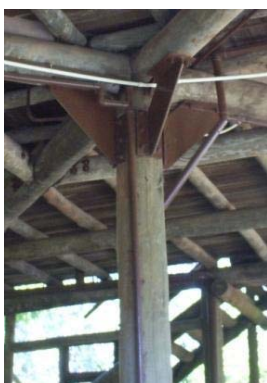
Conexões metálicas tipo consoles, que unem as vigas principais, da estrutura de grelha do piso, à coluna central.
