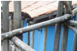
Colunas com seção dupla.
