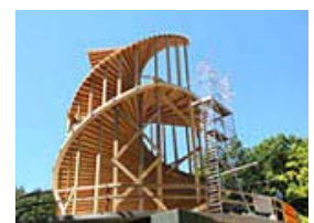
Fase inicial de montagem da estrutura da escadaria em espiral, fixadas nas colunas externas da torre.
