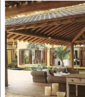
Estrutura da cobertura da varanda. Beirais de 1 metro.
