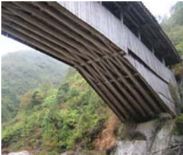
Vsita inferior da passarela. A s bases da estrutura desta passarela são esgastadas diretamente na rocha sã.
