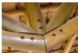
Nó da trelça: ligação com chapa interna e parafusos.
