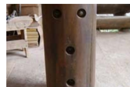
Ligação de base de coluna, em placa de base de aço galvanizado.
