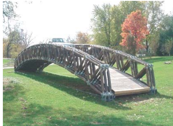
Passarela concluída: arco com barras de aço e esticadores.
