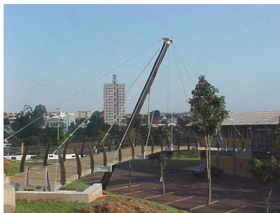
b) Vista geral da passarela
