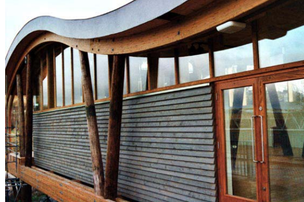
Vista externa da edificação da entrada principal. Colunas inclinadas V de Peças Roliças de Madeira vigas de madeira laminada colada.
