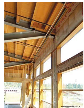
Estrutura da cobertura sobre a arquibancada.
