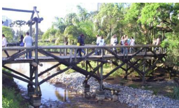
Passarela: Estrutura em manutenção. Sistema estrutural de pórticos, contraventados com treliças em X. Blocos sobre estacas de concreto.
