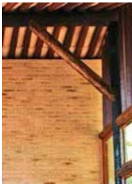
Detalhe de uma mão francesa, interligando a viga à coluna.
