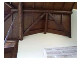
Estrutura da cobertura do hall de entrada principal. Forro com chapas de OSB.
