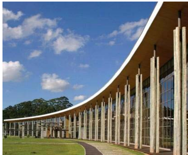
Detalhe das colunas de madeira roliça de eucalipto.
