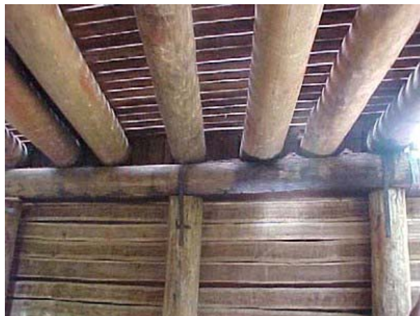
Longarinas roliças. Vigas próximas, sob a região do rodeiro.
