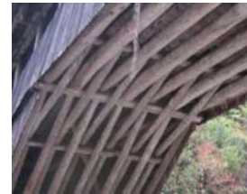
Sistema dos encaixes de sobreposição entrelaçadas das peças roliças de madeira.
