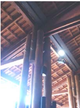
Conexões no topo da coluna.
