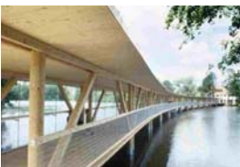
Vigas da cobertura, com seção composta dupla.
