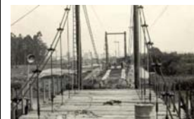
vista superior do tabuleiro.
