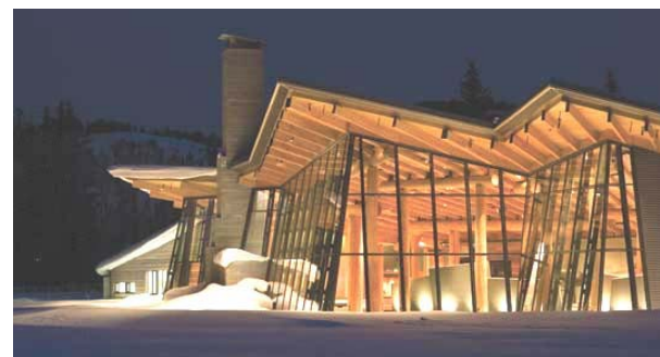
Vista frontal da edificação. Estrutura do painel de vidro e chaminé da lareira.
