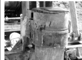
Estaca cravada: capacete sobre a cabeça da estaca.
