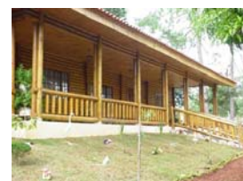
Estrutura da varanda.
