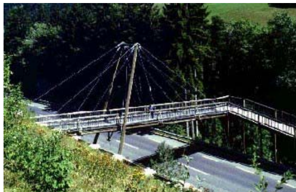
Figura 5.23: Passarela estaiada para pedestres, Vallorbe, Suíça. Fonte: Base de Dados do LaMEM.
