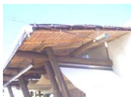
Sistema estrutural viga-coluna dupla
