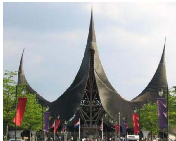
Fachada da edificação do pavilhão de entrada do parque. A edificação possui largura total de 60 metros de frente.
