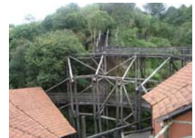
Passarelas e escada de acesso à encosta.
