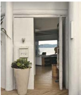
Verga de madeira roliça, sobre a porta de entrada principal.
