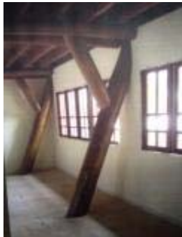
Estrutura da edificação. Vista interna da sede.
