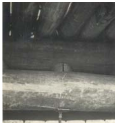
Vista do anel instalado, na união da viga bi-circular.
