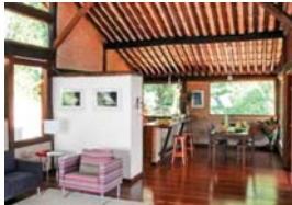
Estrutura da sala. Sistema estrutural viga-coluna.
