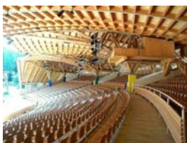
Estrutura da cobertura.
