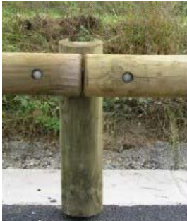
Conexão viga-coluna.
