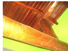
Cobertura do banheiro.
