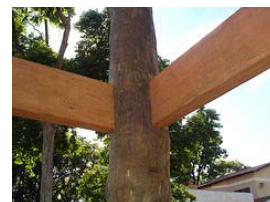
Instalação das vigas serradas, de seção retangular.
