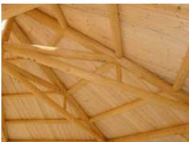
Treliças da estrutura da cobertura do quiosque.
