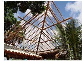
Estrutura tipo Asa-delta, terças em forma de escama de peixe.
