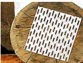
Instalação de chapas com dentes estampados nas extremidades das peças.
