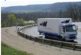
Defensa instalada em margem de curva perigosa.
