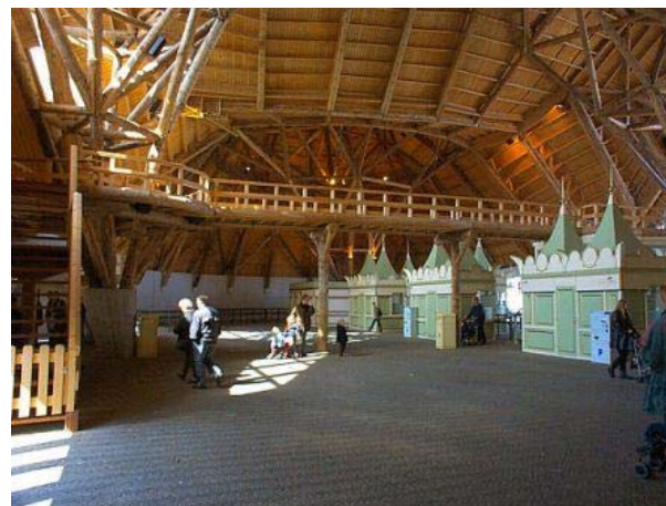
Treliça espacial tipo árvore: Vista parcial da estrutura da cobertura.
