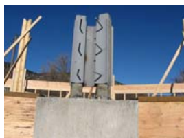
Detalhe das placas de base das colunas.
