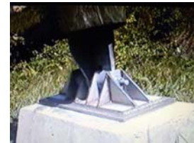
Placa de base de uma das colunas do pórtico .
