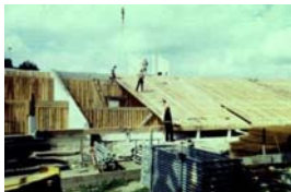
Montagem da estrutura do piso da arquibancada.
