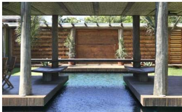
Estrutura do deck coberto. Ao fundo, estrutura do muro.
