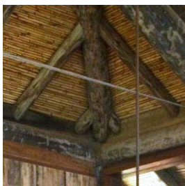
Conexões da base do espigão de madeira roliça do telhado, apoiando sobre a conexão de canto das vigas de madeira roliça.
