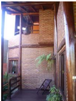
Sacada em balanço, sobre viga com seção bicircular.
