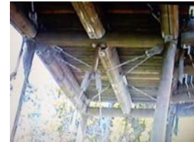
Contraventamentos horizontais e verticais.
