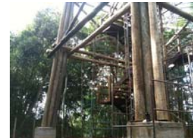
Blocos de concreto armado de coroamento das estacas da fundação.
