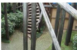
Bases da coluna em contato direto com o solo.
