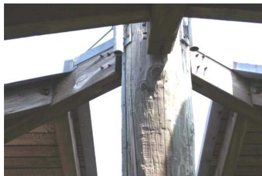
Ligações de Vigas Horizontais com a coluna.
