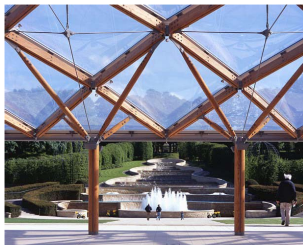
Colunas e escoras inclinadas em V, definitivas de suporte da cobertura com sistema estrutural lamelar com peças de madeira serrada.
