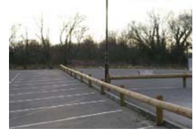
Defensa instalada em estacionamento.
