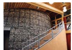
Paredes tipo gabião.
