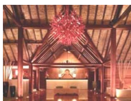
Estrutura com colunas de madeira roliça e vigas de madeira roliça e madeira serrada, na recepção do Resort Four Seasons.
