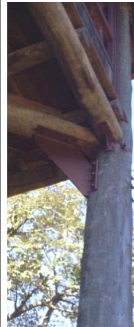
Detalhe das conexões metálicas tipo consoles, parafusados com barras de aço rosqueadas passantes, arruelas e porcas, que unem as vigas da estrutura do piso à coluna de canto.
