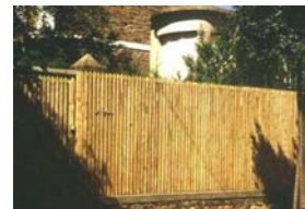
Muros residências c/ madeira roliça de pequeno diâmetro.
