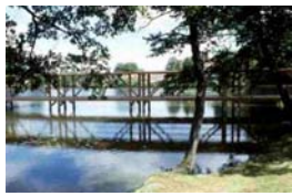
Vista da passarela.
