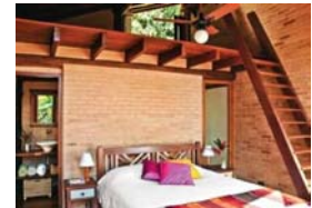
Detalhe dos assoalhos sobre vigas de madeira serrada, apoiadas na viga de madeira roliça de eucalipto.
