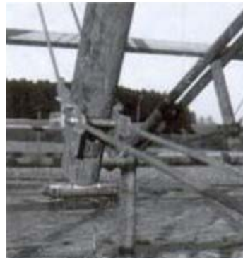
Tirantes com barras de aço, da cobertura do pórtico.
