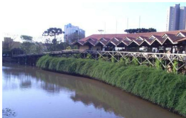
Passarela de acesso ao galpão do museu do jardim botânico.
