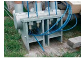
Placa de base do ponto de ancoragem para oito cabos de protensão.
