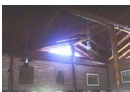
Aberturas na cobertura, para entrada de iluminação natural.
