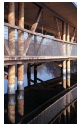
Pórticos formados por colunas compostas duplas.
