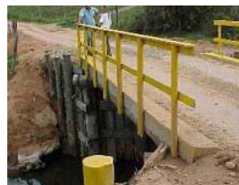
Vista superior da ponte.
