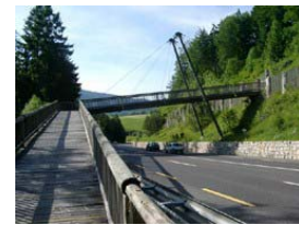
Vista da rampa da Passarela Estaiada
