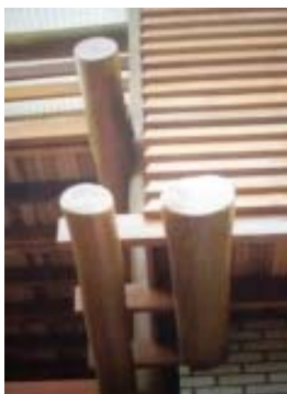
Detalhe frontal da viga dupla que suporta a estrutura do 1º piso, fixadas na coluna inclinada.
