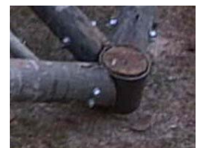
Conexões de canto da estrutura da cobertura.
