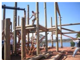
Montagem da estrutura, em Avaré, SP.
