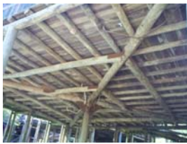
Grelha que compõe a estrutura do piso do Pavilhão Don Duane Willian.
