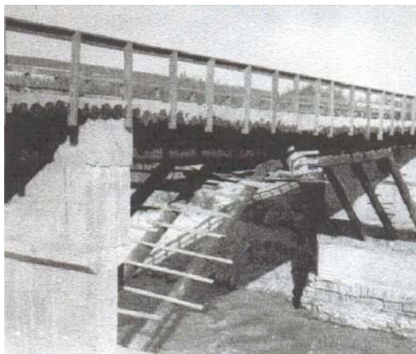
Ponte em Pórtico, Nova Granja Vaspasiano.
