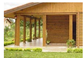
Estrutura da varanda: Peças roliças de seção compostas.
