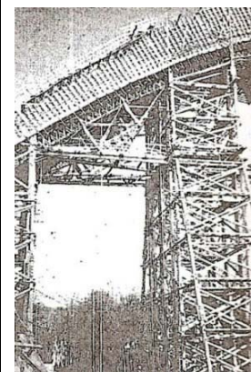
Torre de cimbramento.
