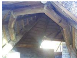
Vista inferior da estrutura dos segmentos de peças roliças.
