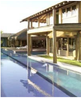
Estrutura da varanda.
