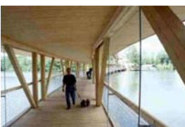
Tabuleiro da passarela.
