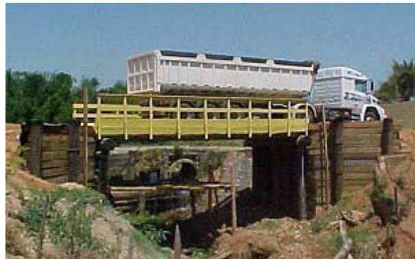
Vista da Ponte Paredão Vermelho.
