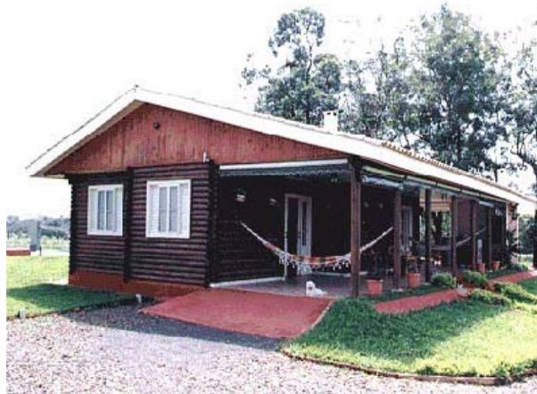
Fachada: estrutura da varanda. Fonte: www.casabella.etc.br
