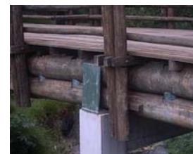
Detalhe do ponto de apoio das vigas, fixadas na placa de base metálica chumbada no pilar.
