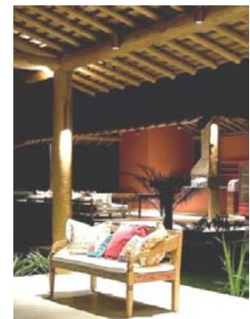
Viga de travamento do pórtico da varanda de acesso à sala.
