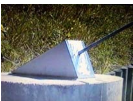
Vista lateral da placa de base de fixação dos estais.
