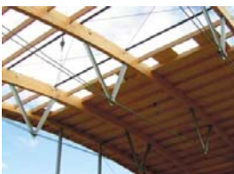
Fechamento da cobertura.
