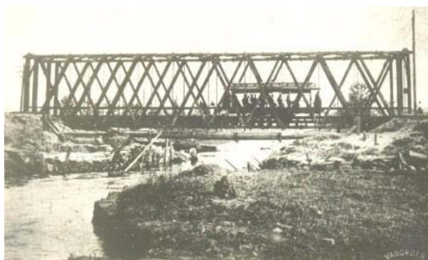
Ponte de madeira com viga em treliça dupla, pendurais de aço, construída sobre o rio Tamanduaei em 1906.
