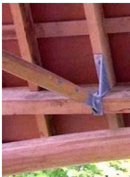
Detalhe da conexão do topo do escoramento com a estrutura da cobertura.
