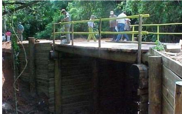
Vista da Ponte Estrada Floresta.
