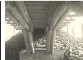
Vista inferior destacando as vigas duplas bicirculares e o tabuleiro com postes.
