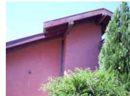
Treças da cobertura com vigas de madeira serrada.
