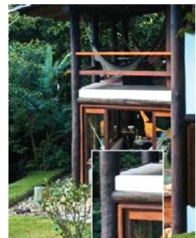
Estrutura da laje da varanda em concreto pré-moldado, apoiada sobre às vigas de madeira roliça de eucalipto.
