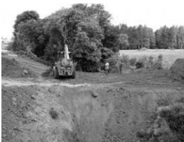
Preparação do terreno com retro-escavadeira.
