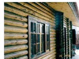
Abertura com instalação de janela.
