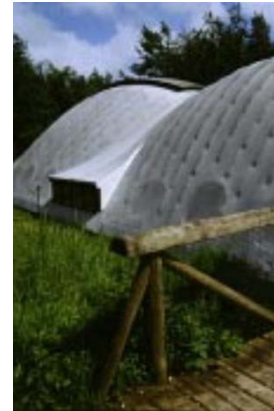
Vista externa da edificação.
