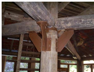
Conexões metálicas tipo consoles, que unem as vigas da estrutura da cobertura à coluna central.
