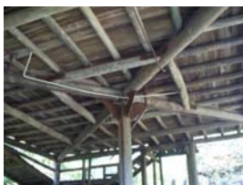
Detalhes das vigas fixadas na coluna central.
