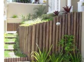
Muro de contenção de jardim.
