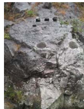
No local existem furos na rocha, para engastamento de colunas.
