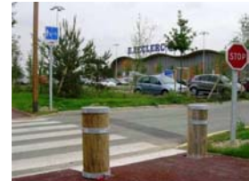
Proteções em calçadas.
