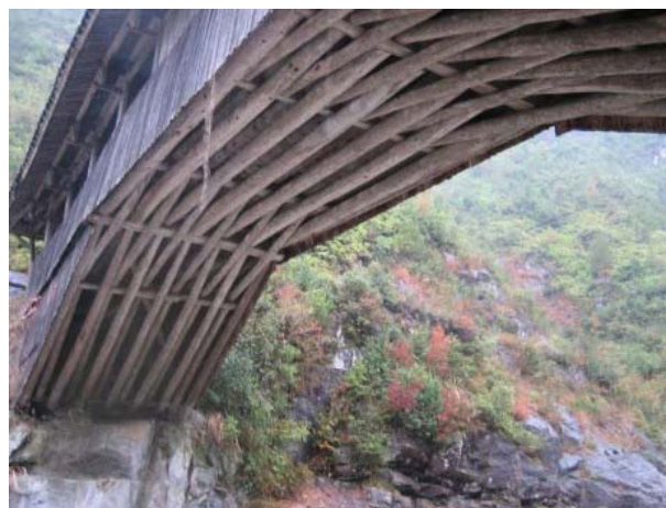
Vista inferior da Passarela Rainbow Santiao. Sistema dos elementos estruturais compostos por peças de madeira roliça, entrelaçados.
