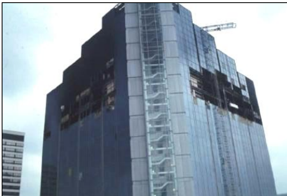
Figura 2.3 – Edifício Broadgate, em Londres, cujo incêndio incentivou experimentos em escala real.
