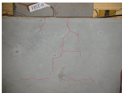
Figura 4.25 - Fissuras na parede transversal posterior
