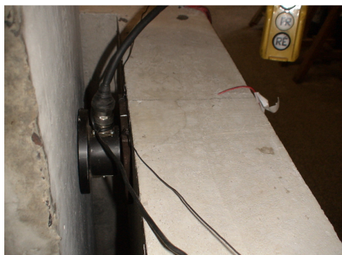
Figura 4.22 - Célula de carga localizada na parede transversal posterior
