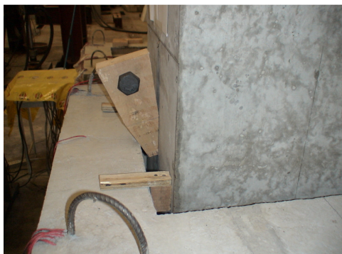
Figura 4.20 - Fixação temporária com utilização de uma cunha
