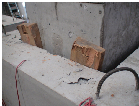
Figura 4.23 - Parede transversal frontal após encunhamento
