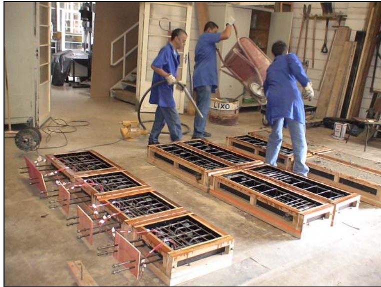
Figura 3.15 - Disposição das fôrmas na concretagem.
