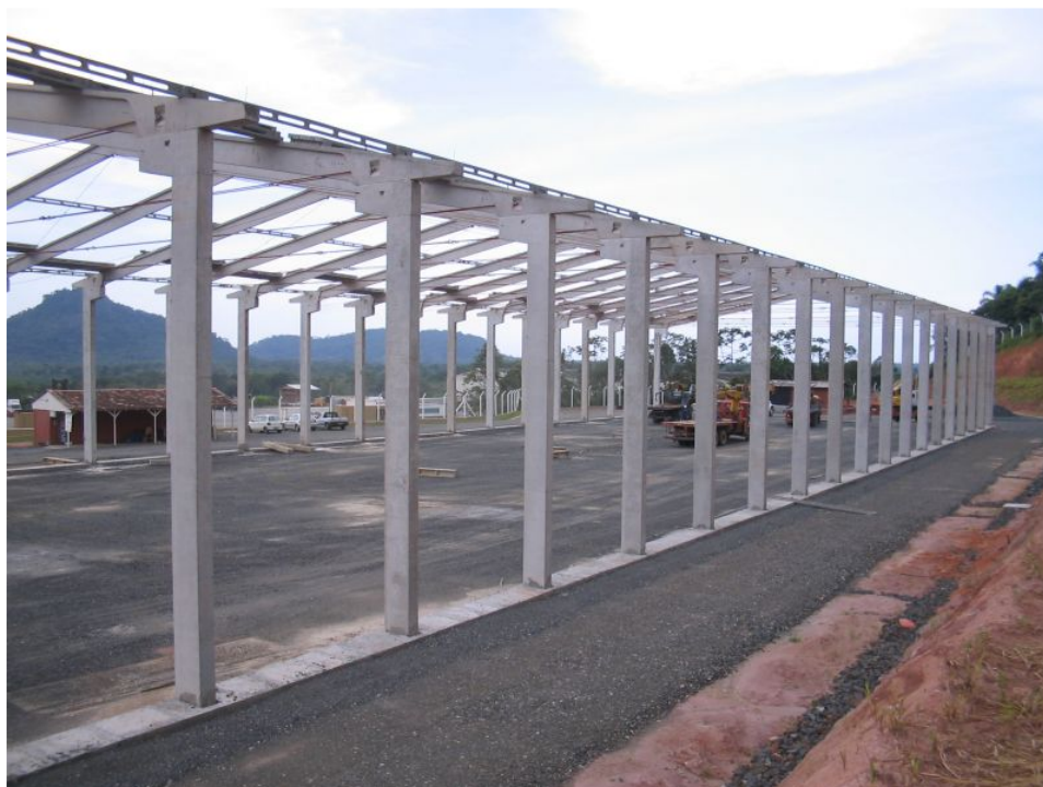
FIGURA 2.9 – Obra sendo executada com o sistema de ligação viga-pilar com chumbadores e consolo horizontal. (Fonte: www.antares.ind.br ).
