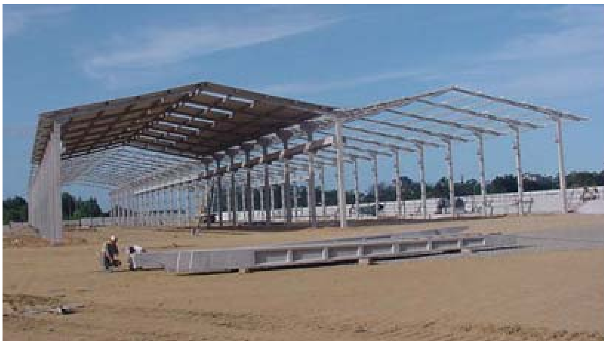
FIGURA 2.11 – Obra sendo executada com o sistema passante de ligação viga-pilar. (Fonte: www.predalle.com.br ).
