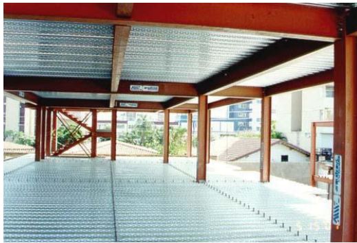
a) Laje mista (USIMINAS MECÂNICA,2005)
