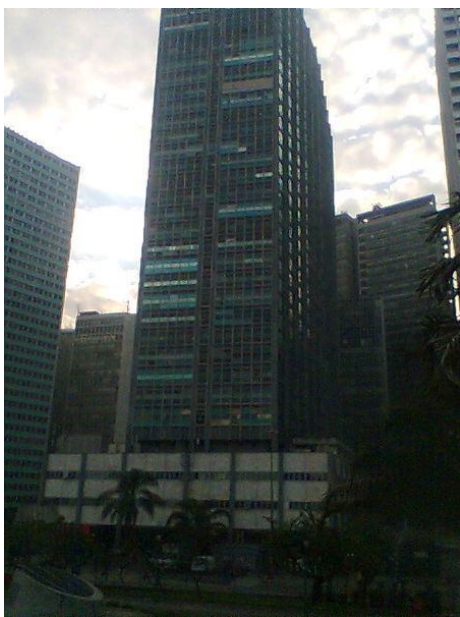
a) Edifício Avenida Central – Rio de Janeiro
