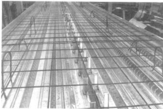
Figura 2.23 – Conector da Hilti HVB em formas de aço (QUEIROZ et al., 2001)
