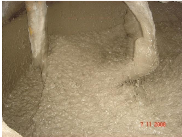
b) aspecto do concreto após o uso de superplastificante
