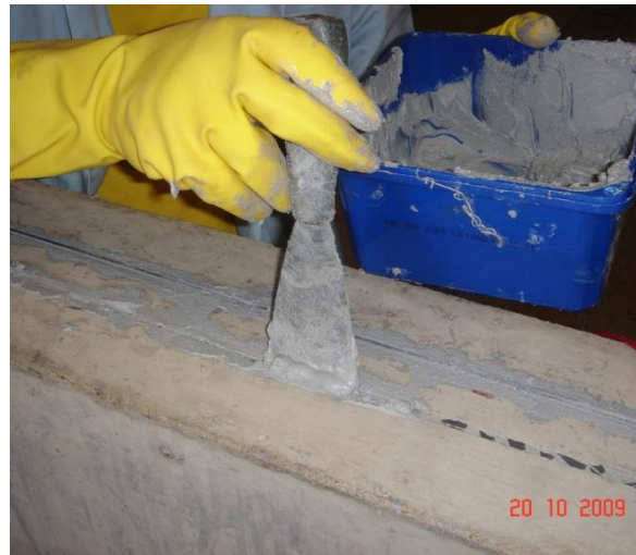
b) aplicação da resina no entalhe
