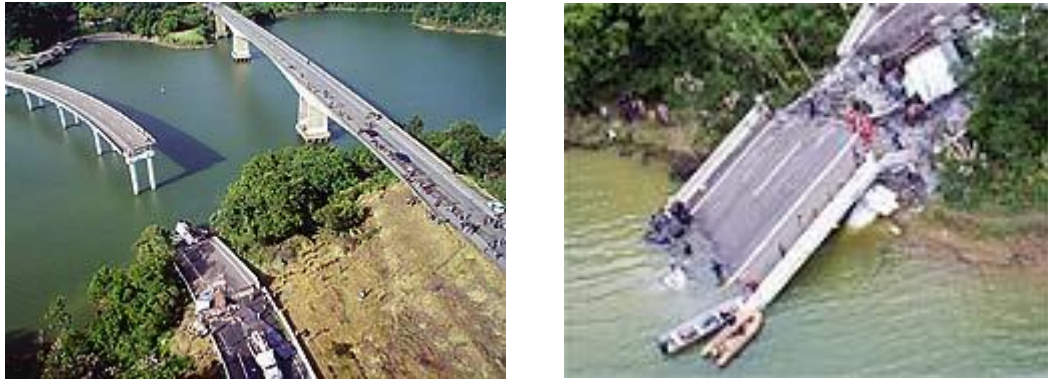
Figura 1.1 - Desmoronamento da ponte sobre o rio Capivari em janeiro de 2005
