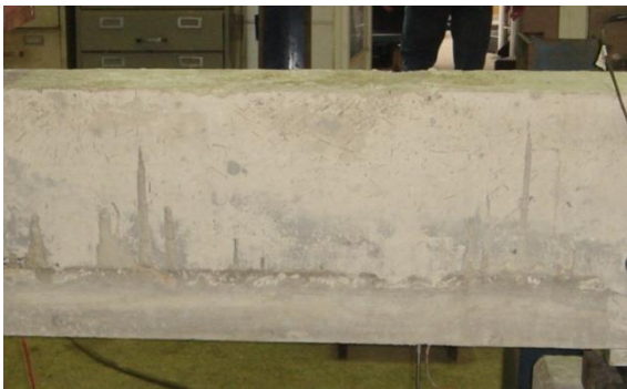
c) aspecto final da reabilitação
