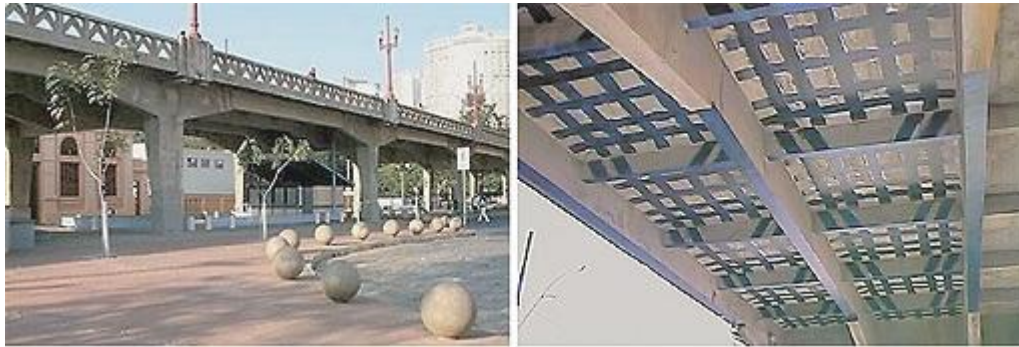
Figura 1.5 - Reforço do viaduto de Santa Teresa em Belo Horizonte – MG.
