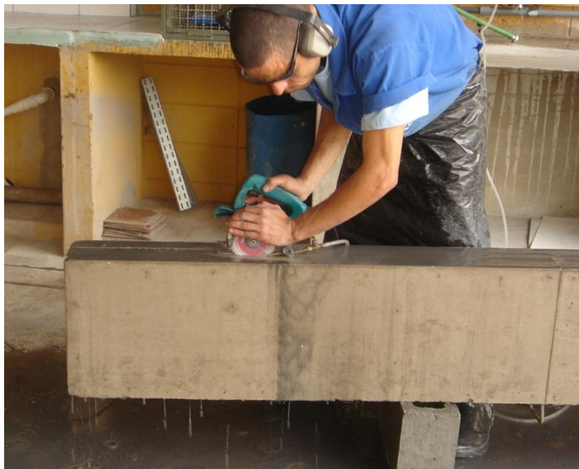
Figura 5.7 - Execução do entalhe por meio de via úmida
