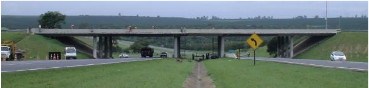
Figura 1.3 - Vista do viaduto O.A.E. que liga Analândia à Itirapina
