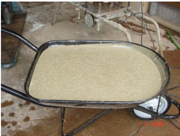
c) fluidez do concreto
