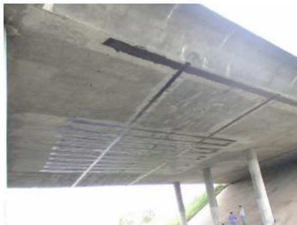
Figura 1.4 - Situação do viaduto antes (acima) e após (abaixo) recuperação e reforço
