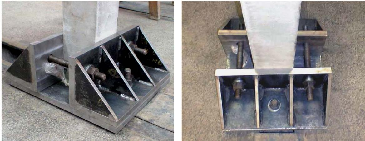
Figura 73 – Dispositivos metálicos para fixação das bases dos pilares.
