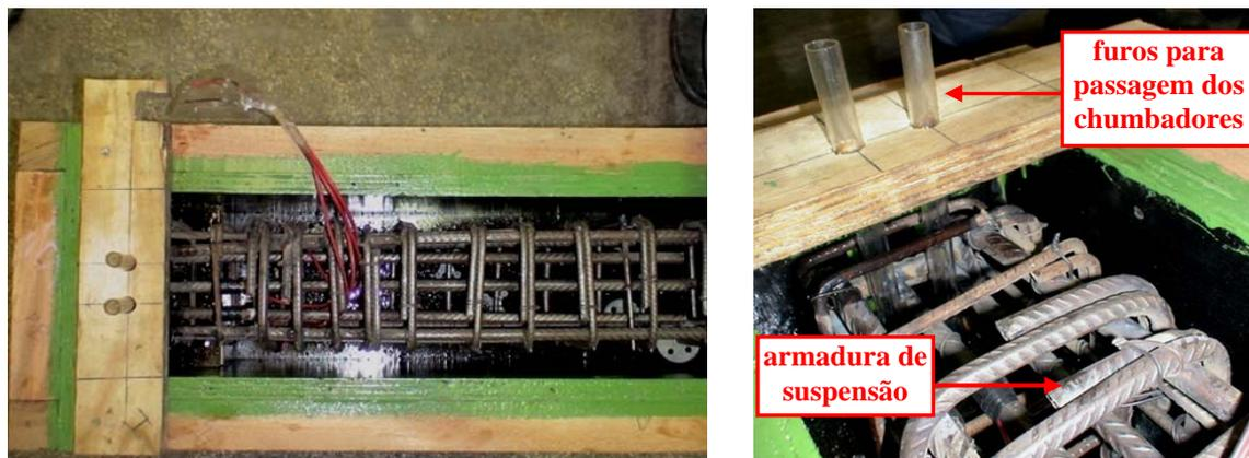
Figura 83 – Fôrma e armadura da viga e dentes.
