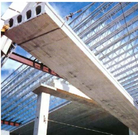
Figura 15 – Exemplo de estrutura pré-moldada – painel alveolar de grande vão.
