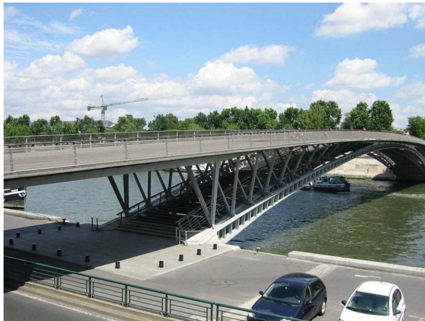
Figura 2.6: Passarela Solferino. Fonte: Dallard et al. (2001)
