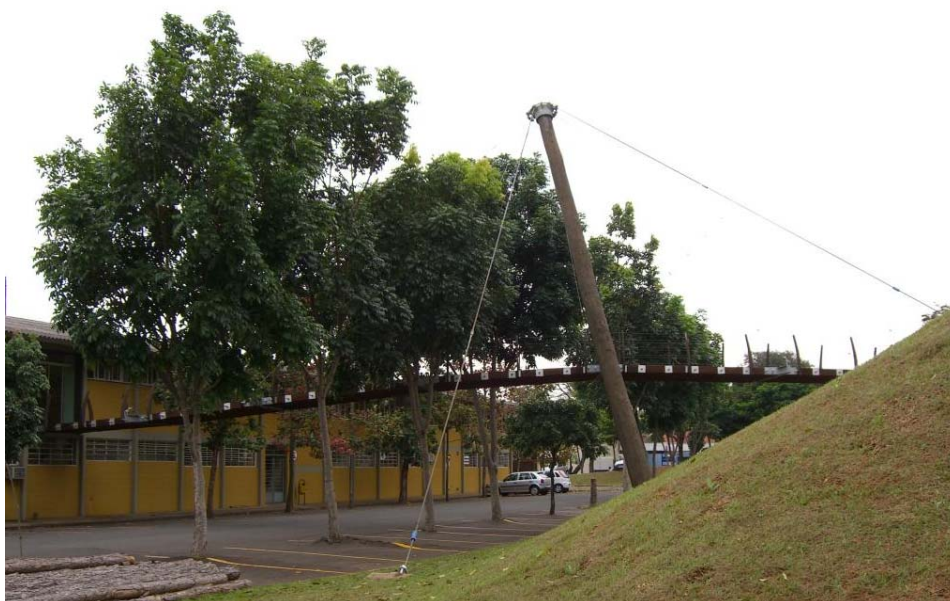
Figura 2.17: Passarela estaiada de madeira
