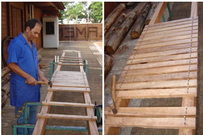
Figura 7.3: Montagem do modelo reduzido
