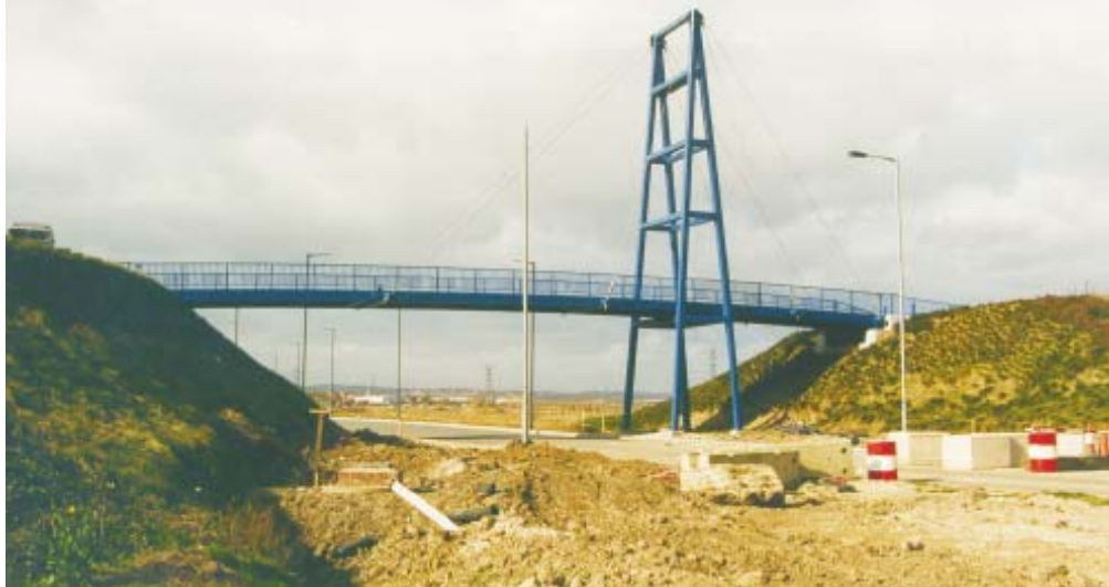
Figura 2.16: Passarela estaiada. Fonte: Pimentel et al. (2001)
