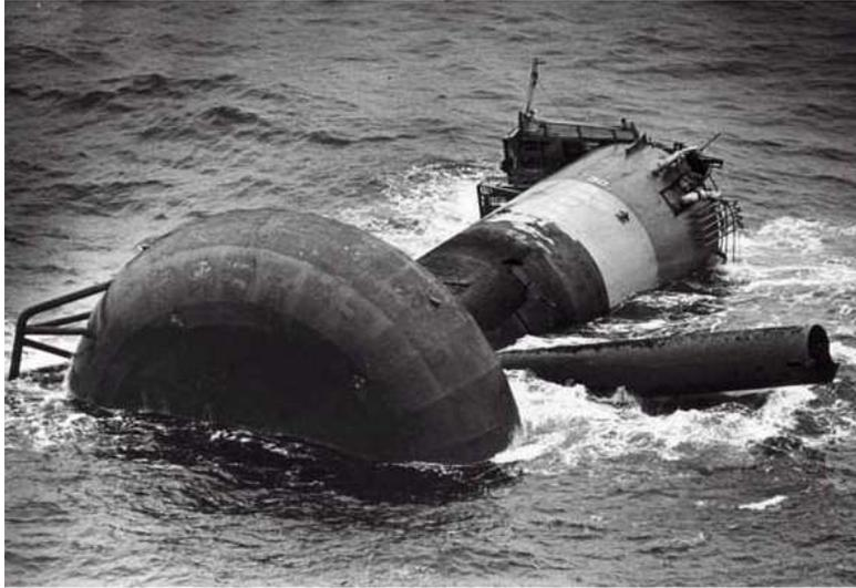
Figura 2.4: A. L. Keilland. Suporte da base quebrado devido à ruptura na solda
