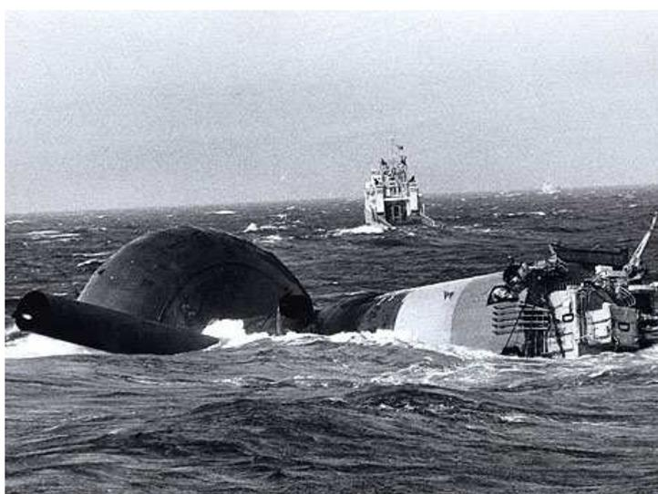
**Figura 2.3:** Plataforma *A. L. Keilland* após o acidente
