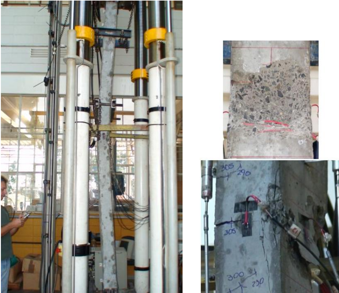
Fig. 6.25 – Final do ensaio para o Pilar 100M12 mostrando suas fissuras e o descolamento do revestimento do pilar 50H12.
