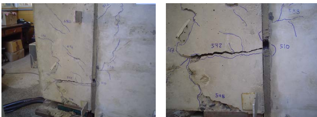
Figura 4.38: Estado de fissuração do bloco externo do modelo 11
