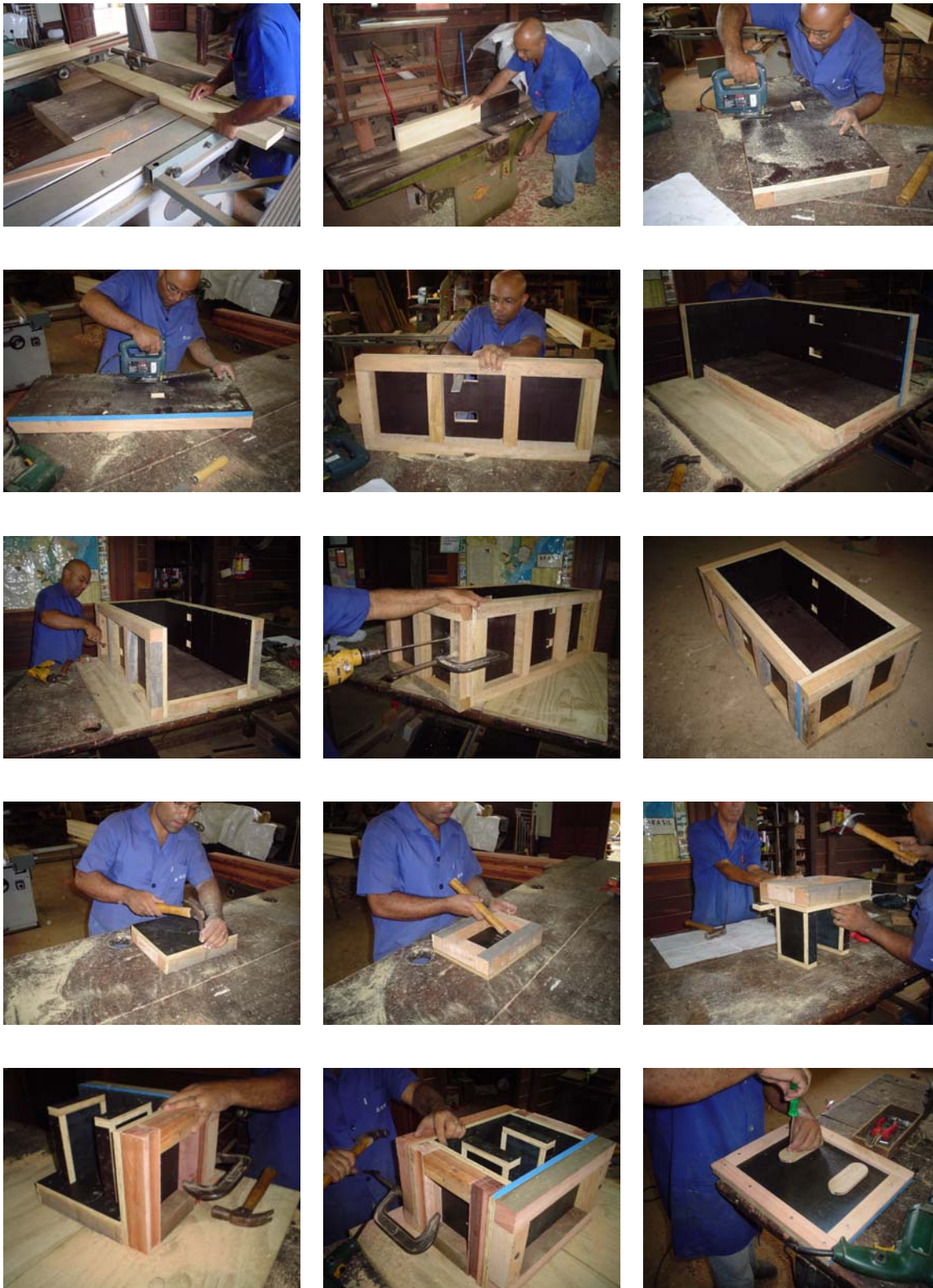
Figura 3.16: Seqüência de execução das formas de madeira
