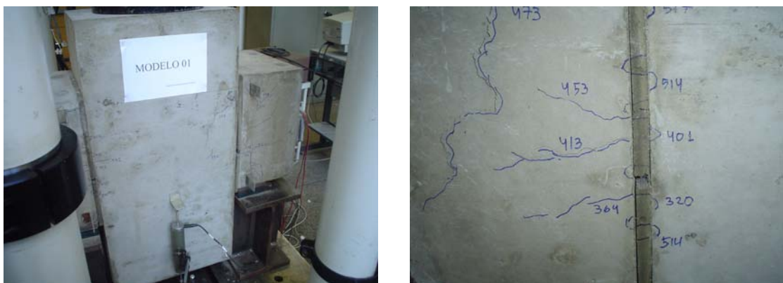
Figura 4.15: Aspecto da fissuração do modelo 01
