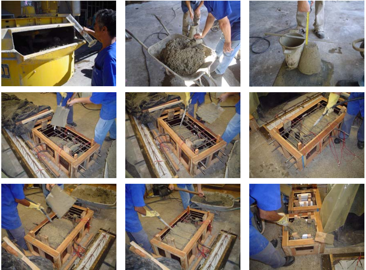
Figura 3.20: Concretagem do modelo 03.
