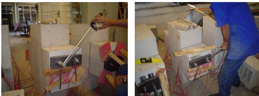
Figura 3.24: Aperto das porcas na montagem dos blocos externos
