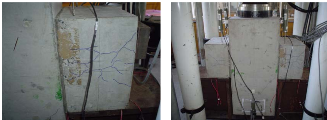
Figura 4.8: Aspecto da fissuração do modelo 03
