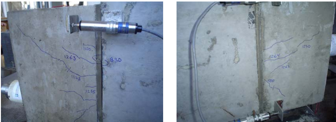
Figura 4.30: Aspecto da fissuração dos blocos externos do modelo 09.
