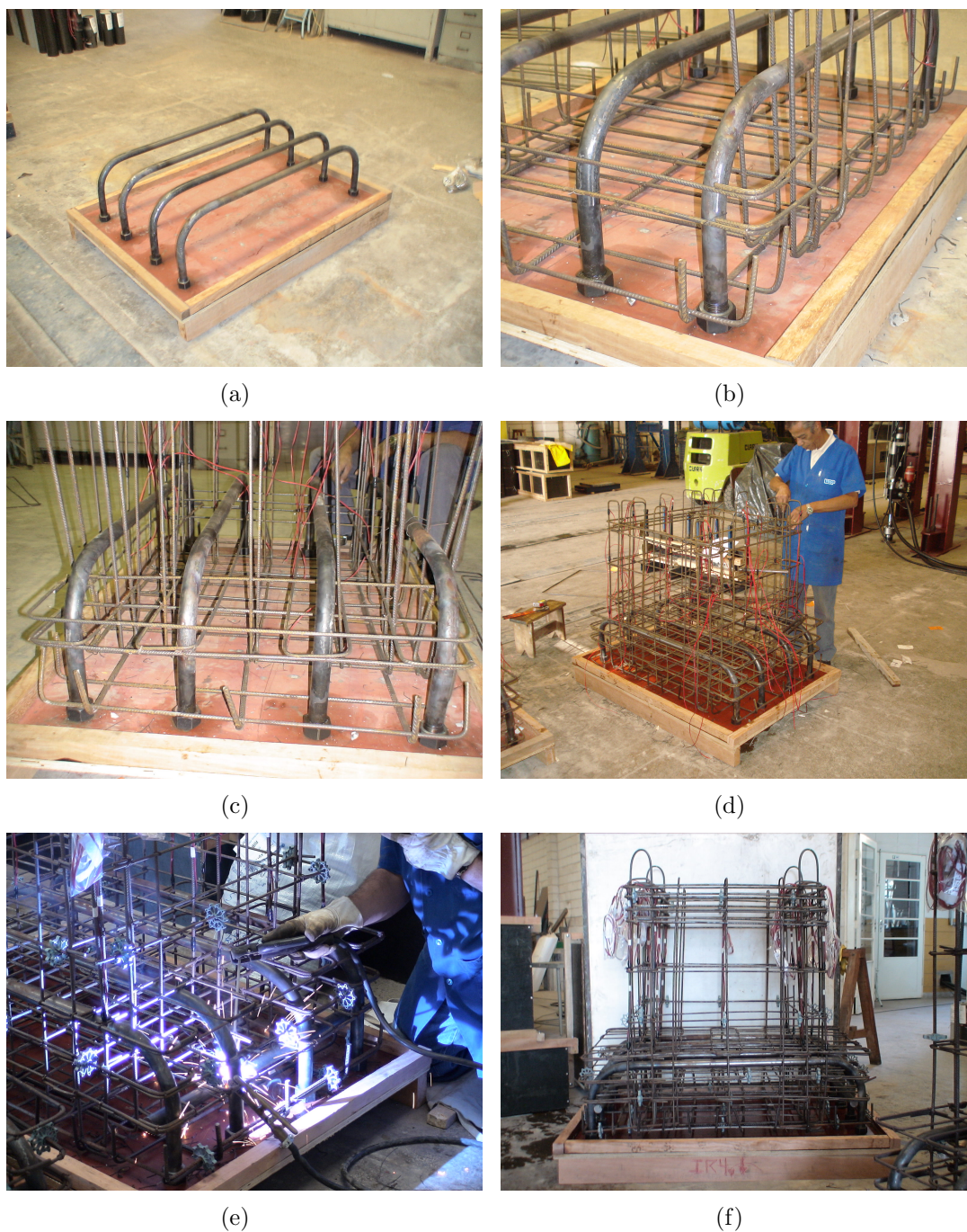
Figura 3.20: Montagem das armaduras do protótipo IR4: (a) Posicionamento dos chumbadores; (b) Posicionamento das armaduras verticais; (c) Montagem da armadura da base da fundação; (d) Montagem das armaduras horizontais; (e) Aplicação da solda nos chumbadores; (f) Modelo montado
