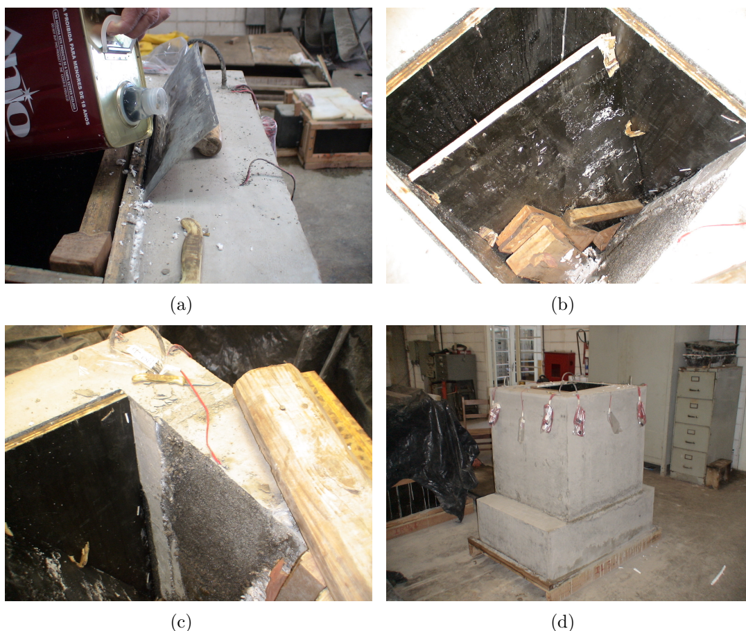
Figura 3.24: Retirada das fôrmas dos cálices: (a)Aplicação do solvente; (b) Retirada da parte interna da fôrma ; (c) Aspecto da parte interna do cálice; (d) Cálice pronto;
