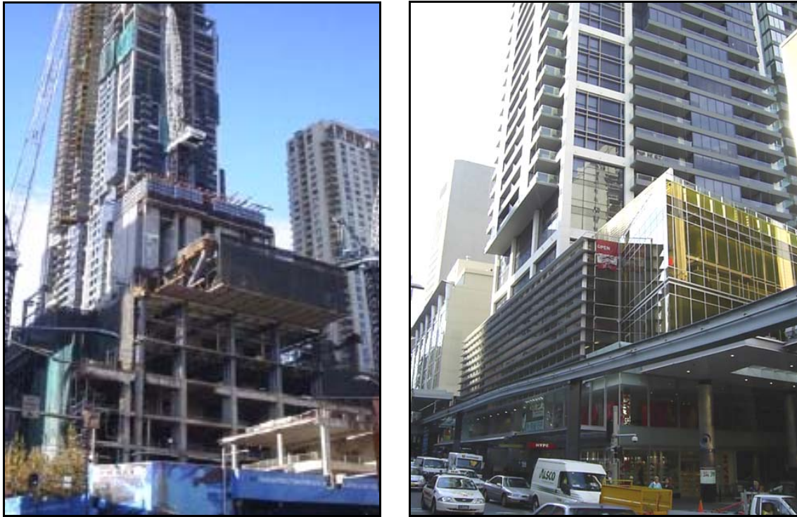
Figura 2.5 - Edifício Latitude Building (Sidnei – Austrália, 1990), com 55 pavimentos. Fonte: http://www.sydneyarchitecture.com/cbd/cbd3-013.htm .
