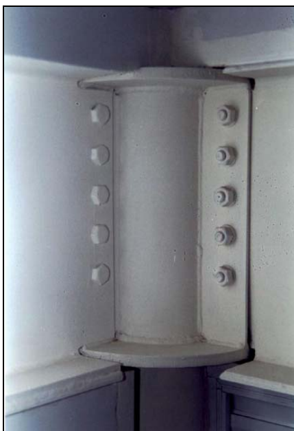
Figura 2.8 - Ligação viga-coluna com chapa simples e diafragmas externos. Fonte: Carvalho (2005).
