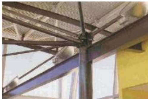
Figura 1.3 - Ligação entre viga de seção tipo I e coluna. Fonte: Revista Finestra (2000).
