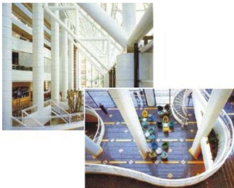
Figura 1.1 - Colunas de sustentação à estrutura treliçada em aço. Fonte: Revista Finestra (1999).
