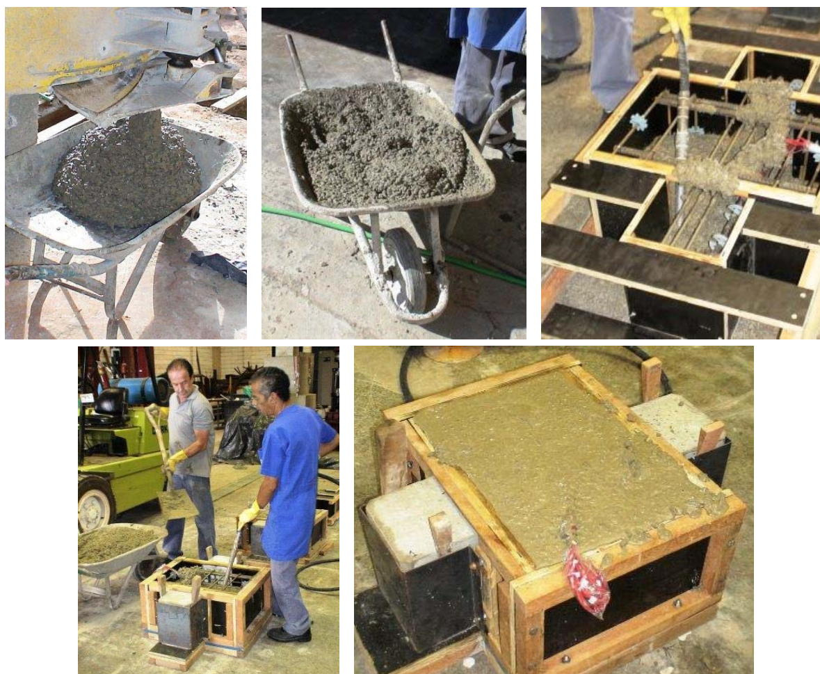
Figura 3.37 - Detalhes da concretagem dos trechos de pilar.
