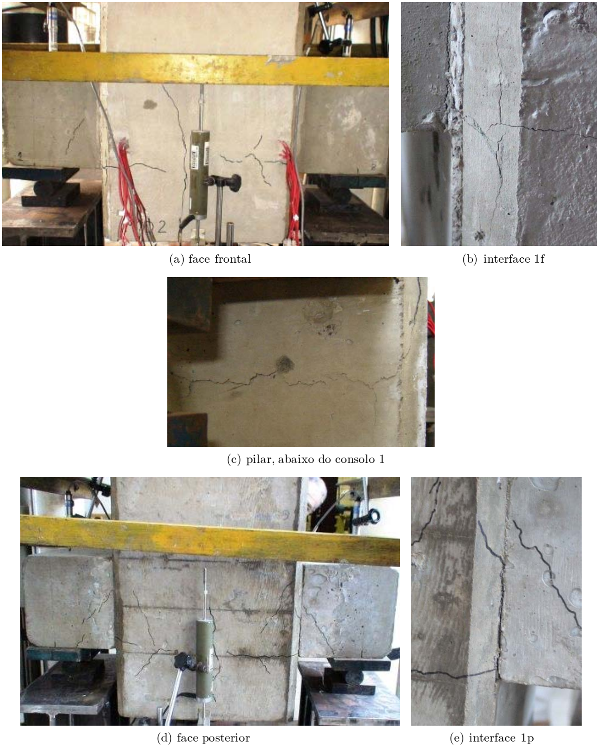
Figura 4.9 - Quadro de fissuração do modelo MBC2.
