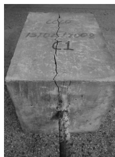
Vista inferior de ruptura
