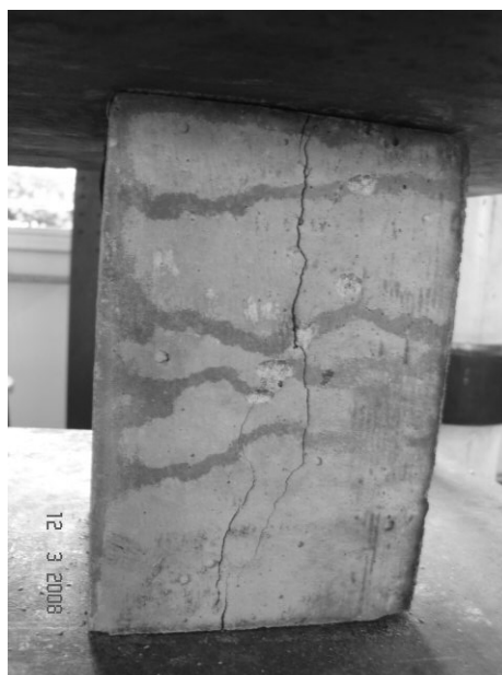
Ruptura por fendilhamento
