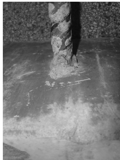
Ruptura por deslizamento da barra Vista superior
