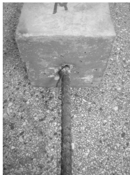
Ruptura do concreto por fendilhamento barra Vista inferior
