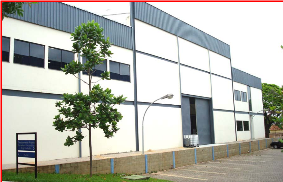
Figura 7.66: Vista geral do Edifício Fábrica do Milênio, Eng. Produção da EESC/USP
