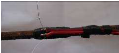
(c) Colocação do fio.
