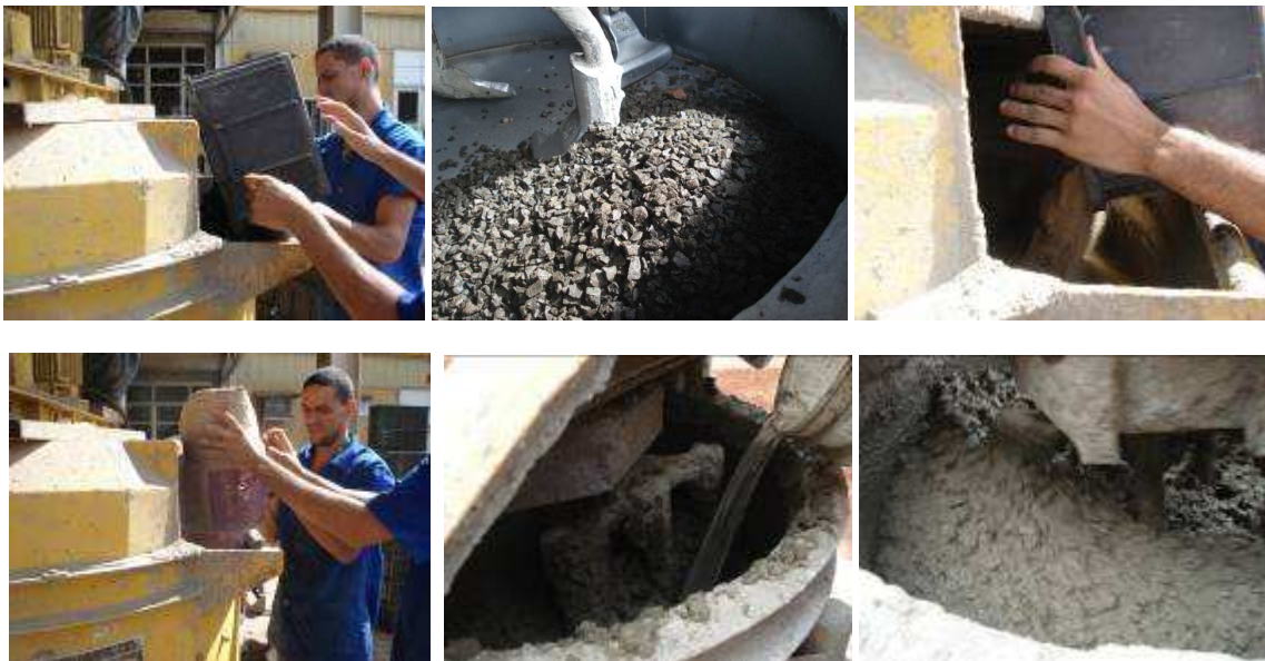
Figura 3.36. Colocação dos materiais na betoneira para a produção do concreto.
