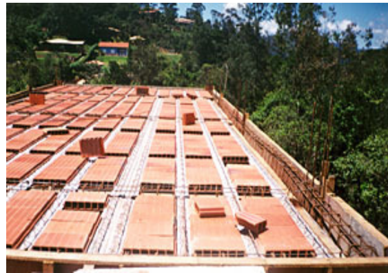
Figura 2.15b – Laje bidirecional
