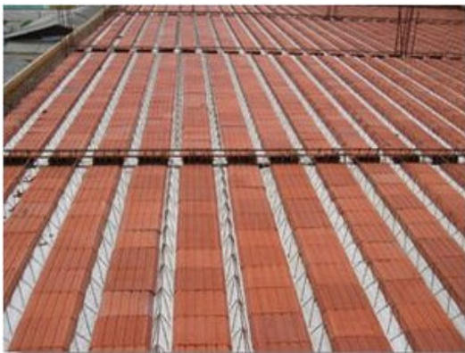
Figura 2.15a – Laje unidirecional
