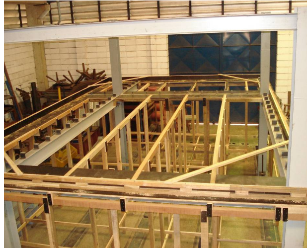
Figura 3.6 – Vista da estrutura após a montagem da forma
