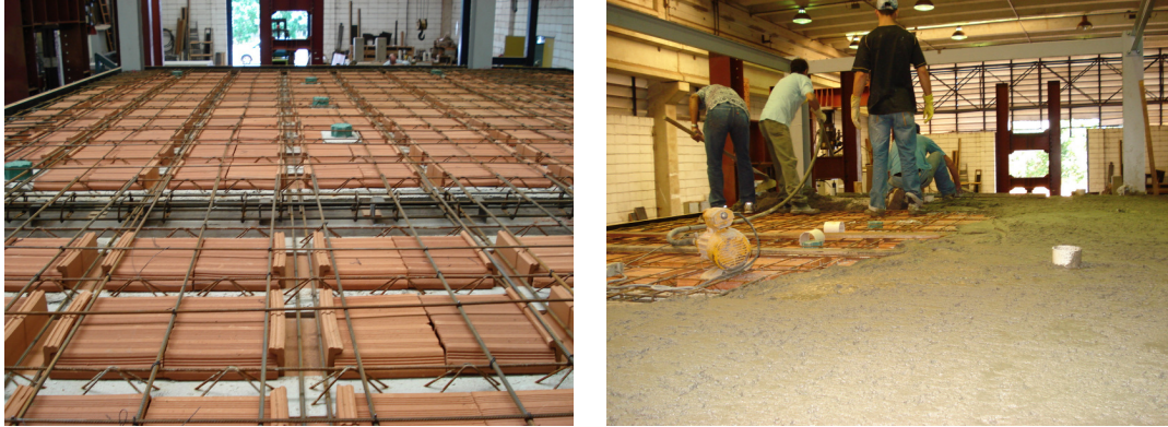
Figura 3.9 – Vista geral da laje com as armaduras posicionadas e concretagem da laje
