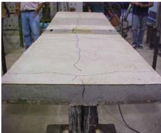
Figura 2.23– Fissura longitudinal viga mista com laje treliçada – DAVID (2003)
