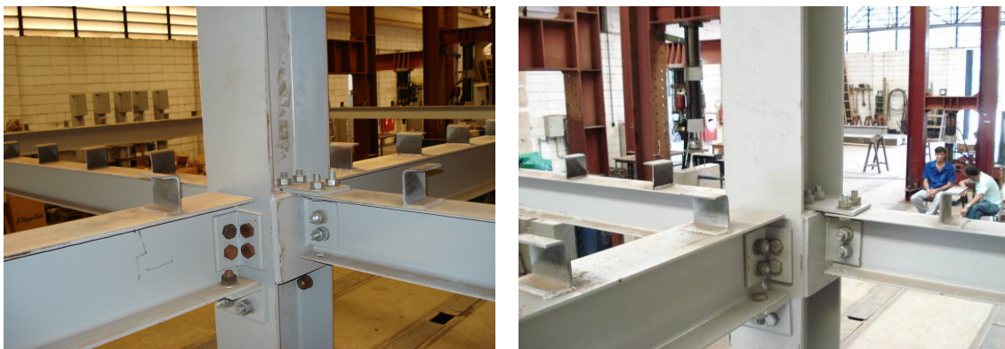
Figura 3.5 – Ligações parafusadas dos pilares de centro e de borda
