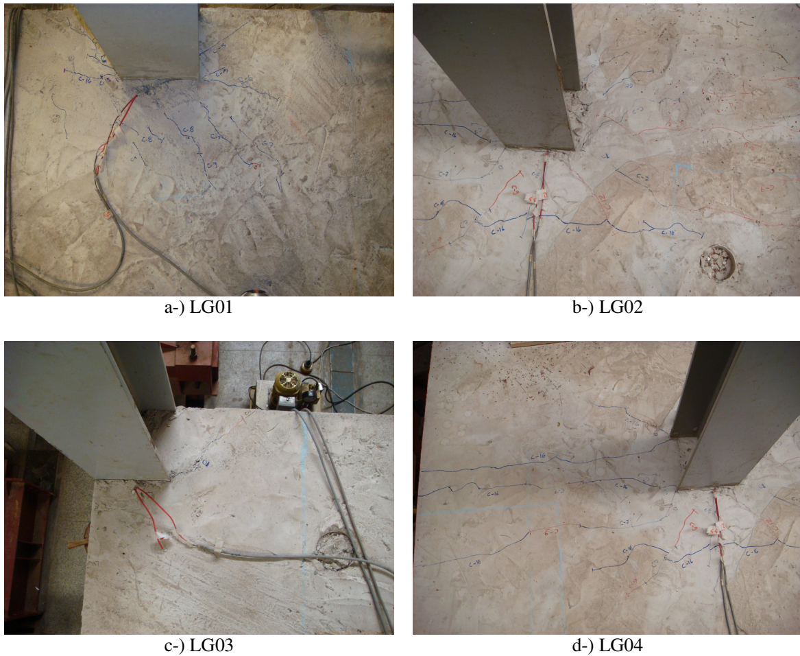
Figura 4.63 – Vista da fissuração - 8ª etapa de carregamento concentrado
