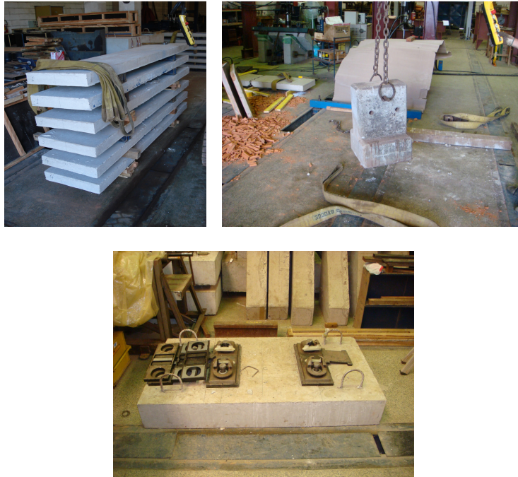
Figura 3.11 – Elementos de concreto utilizados no carregamento distribuído na laje
