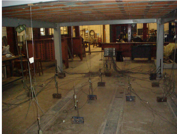
Figura 3.33 – Vista dos transdutores posicionados sob o pavimento tipo.
