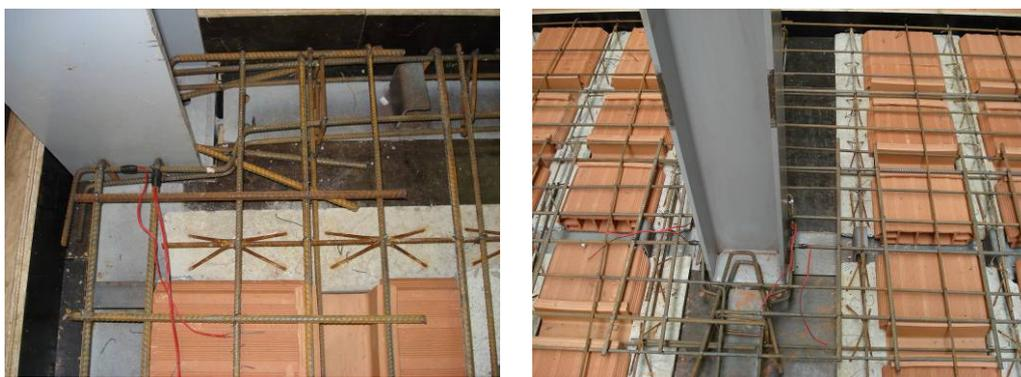
Figura 4.38: Extensômetros das armaduras da laje do pavimento tipo.
