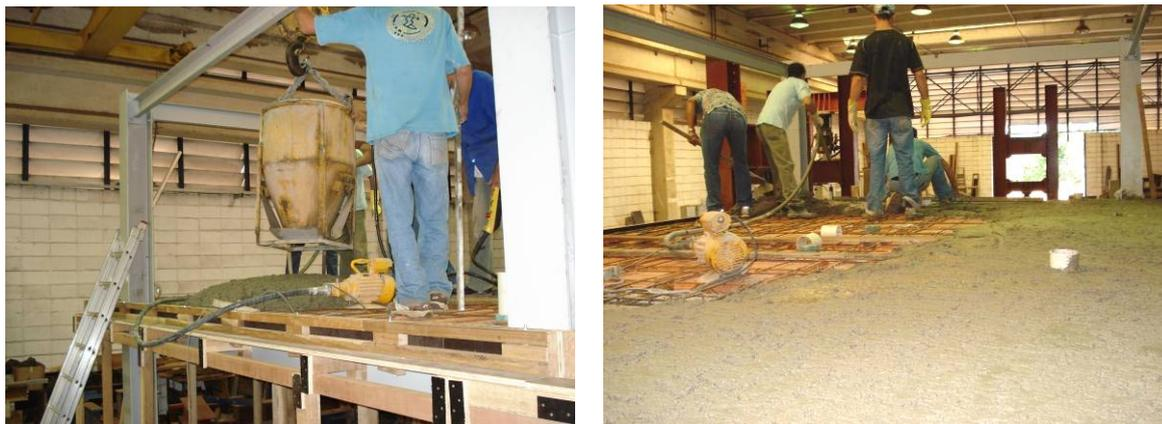
Figura 4.28: Sequência de concretagem do pavimento tipo.
