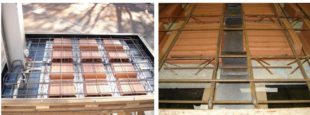
Figura 4.9: Disposição das armaduras do protótipo TNRSS antes da concretagem e detalhe da continuidade da armadura das vigotas.
