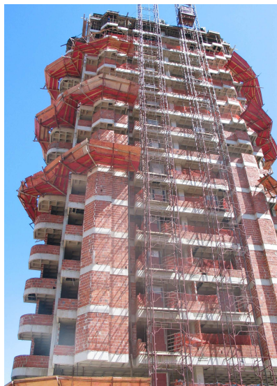
Figura 5.3 – Obra no 15º tipo
