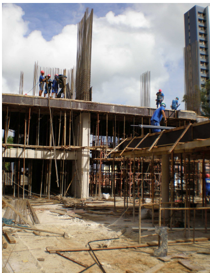
Figura 5.2 – Obra no 1º tipo
