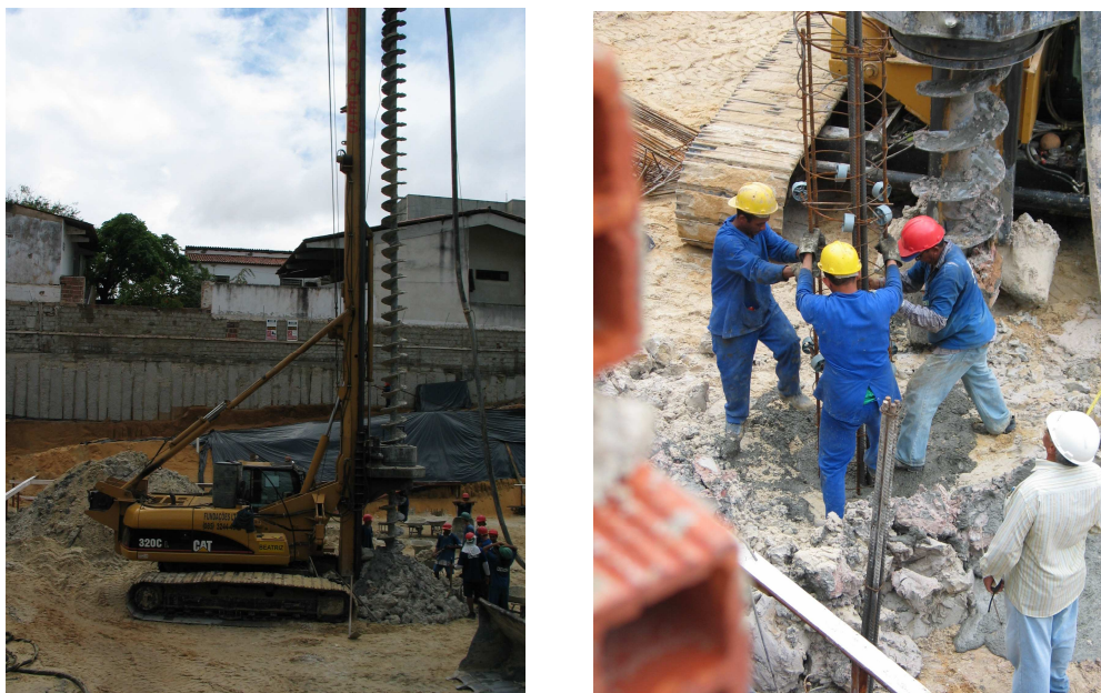
Figura 5.15 – Execução das estacas hélices contínuas
