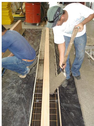
**Figura 5.25** – Concretagem das vigas mistas
