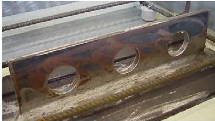
**Figura 2.16** – Conector tipo *perfobond*. Fonte: Valente e Cruz (2004)
