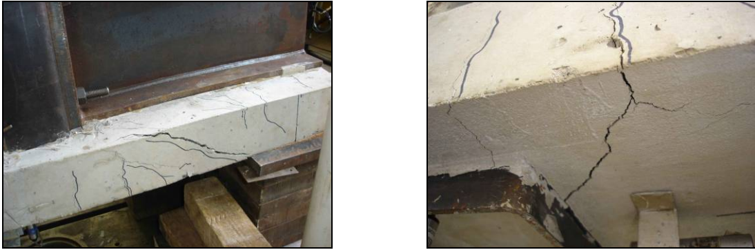
Figura 5-20 – Fissuração na laje do modelo CC_W
