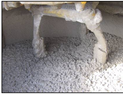
a) Concreto fresco
