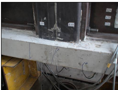
a) Aparecimento das primeiras fissuras – Modelo CC_SB
