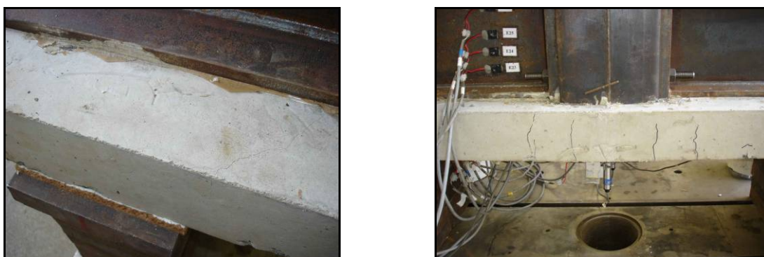
Figura 5-19 – Aparecimento das primeiras fissuras no modelo CC_W
