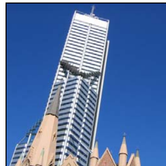
d) Central Park Tower – Perth, Austrália. Estrutura Mista
