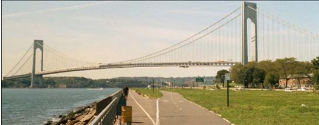
Figura 1.6 – Ponte Verrazano Narrows (Fonte: www.mta.nyc.ny.us ).
