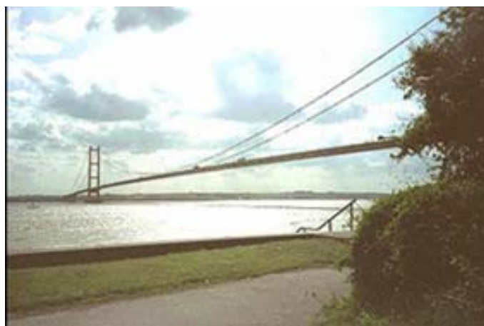
Figura 1.13 – Ponte Humber (Fonte: www.humberbridge.co.uk ).
