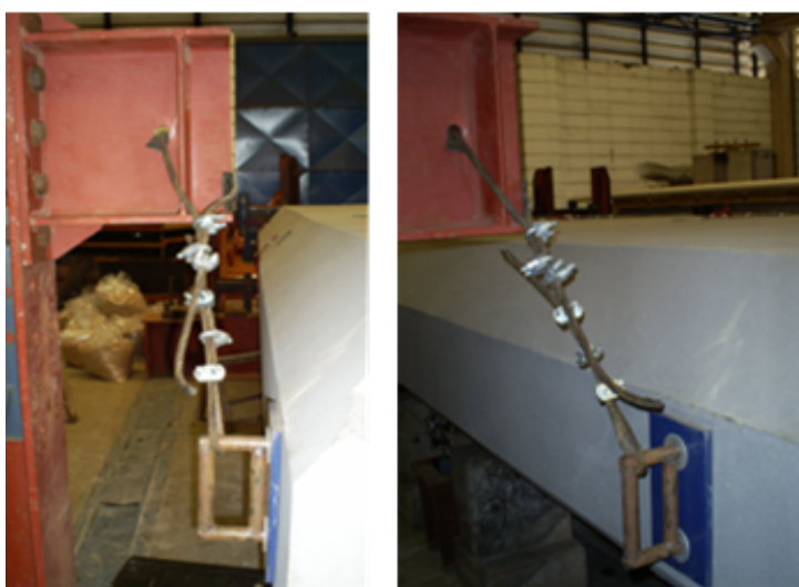
Figura 5.24 – Cabo de aço e pórtico para simular o estal.
