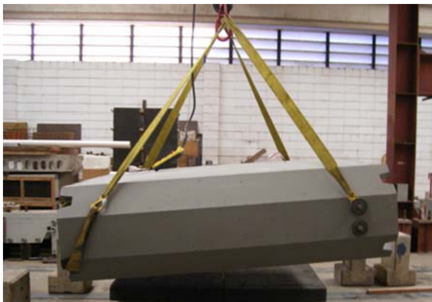
Figura 4.35 – Transporte horizontal da aduela.
