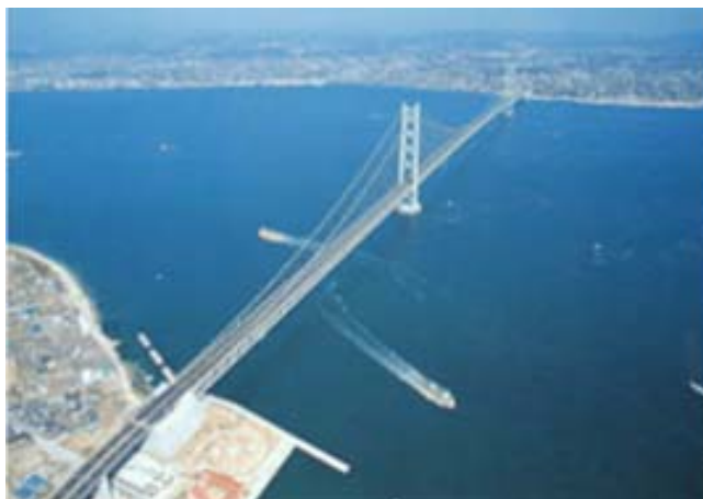
Figura 1.10 – Ponte Akashi Kaikyo (Fonte: www.hsba.go.jp ).
