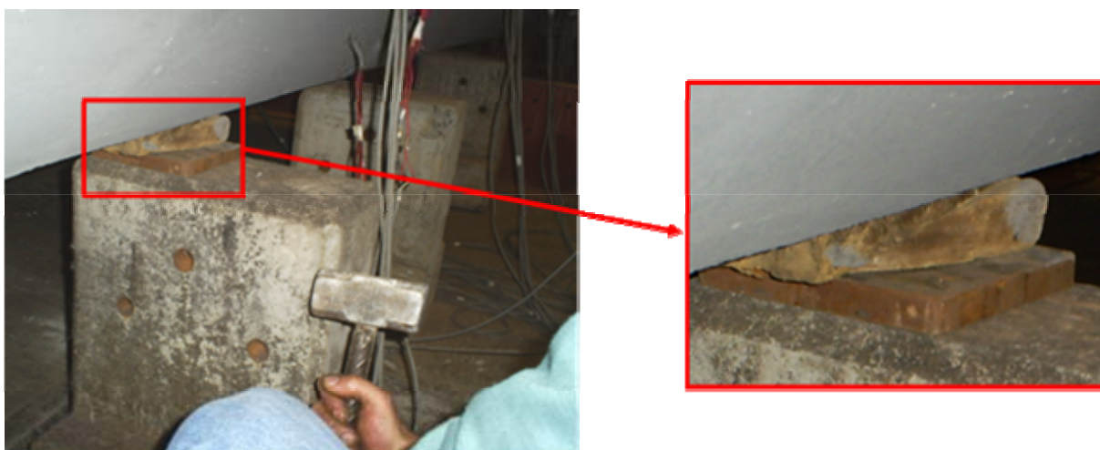
Figura 5.22 – Detalhe da retirada das cunhas do apoio da Aduela II.
