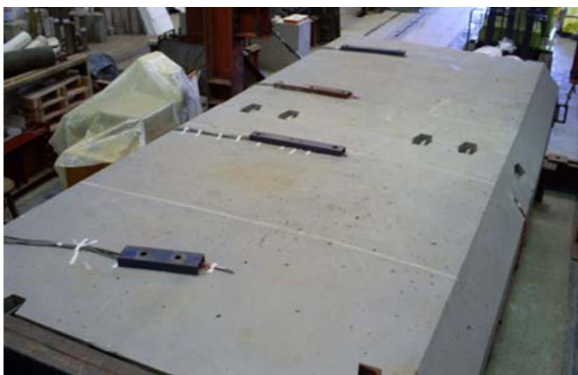
Figura 5.29 – Aduelas depois de retirar o carregamento distribuído.
