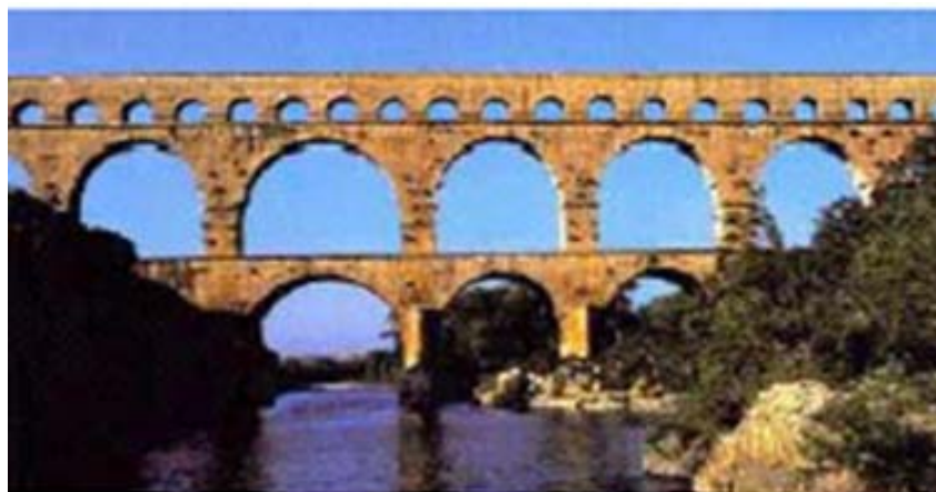
Figura 1.2 – Aqueduto “Pont du Gart”(Fonte: www.pbs.org ).
