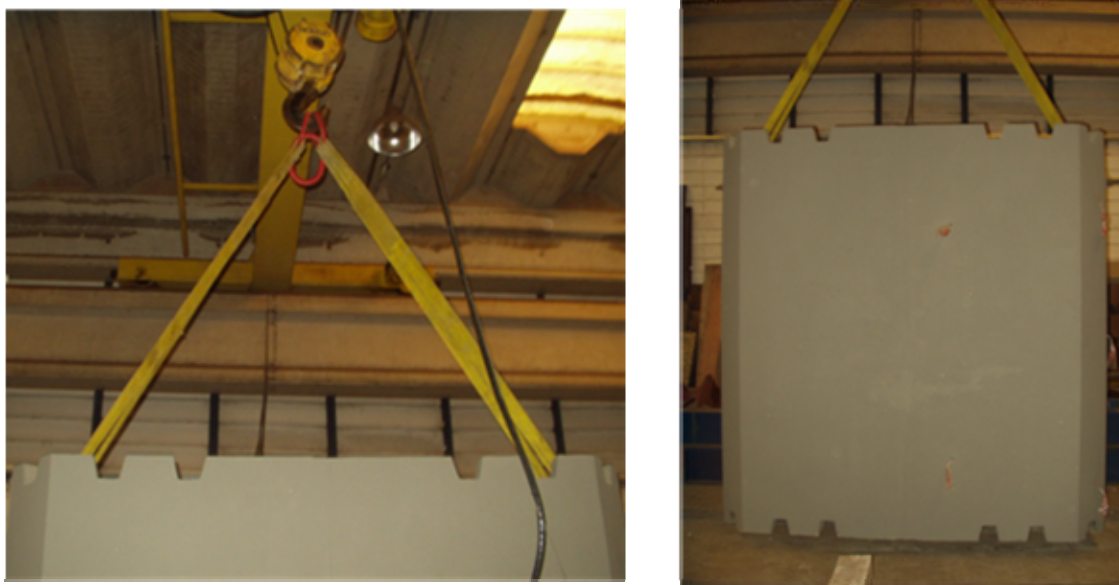
Figura 4.34 – Transporte vertical da aduela.
