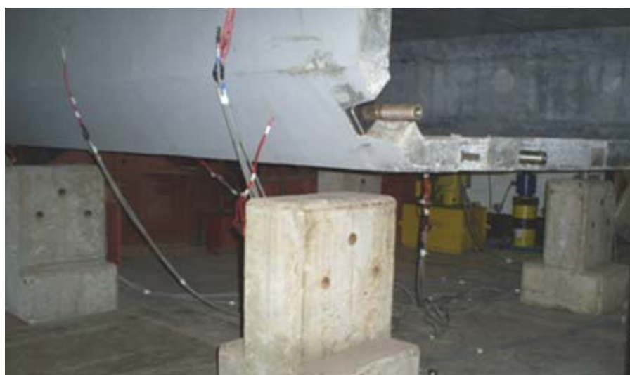
Figura 5.18 – Detalhe da Aduela I em balanço.
