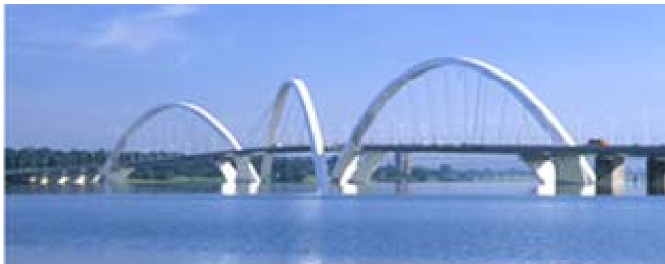
Figura 1.17 – Ponte Juscelino Kubitschek. Brasília 2002 (Fonte: www.transportes.gov.br ).
