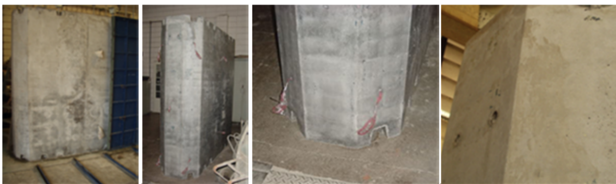
Figura 4.33 – Detalhe das aduelas após a desmoldagem.
