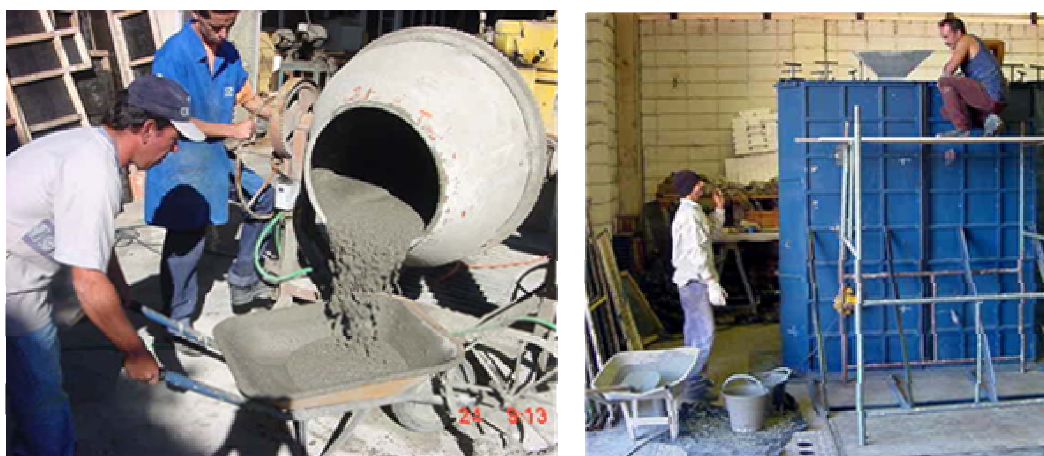
Figura 4.30 – Transporte do concreto da betoneira para a forma e preenchimento do molde.
