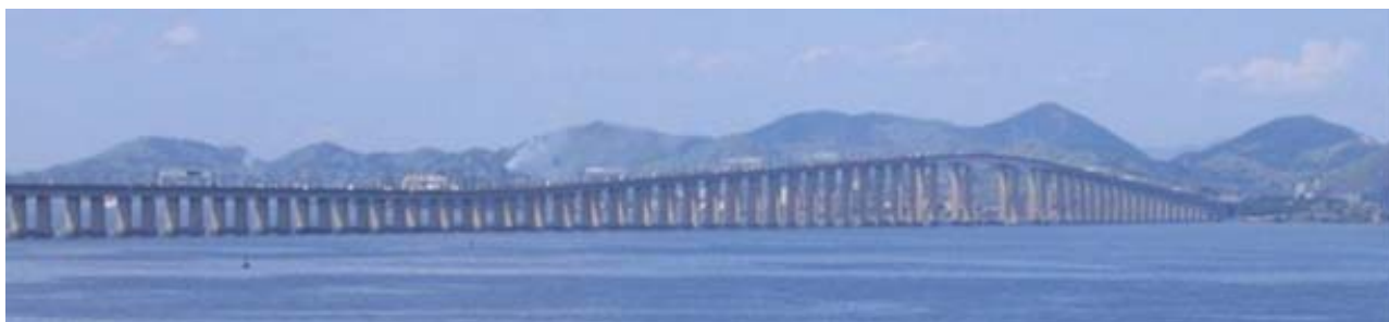
Figura 1.15 – Ponte Rio-Niterói (Fonte: www.transportes.gov.br ).
