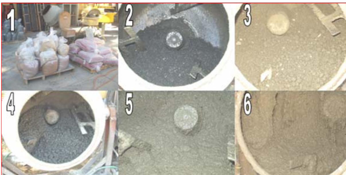
Figura 4.28 – Seqüência e tempo de inserção dos materiais na betoneira.
