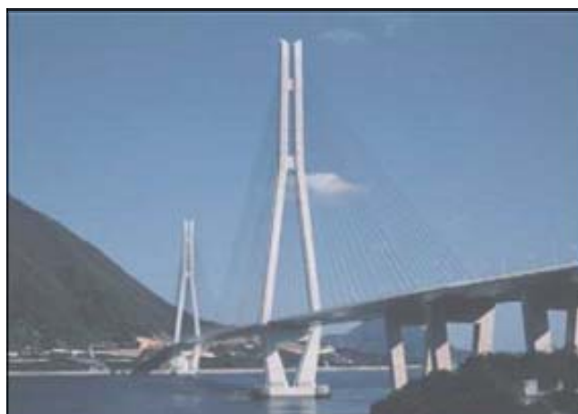
Figura 1.11 – Ponte Tataru (Fonte: www.hsba.go.jp ).
