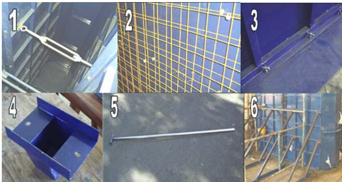
Figura 4.26 – Seqüência de montagem da forma metálica.
