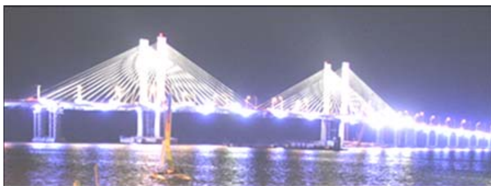
Figura 1.18 – Ponte Construtor João Alves.
