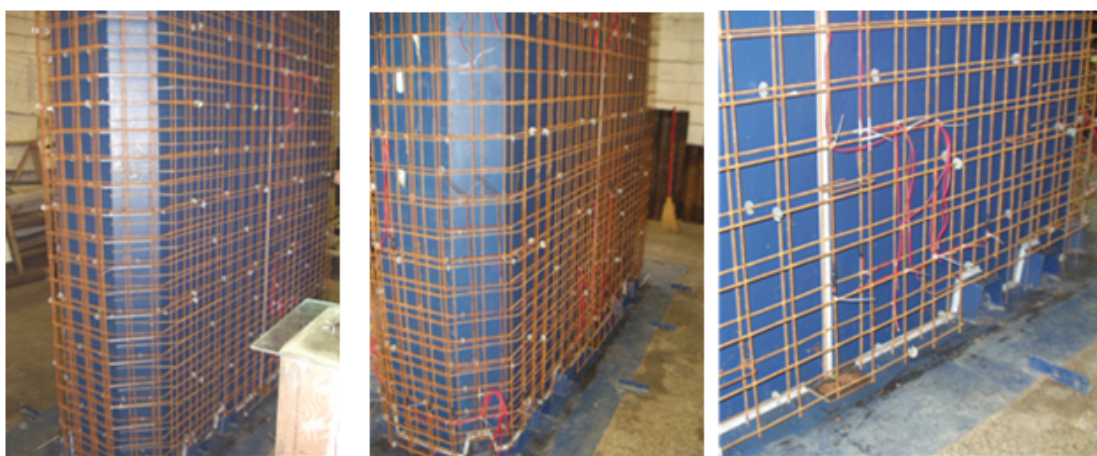
Figura 4.25 – Documentação fotográfica da tela soldada encaixada na forma metálica.
