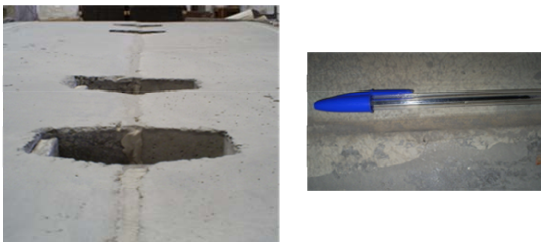
Figura 5.20 – Detalhe da junção das aduelas após preenchimento com argamassa.
