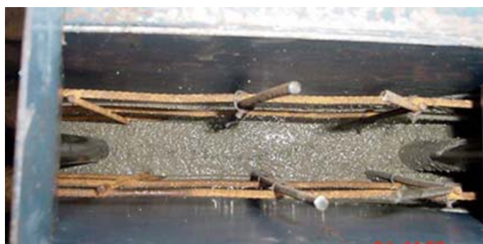
Figura 4.32 – Detalhe do preenchimento do concreto na forma.
