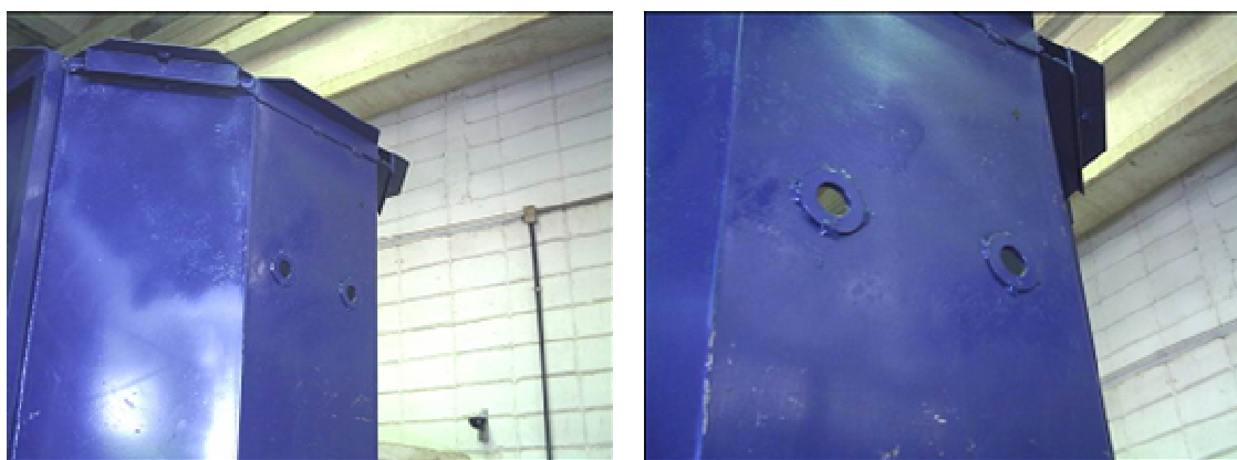
Figura B.14 – Furação lateral para a colocação do sistema de ancoragem dos estais.
