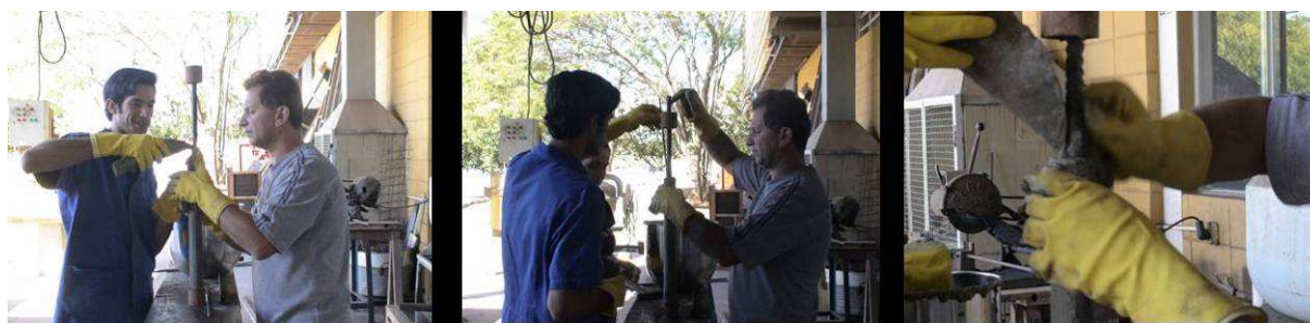
Figura 3.12 – Grauteamento a) Colocação do graute na horizontal, b) Adensamento com vareta e c) detalhe
