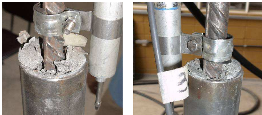
Figura 4.46 – Detalhe da ruptura do graute na extremidade não rompida
