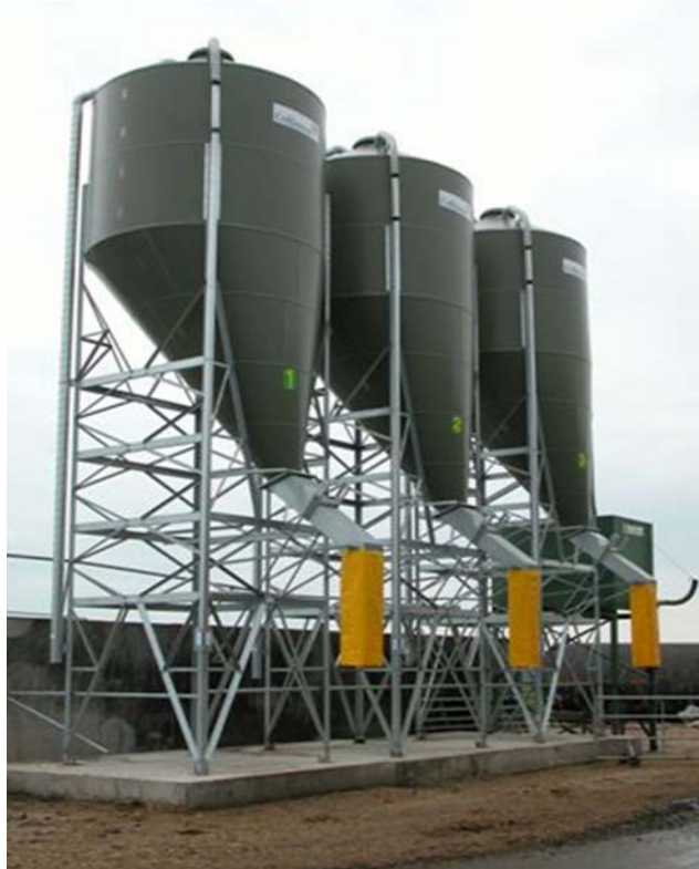
Figura 1.1 - Silos com descarga excêntrica.
