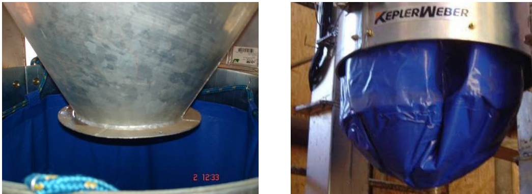
Figura 44 - Revestimento do silo piloto com lona plástica.
