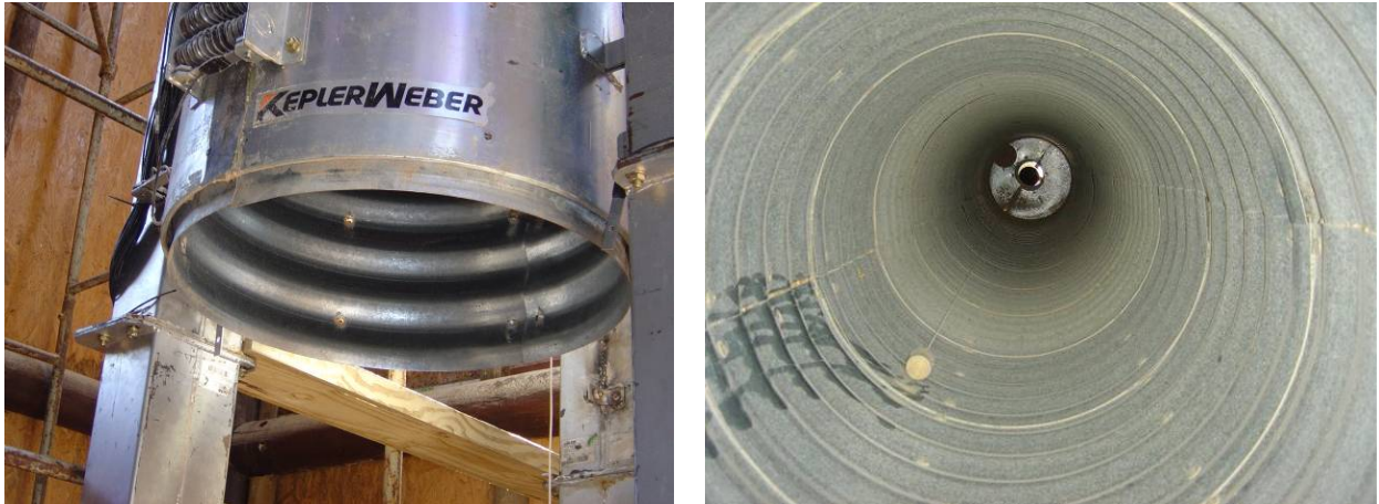
Figura 38 - Parede interna rugosa do silo piloto.
