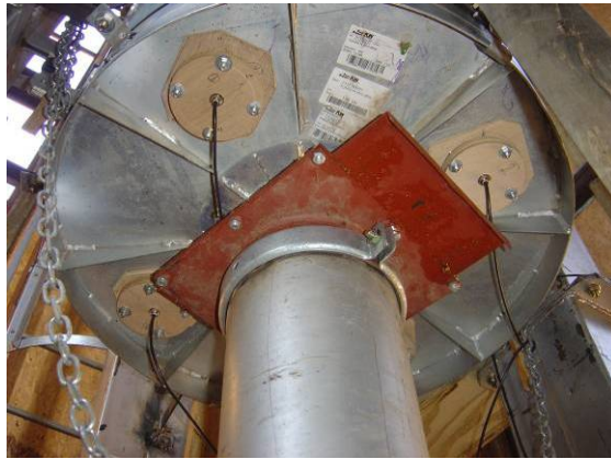
Figura 47 - Detalhes da boca de descarga do silo piloto.
