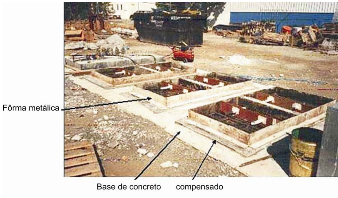
Figura 2.53 – Canteiro de fabricação dos modelos. Fonte: DCP (2000)
