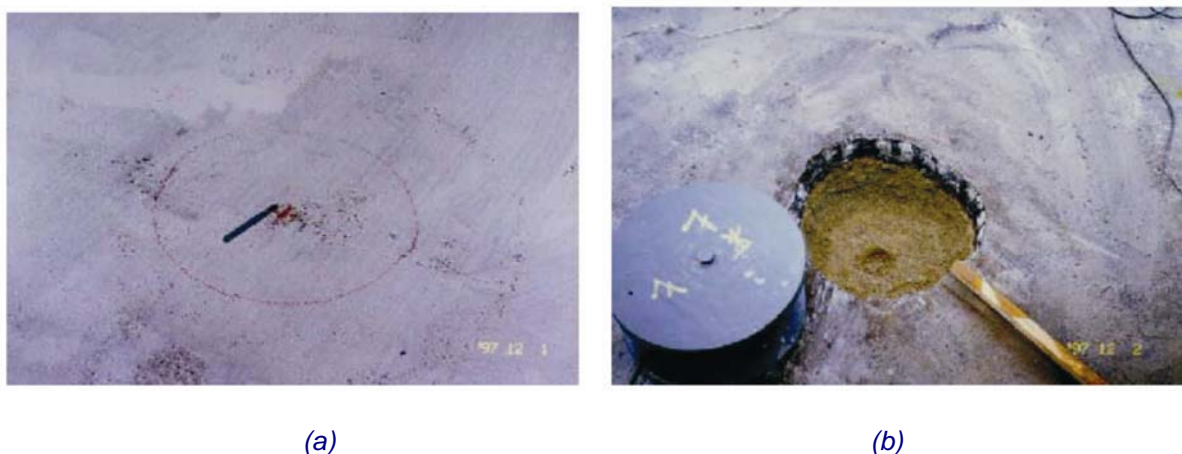
Figura 2.35 – (a) marcação da localização da célula de carga; (b) execução do buraco no concreto asfáltico e na base para embutir a célula de carga. Fonte: Silva (2001)
