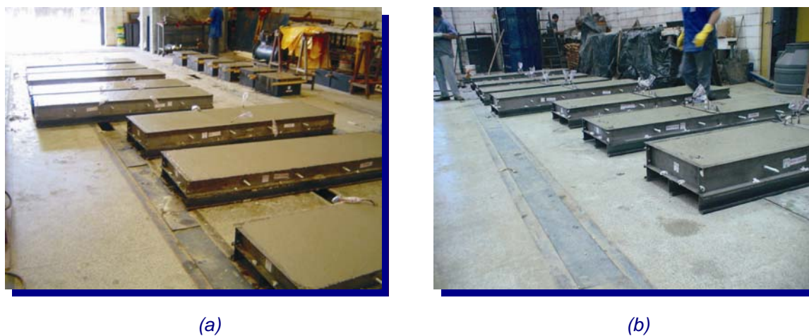
Figura 4.8 – Aspecto dos modelos após a concretagem: (a) junta serrada; (b) junta moldada
