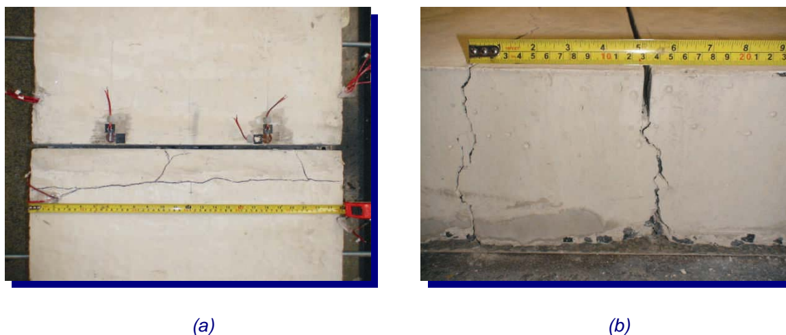
Figura 6.11 – Fotografias em escala para marcação de fissura: (a) vista superior, (b) vista lateral e força aplicada à esquerda da junta
