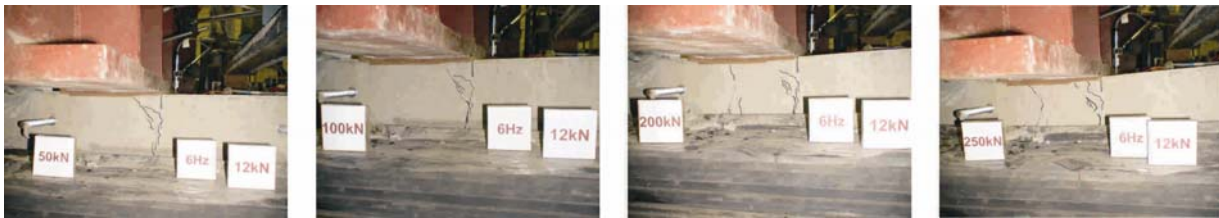
Figura 6.16 – Estágios de fissuração para o modelo JS12DMC em carregamento estático, após ser submetido a 300.000 ciclos de carregamento
