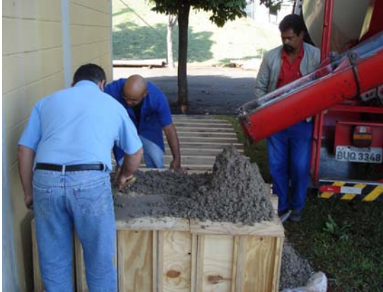
a) Concretagem dos corpos-de-prova mistos sendo realizada
