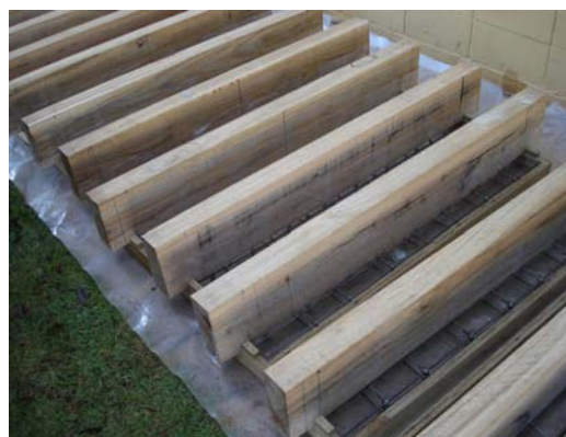
b) Vigas posicionadas para início da concretagem
