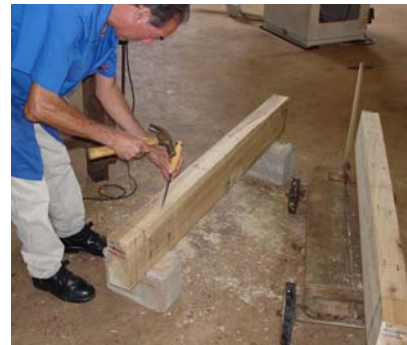
b) Marcação inicial dos furos
