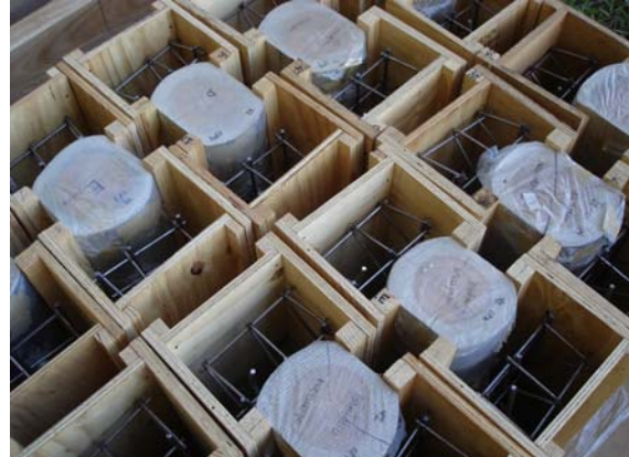
b) Vista dos corpos-de-prova mistos antes da concretagem
