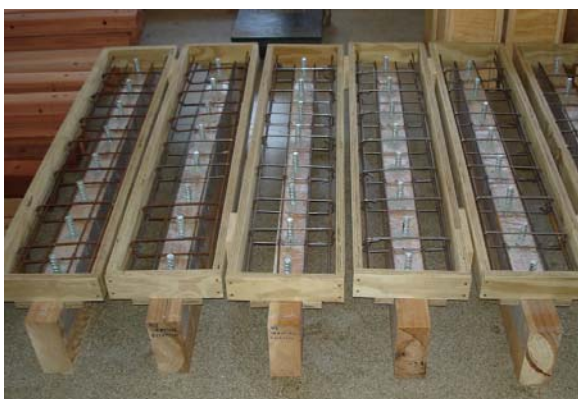
a) Vista das vigas com os detalhes das fôrmas e da armadura antes da concretagem
